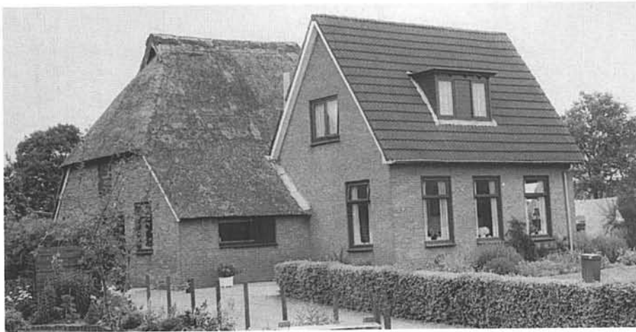
A. Samenwoegen van sterk verschillende bouwmassa's kan leiden tot een eindresultaat dat gedrochtelijk aandoet. Waar was hier de welstandscommissie?
