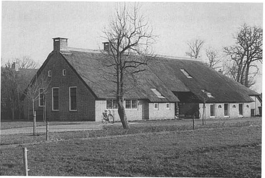
C: Bij de verbouwing van deze boerderij is de eenheid van woongedeelte en (voormalig) bedrijfsgedeelte behouden.
