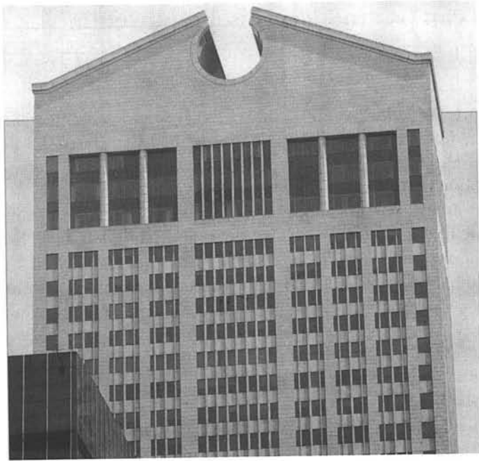
A.T. en T. gebouw in New York, Ph. Johnson & J. Burgee.
