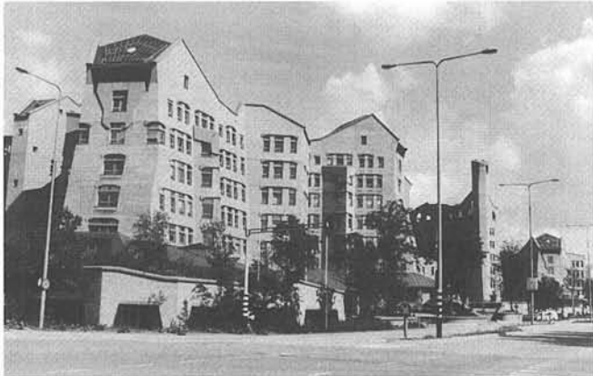
ING-gebouw Amsterdam Z.O.
