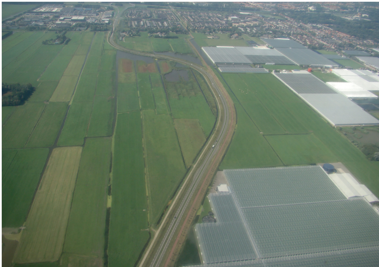
Luchtfoto van de N470 gezien richting Delft.
