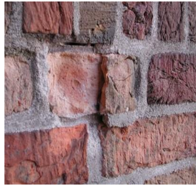
SPALLING
