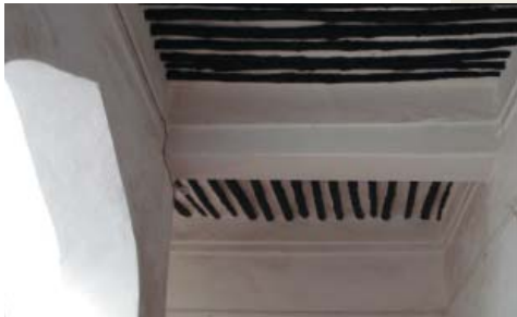
fig. 70 Boriti floor construction at Beit el Sahel
