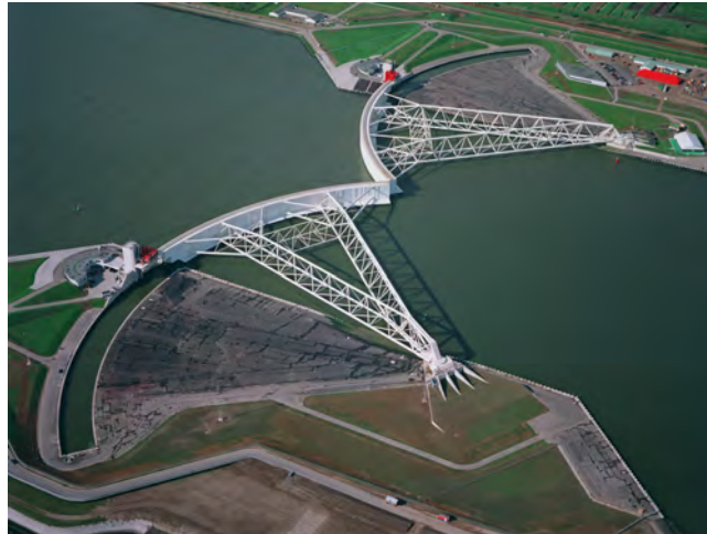
Figure 2.2: Maeslantkering while closed (van Eyck & Rijkswaterstaat, 1997)
