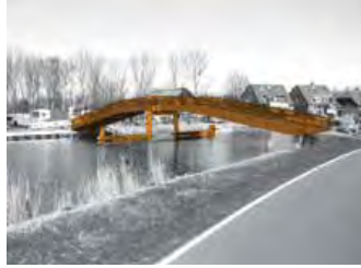
ILLUSTRATIE 7.98 Hoge brug over de Rotte.
