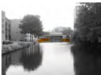
ILLUSTRATIE 7.35 De trechtervormige kade voor het gemaal.
