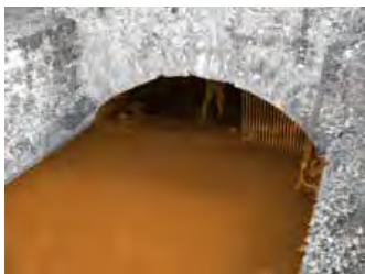
ILLUSTRATIE 2.3 Watertunnel, de ondergrondse kanalisatie.
