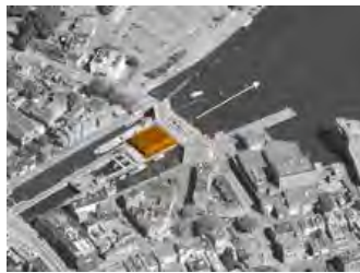
ILLUSTRATIE 4.11 Boezemgemaal Zaangemaal.
