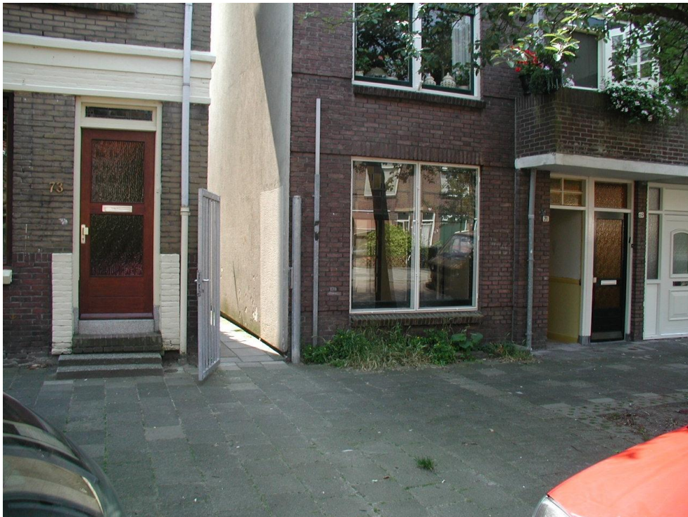
Figuur A.4 Huizen in Dordrecht met verschillende funderingstypen naast elkaar in de straat met verschillende zakking na verloop van tijd. De verhoging naar de voordeur bij het huis op palen is ontstaan doordat het huis niet is meegezakt met het maaiveld. Bron: Gemeente Dordrecht.
