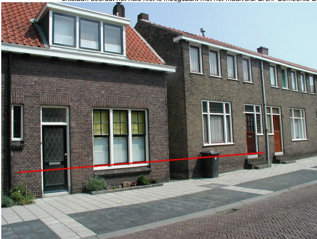
Figuur A.4 Huizen in Dordrecht met verschillende funderingstypen naast elkaar in de straat met verschillende zakking na verloop van tijd. De verhoging naar de voordeur bij het huis op palen is ontstaan doordat het huis niet is meegezakt met het maaiveld. Bron: Gemeente Dordrecht.
