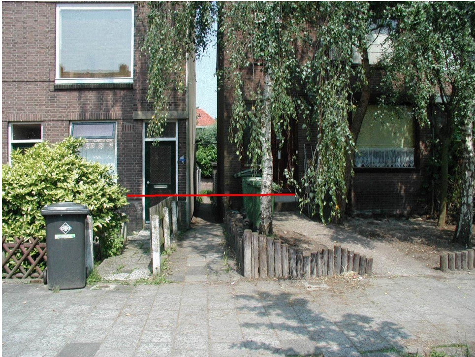
Figuur A.3 Huizen in Dordrecht met verschillende funderingstypen naast elkaar in de straat met verschillende zakking na verloop van tijd. De verhoging naar de voordeur bij het huis op palen is ontstaan doordat het huis niet is meegezakt met het maaiveld. Bron: Gemeente Dordrecht.
