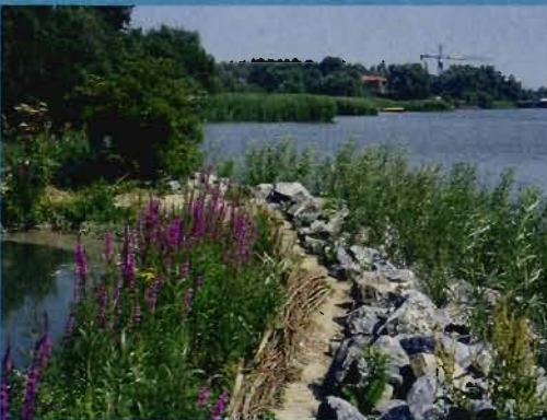
Een oever met een doorgroeiconstructie aan de Nieuwe Maas.
