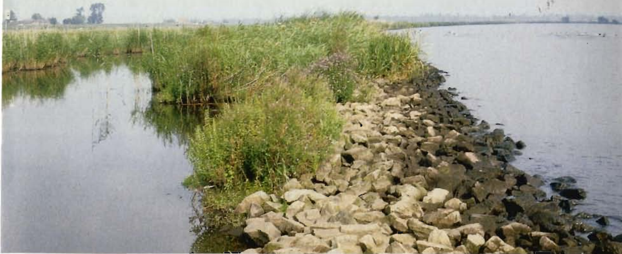
De oever aan het Zwarte Water bij Cellenmuiden: na 3 jaar.
