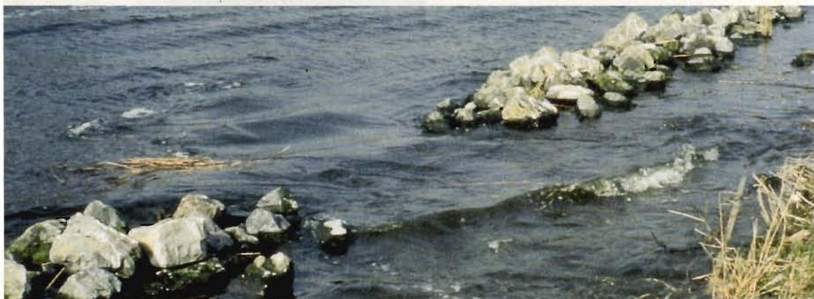
Schoorldam: vlak na aanleg.
