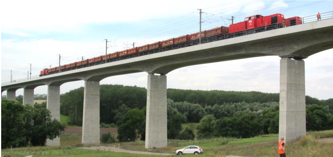
Fig. 10 —Freight trains on the Scherkondetalbrücke
