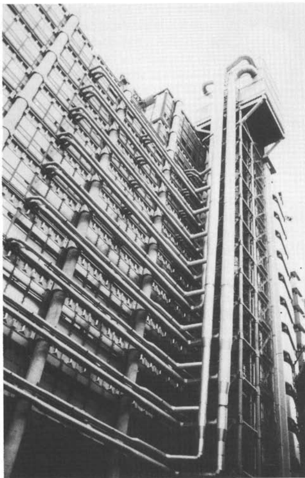
5.18. Luchtbehandeling vereist kanalen met een grote diameter. Bij het Lloyd kantoor in London zijn deze kanalen aan de gevel duidelijk zichtbaar.
