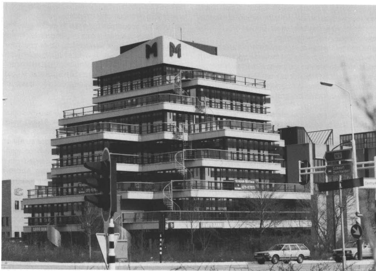
5.27. Bij een terrasvormig kantoorgebouw is geen glazenwassers installatie nodig (de Moel, Alkmaar, architect Vormer).
