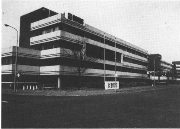
7.2. De verschillende functies borstwering, glas, zonwering zijn in de gevel afleesbaar. (Rijswijk, Plaspoelpolder, ontwerp Bleeker).
