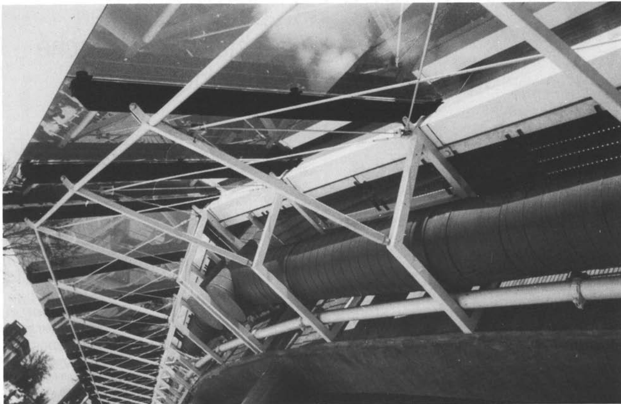
5.3. Het ventilatie systeem van het Brianclyff House in Farnborough is onder de "rok" duidelijk zichtbaar.
