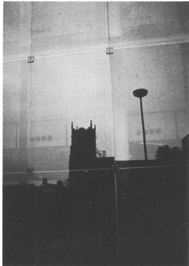
7.5. Een volledig glazen gevel past zich menigmaal bij de omgeving aan door kleur en spiegeling. (Ipswich, kantoor voor Willis Faber & Dumas, ontwerp Norman Forster, 1974).
