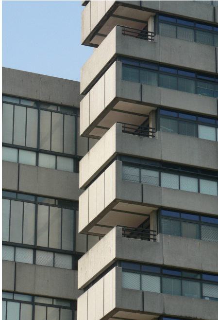
Figuur 13 Gevel van de hoogbouw waarin aan de linkerkant van de balkons de ateliergevel is te zien en aan de rechterkant van de balkons de kabinettegevel
