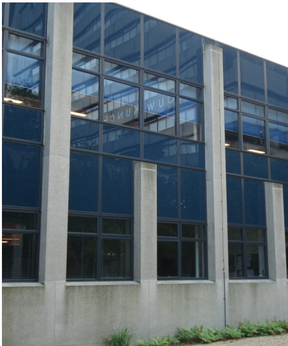
Figuur 14 Gevel van de laagbouw
