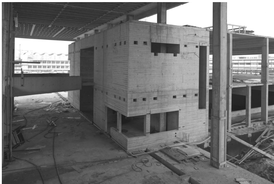
Figuur 117 Het Bouwkundegebouw tijdens de uitvoering
