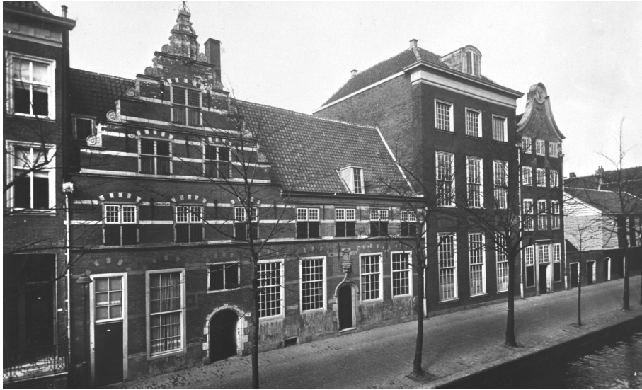
Figuur 111 Extérieur oude bouwkundegebouw aan de Oude Delft
