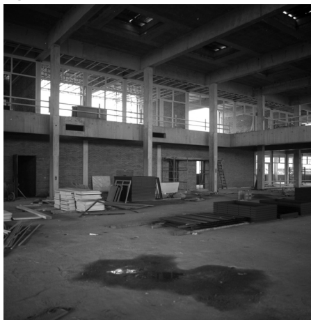
Figuur 41 Verschillende constructies dragen dak en verdiepingsvloer in de blokkenhal
