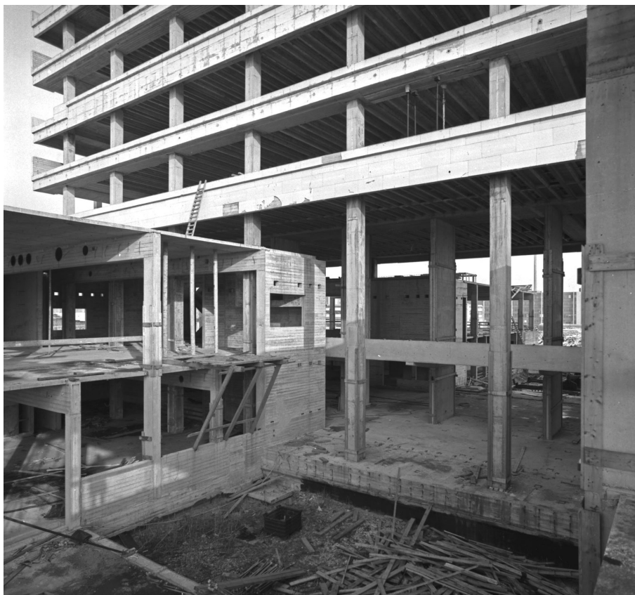
Figuur 118 Het Bouwkundegebouw tijdens de uitvoering
