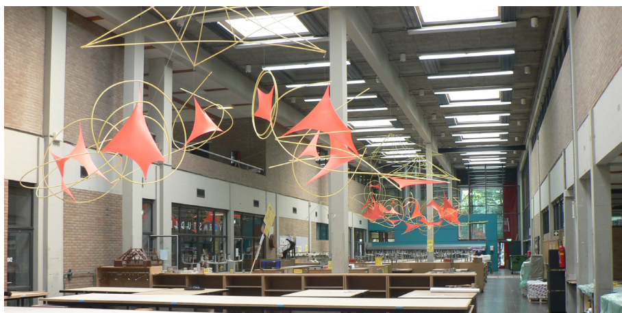
Figuur 32 Werkplaats met duidelijk onderscheid tussen dragende en niet-dragende elementen en daklichten
