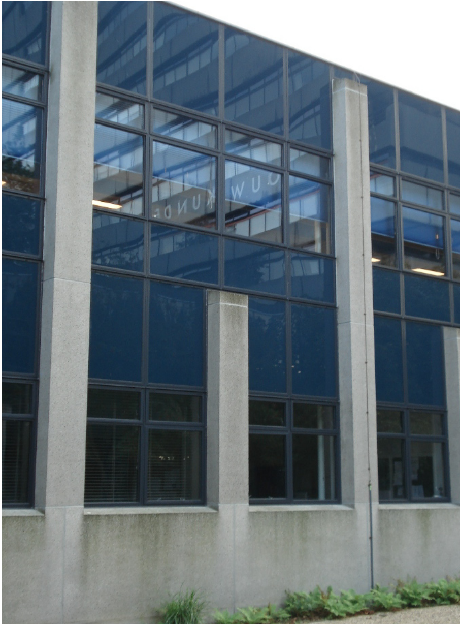
Figuur 52 De gescheiden dak- en vloer-constructie van de laagbouw is terug te zien in het gevelbeeld
