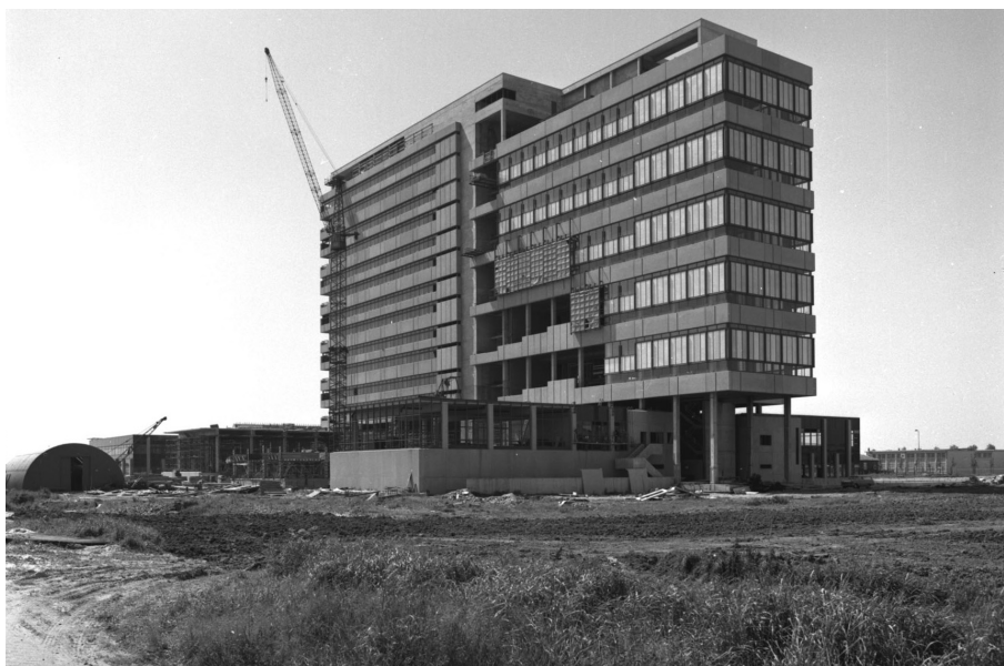
Figuur 119 Het Bouwkundegebouw tijdens de uitvoering
