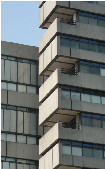
Figuur 92 Balkons aan de kopse gevel
