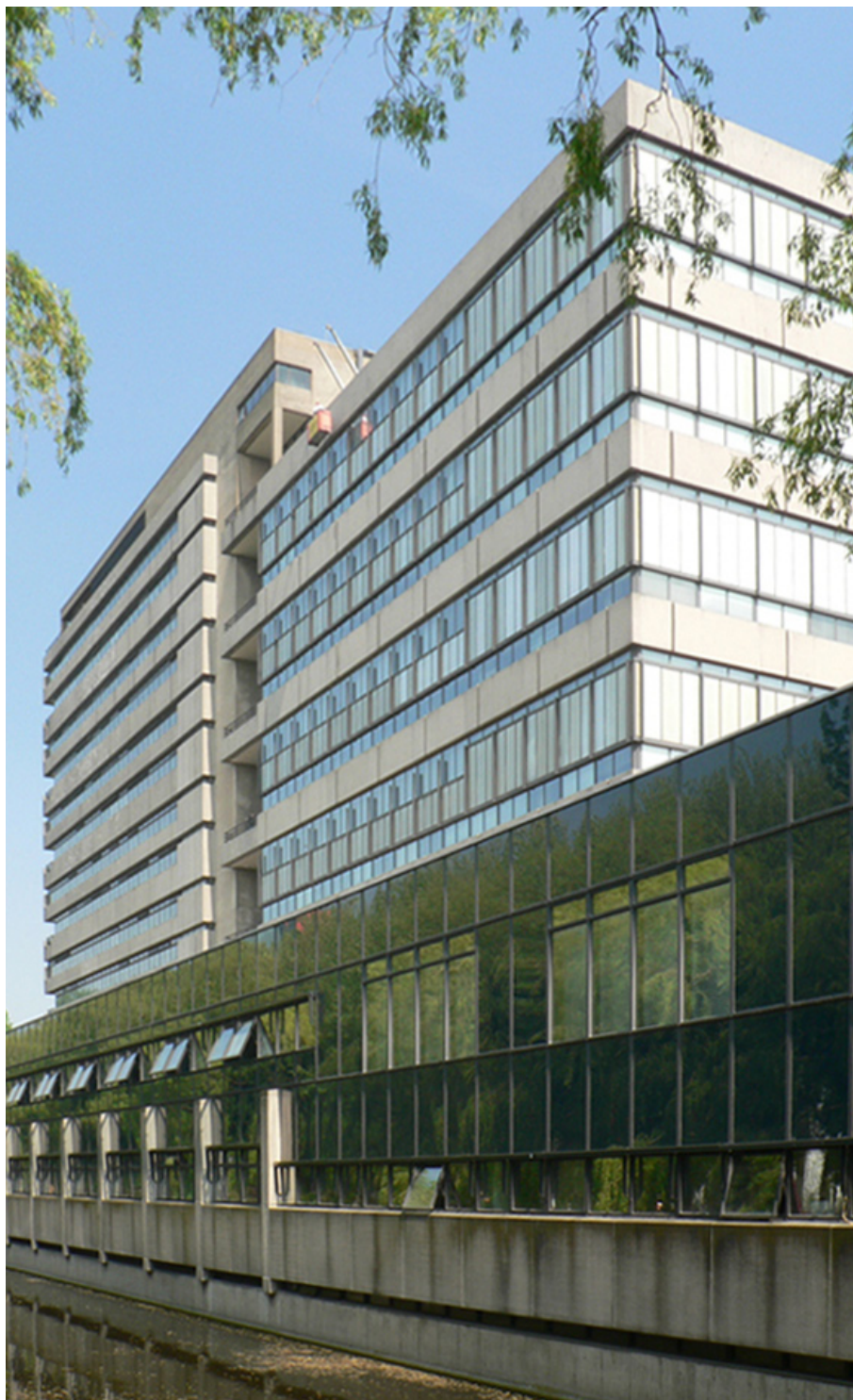
Figuur 7 Gebouw voor Bouwkunde Technische Universiteit Delft
