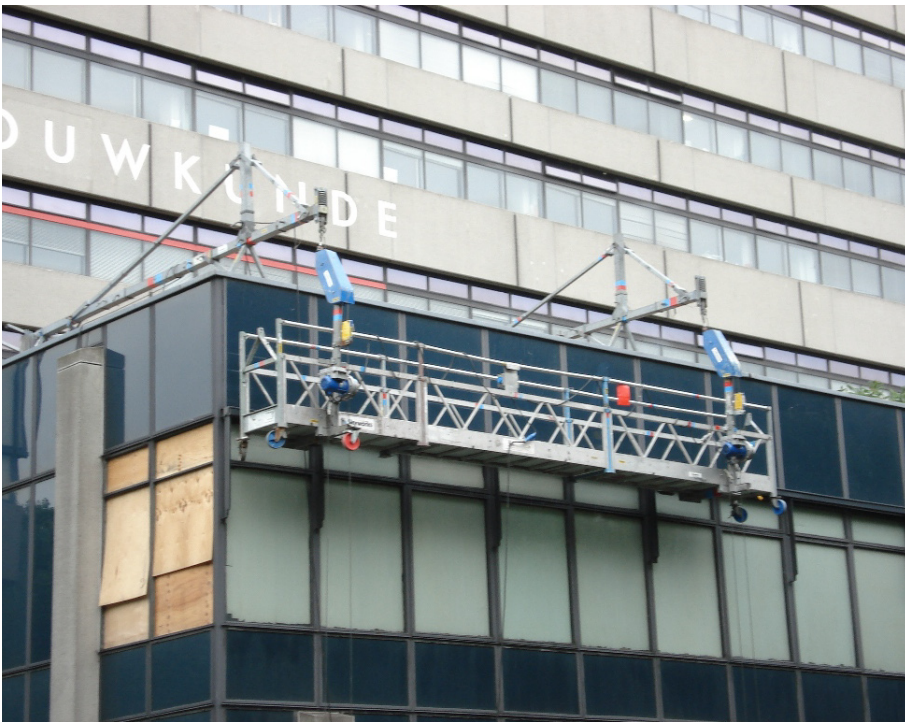
Figuur 23 Mobiele gondelinstallatie voor laagbouw
