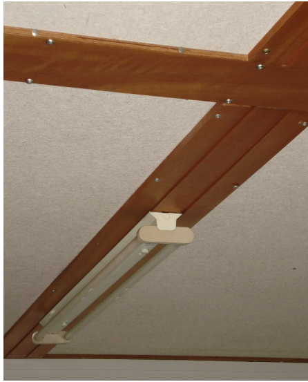
Figuur 17 Plafond van een kabinet
