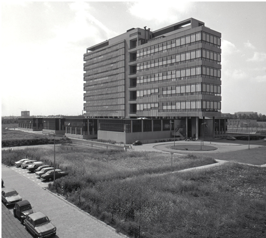
Figuur 123 Bouwkunde net na oplevering
