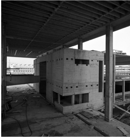
Figuur 37 Het gebouw in aanbouw
