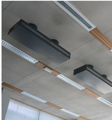
Figuur 42 Inblaas armaturen in de tekenzalen
