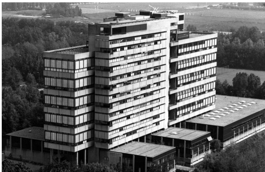
Figuur 6 Gebouw voor Bouwkunde, Technische Universiteit Delft
