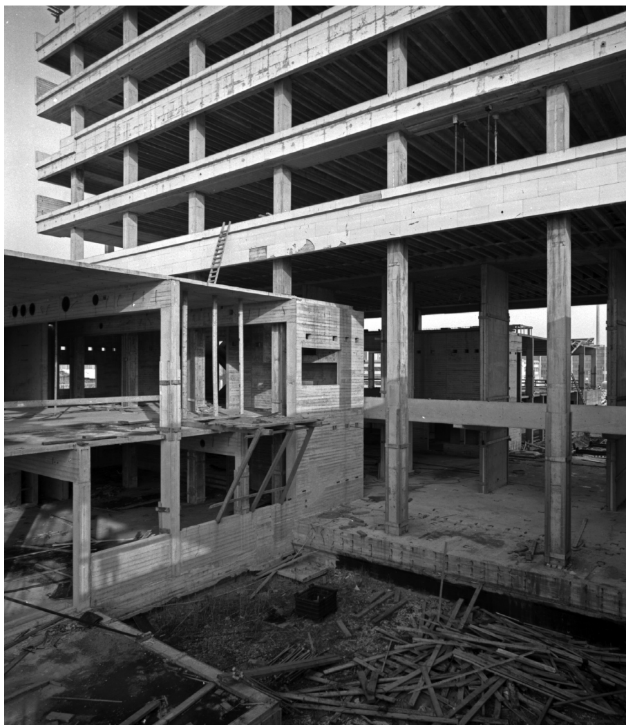
Figuur 43 Samenkomst van de draagconstructie van de laagbouw en van de hoogbouw (bron: Fotografische Dienst TU Delft faculteit Bouwkunde)
