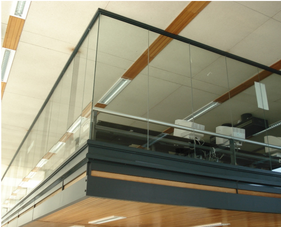
Figuur 70 De later aangebrachte glaswand op de entresols
