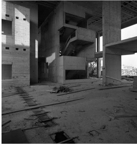
Figuur 38 Het gebouw in aanbouw
