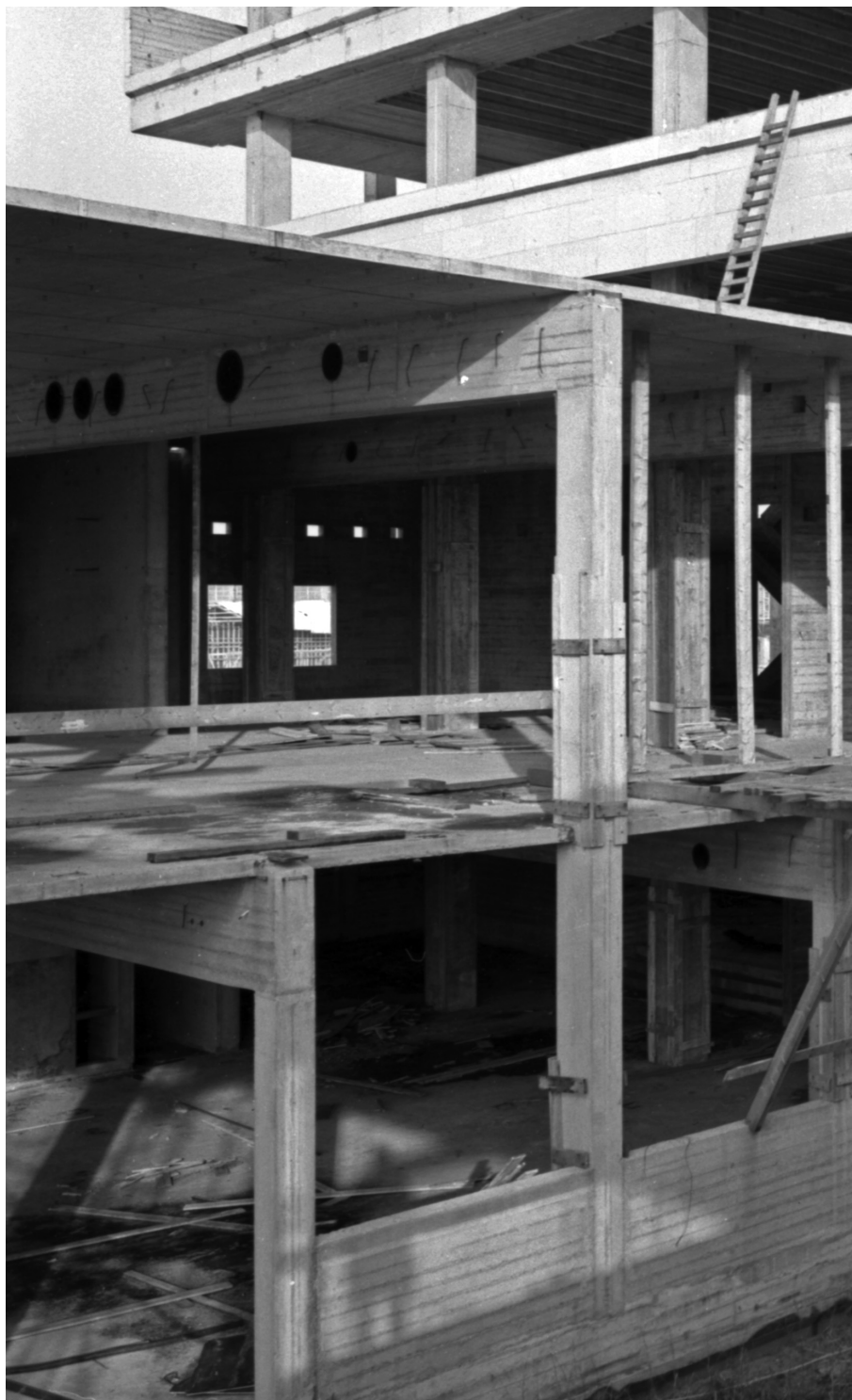
Figuur 53 Gescheiden constructie laagbouw
