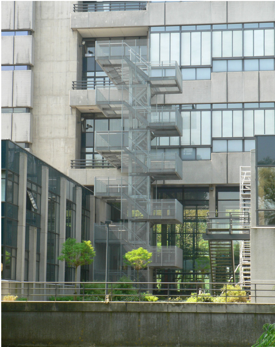
Figuur 96 Brandtrap aan de zijkant van het gebouw
