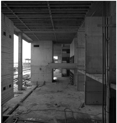
Figuur 39 Het gebouw in aanbouw
