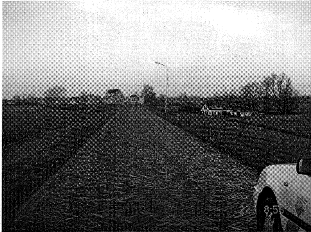
1. Dalemse overlaat: doorbraakpunt 12
