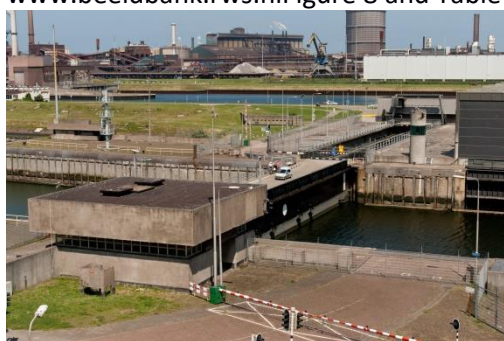
Figure 7 Rolling/sliding gate, www.beeldbank.rws.nl
