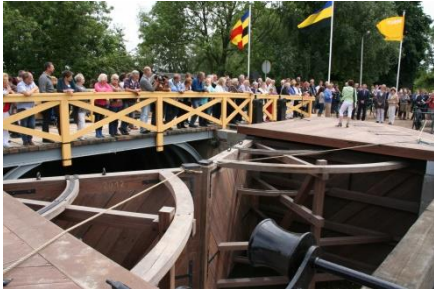
Figure 60 Wing gates, http://wordpress.mediarelease.nu/restauraties-waaiersluizen-en-taveerne-opgeleverd
