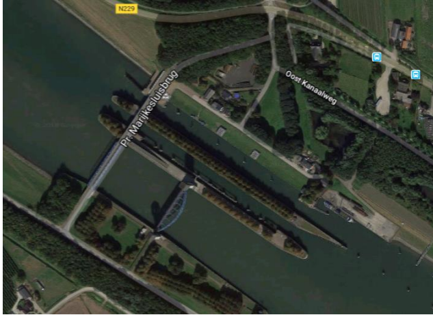
Figure 56 Prinses Marijkesluizen site
