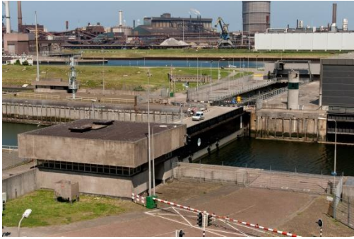
Figure 64 Rolling/sliding gate, www.beeldbank.rws.nl
