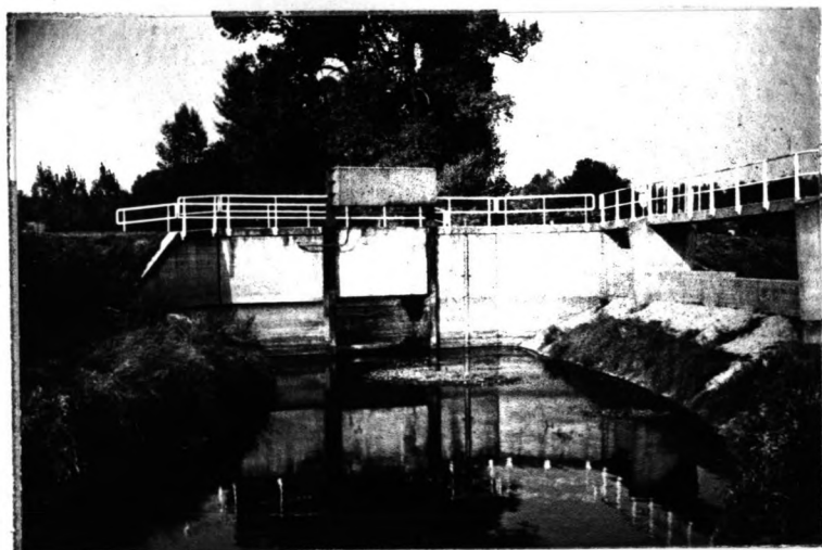
Figuur 5.2-2. Bovenstrooms aanzicht van het Verdeelwerk.
