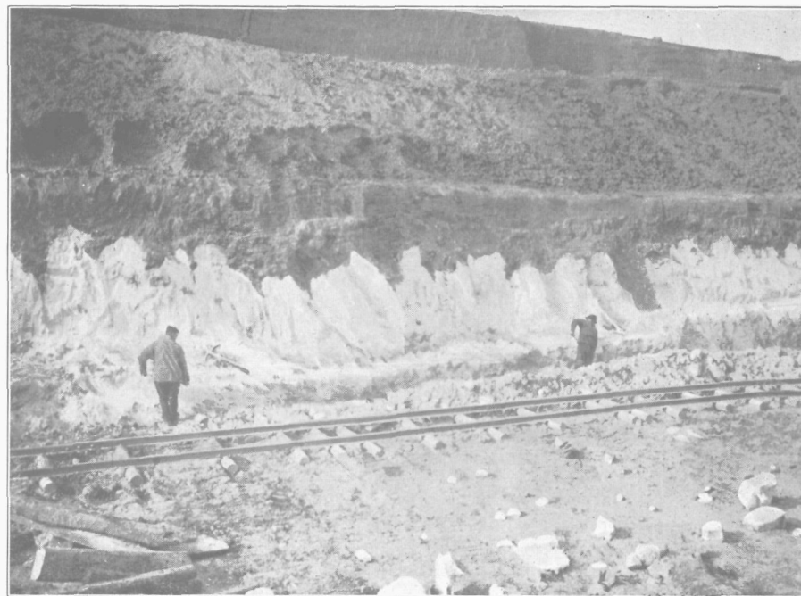
AUFLÖSUNG DER KREIDE AN DER LÖSSBASIS IM EISENBAHN-EINSCHNITT WESTL. DER KELDERGRÄFT.
