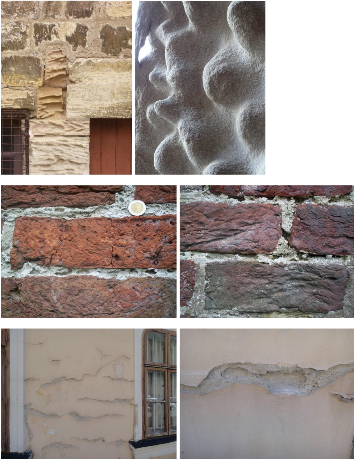
Fig. 7 (vervolg). Voorbeelden van zout schade. Bovenste rij: alveoli in links Savonnières kalksteen, Place St. Pierre 2, Bar le Duc (2010) en rechts Obernkirchener zandsteen, Nieuwe Badkapel, Scheveningen (2017). Middelste rij: alveoli in mortel, links aan de Laurentiuskerk in Baflo (2004), rechts aan de NH Kerk in Hoorn, Terschelling (2005). Onderste rij: zout schade aan pleister, Frantiskanske namestie 4, Bratislava (2014).
