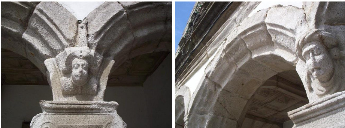
Fig. 8. Zout aantasting van graniet, Misericordia van Viana do Castelo (2004).
