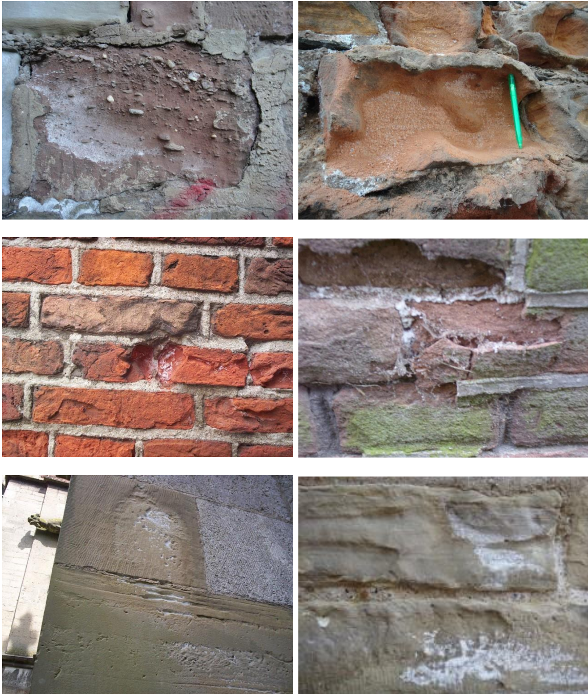
Fig. 7. Voorbeelden van zoutschade. Bovenste rij: verpoederen en sterk terugververen van Bontzandsteen, links aan de Römerbrücke in Trier (2012), rechts op de Schlossberg in Saarburg (2012). Middelste rij: links vergelijkbare schade aan baksteen van de Hooglandse kerk in Leiden (2005), rechts schade aan gehydrofobeerd baksteen metselwerk van pakhuis Zondag in Amsterdam (2008). Onderste rij: selectief ververen van Udelfanger zandsteen: de ene laag wel, de andere niet; links aan de pandhof van de Dom in Utrecht (2005), rechts aan de St. Jan in Gouda (2013).
