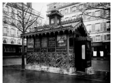
5.16 Charles Marville, Châlet de nécessité du marché de la Place de la Madeleine, Paris , c 1865. View towards rue de Sèze. Public domain.
