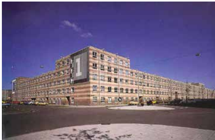
AFBEELDING 5.69 Woongebouw Blok 1 in Venserpolder in Amsterdam, 1980-82, architect Carel Weeber. Het blok komt zeer sober over. De twee kleuren baksteen vormen naast de één verdieping hogere hoeken de enige afwisseling.
