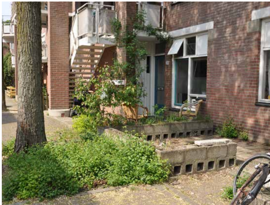
AFBEELDING 8.274 Betonlateien rusten op zichtbare consoles.
