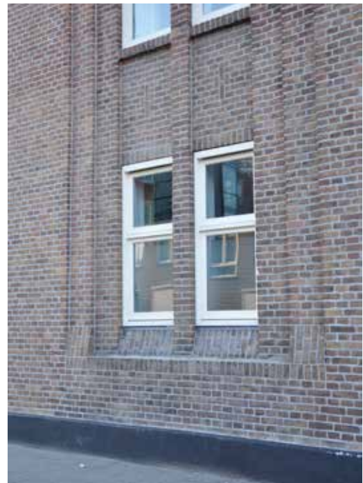
AFBEELDING 8.57 Detail van de articulatie van raamparteeien door het terugspringende metselwerk .
