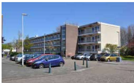
AFBEELDING 8.153 Foto hedendaagse situatie: alleen bij de trappenhuizen is het oorspronkelijke baksteen nog zichtbaar. Voor het gebouw ligt het pleintje dat nog steeds voor een groot deel voor voetgangers is.
