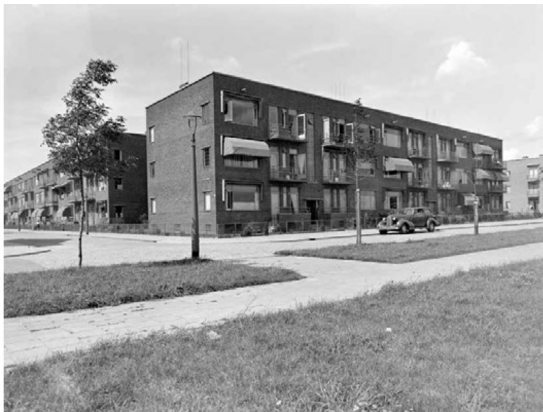
AFBEELDING 5.35 Woongebouw aan de Statensingel te Rotterdam, in 1937 gebouwd, architect Wim ten Bosch (1895-1967). Brede balkons aan de zuidgevel, en tevens de gevel naar de straat, laten het gebruik van prefab betonelementen zien. Een combinatie van staal en prefab betonnen lateien maakt veel grotere openingen mogelijk. Deze woningen behoorden in hun tijd tot de luxere woningen in de wijk Blijdorp.
