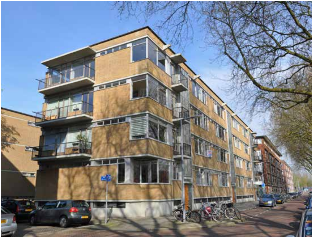
AFBEELDING 5.40 Woningbouw De Eendracht in Rotterdam, 1931-34, J.H. van den Broek. De woningen hebben grote vensterbanden, zelfs waar een wand van metselwerk geplaatst werd loopt de band als een hoge vensterband nog door.
