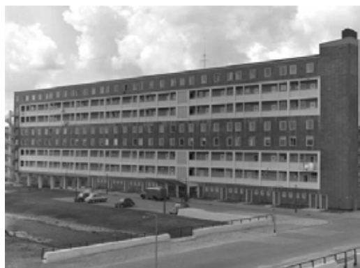
AFBEELDING 5.53 Een galerijgebouw in Slotershof in Amsterdam, in 1958 opgeleverd, architect J.F. Berghoef.
