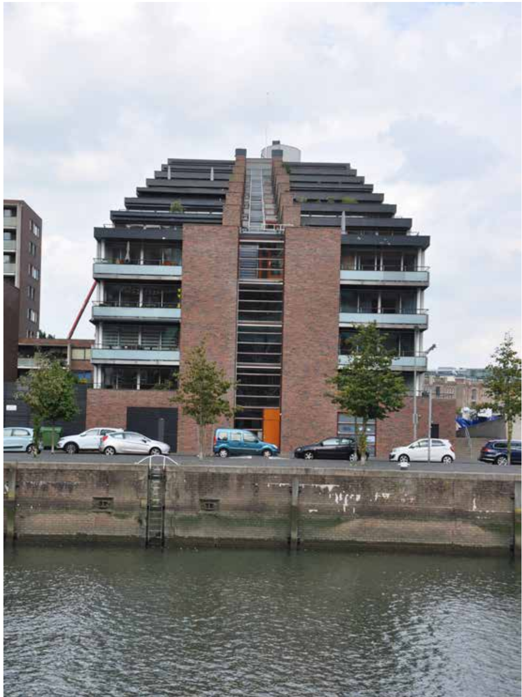
AFBEELDING 8.309 De kopgevel aan de Spoorweghaven.
