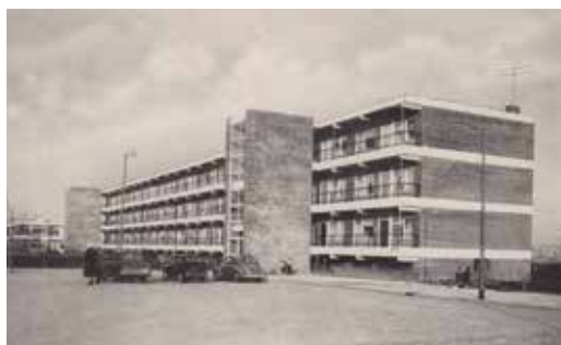
AFBEELDING 8.152 Foto vroeger: de betonranden zijn in het zicht, de gevel is van baksteen gemetseld.
