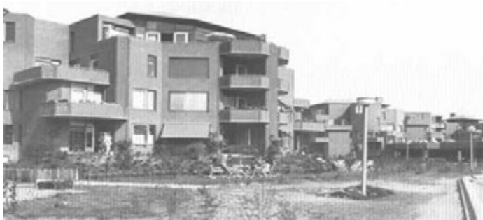
AFBEELDING 6.34 het Oostgaarde-project in Capelle a/d IJssel. De gevel reageert op de open verkaveling en de collectieve tuinen door zelf een overgangszone te worden, balkons zijn half of helemaal uitstekend, het gebouvolume springt terug om ruimte voor private dakterrassen te bieden en er ontstaan door de verdraaiing van de volumes nissen voor een beetje meer privacy ten opzichte van de collectieve tuin.
