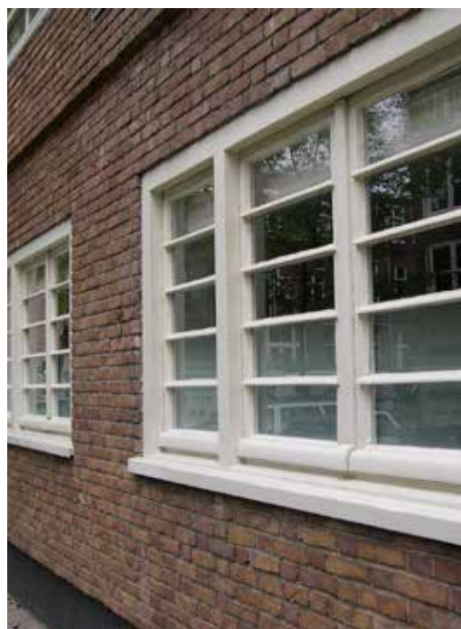
AFBEELDING 8.107 De openingen van de kelderimte.
