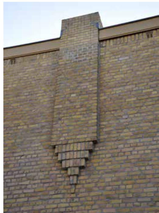
AFBEELDING 8.71 Detail in de gevel.
