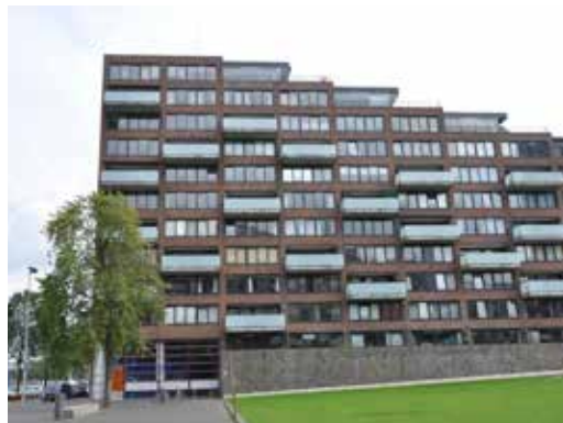
AFBEELDING 8.320 De gevel van Blok 2B naar Loods 24.
