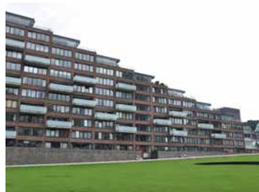
AFBEELDING 8.321 De gevel van Blok 2B naar Loods 24.
