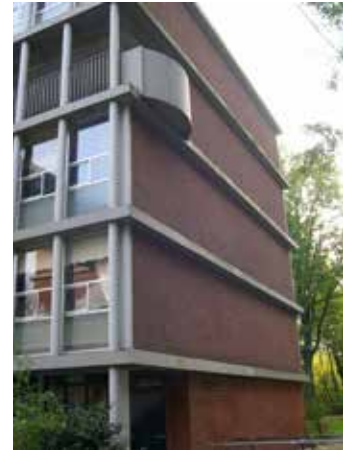
AFBEELDING 8.184 detail van de kopgevel.
