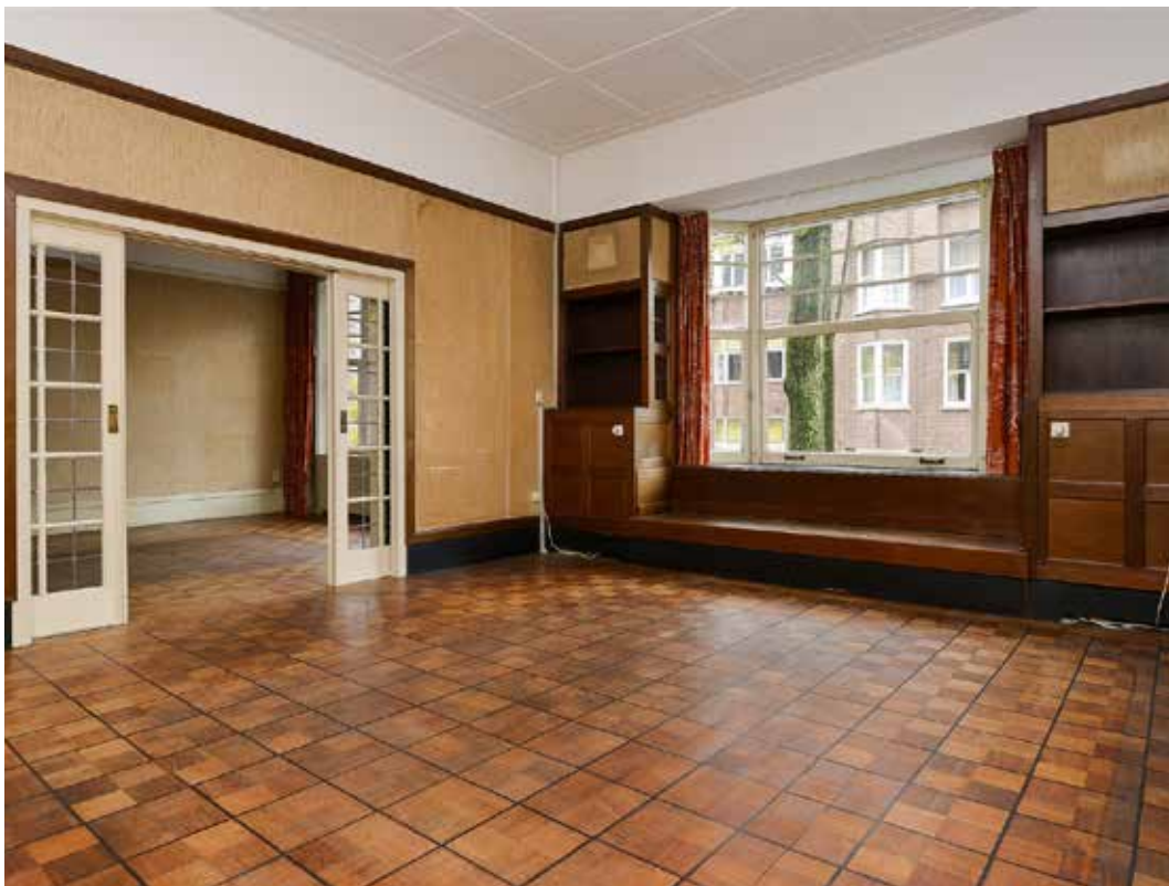
AFBEELDING 8.95 De diepe negge van de erker geeft ruimte voor een zitplaats.
