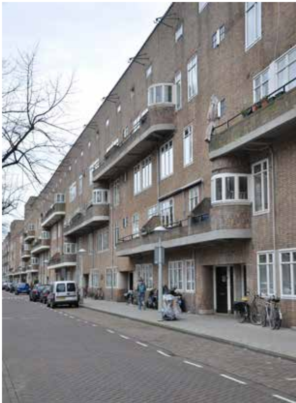
AFBEELDING 6.25 Woningen aan de Vrijheidslaan (vroeger Amstellaan) in Amsterdam, gebouwd 1923 door architect De Klerk. Wij zien een trottoir met ingangen die een trede hoger liggen en in een nisje terugspringen; in de straat uitkragende elementen.
