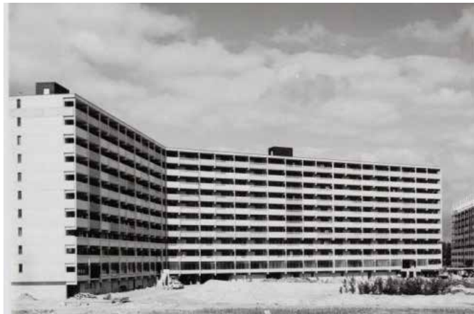
AFBEELDING 7.43 De Bijlmermeer in Amsterdam, gevel woonkamerzijde, 1962-1973.
