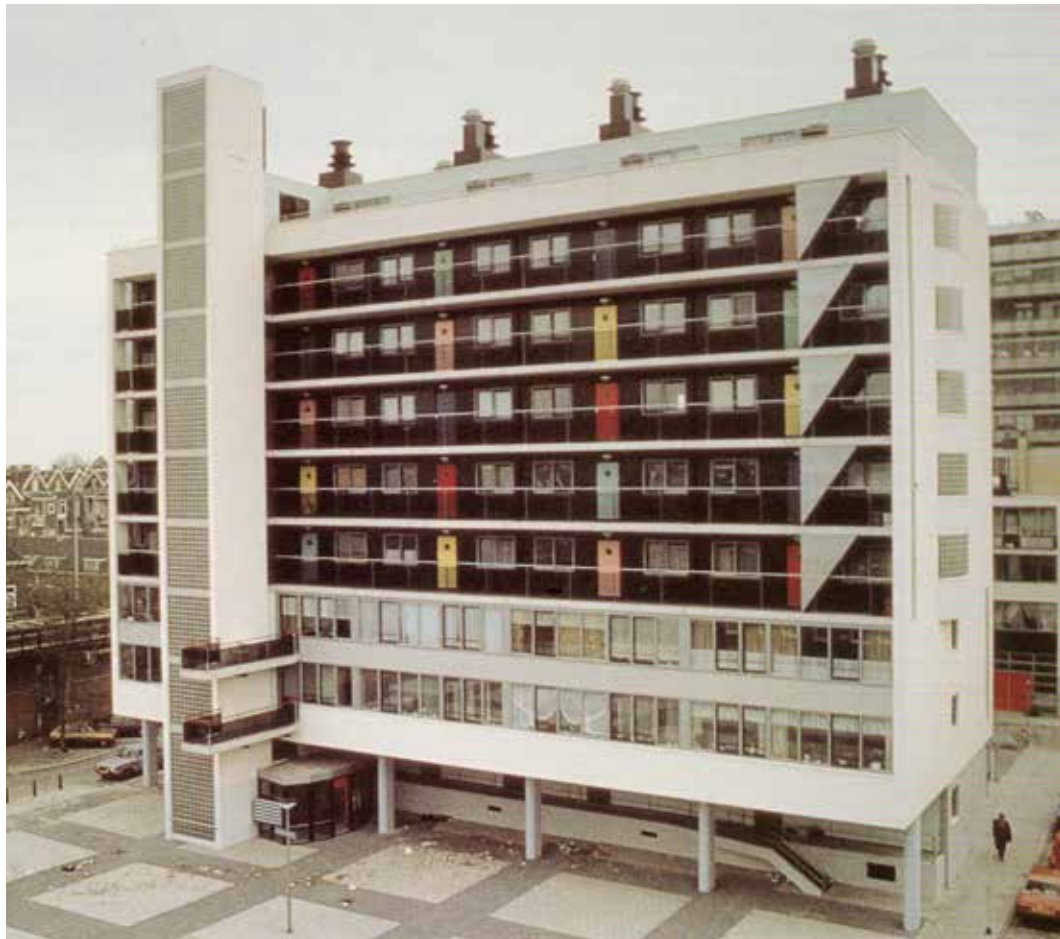
AFBEELDING 5.74 Woongebouw in de Agniesebuurt in Rotterdam, 1984-88, DKV Architecten; De foto laat de gevel van het negen lagen hoge gebouw aan het plein zien. De beganegrondwoningen worden vanaf een plint via een galerij ontsloten. Daarvoor bevindt zich een arcade. Hierdoor is een overgang van publiek naar privé gemaakt. De laagbouw in de wijk is achter dit gebouw nog net in beeld.
