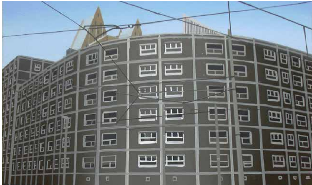
AFBEELDING 6.44 De Zwarte Madonna in Den Haag, een woonblok voor meer dan 300 huurwoningen en enkele winkels, 1982 door Carel Weeber gebouwd. Inmiddels gesloopt.
