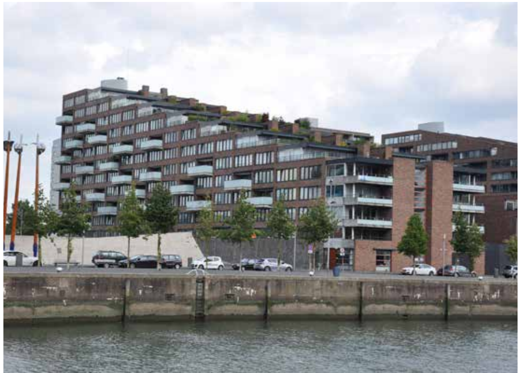
AFBEELDING 8.292 Blick op de zuidwestgevel van Blok 2B met de dakterrassen en de corridor in beeld.
