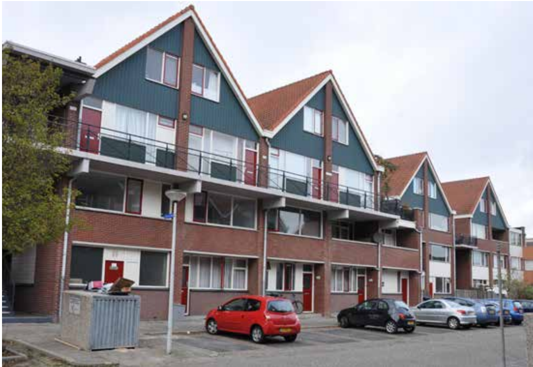
AFBEELDING 8.226 Na de renovatie – Straatgevel Blok C.
