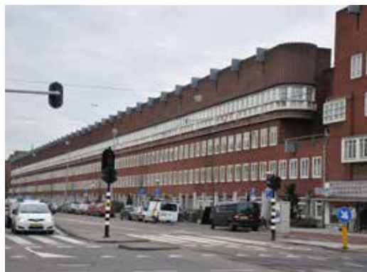
AFBEELDING 6.21 Woningen aan de Hoofdweg in Amsterdam, 1927 van architect Wijdeveld. De geleding van de gevel gebeurt door het uitkragen van penanten op de begane grond en toevoeging van hijsbalken aan de dakrand. De derde verdieping springt enkele centimeters naar voren. Hierdoor wordt een suggestie van een beschutte straat gewekt.
