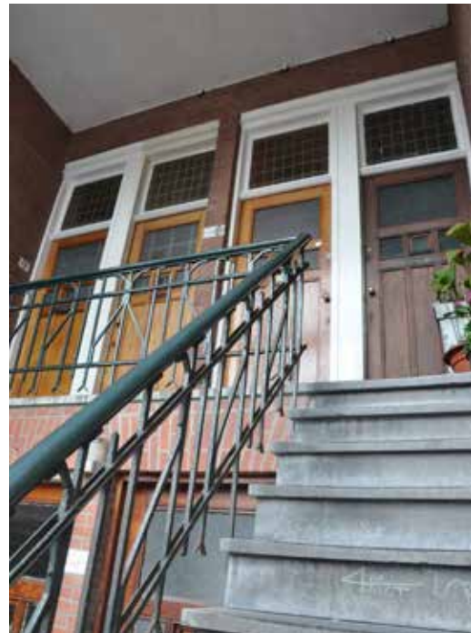
AFBEELDING 8.19 Bordes op de 1e verdieping en de deuren.
