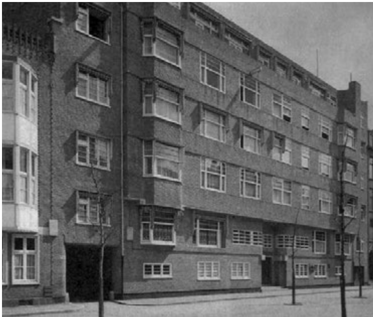
AFBEELDING 5.36 Huis Oldenhoek in Amsterdam, in 1925-26 gebouwd, architect Warners. Dit gebouw is een deel van een blokbebouwing. Twee naar voren springende erkers (op de foto is de linke erker in beeld) markeren de zijwaartse begrenzing van het gebouw vanaf de eerste verdieping. Links bevindt zich een doorgang naar een binnentuin waar een tennisbaan gesitueerd is. De bovenste verdieping springt – met uitzondering van de erkers – terug zodat er een balkon ontstaat, en tegelijkertijd een afsluiting. De entree ligt in het midden, horizontaal lopende vensterbanden lopen in een ronding naar de iets terugliggende zijwand van het open entreeportaal.
