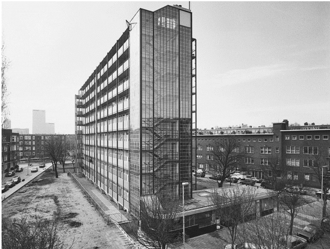
AFBEELDING 8.115 Galerijzijde en trappenhuis .
