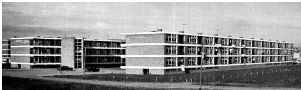
AFBEELDING 8.157 De tuingevel in het zicht. Opvallend zijn de horizontale betonranden die zelfs aan de kopgevel doorlopen.
