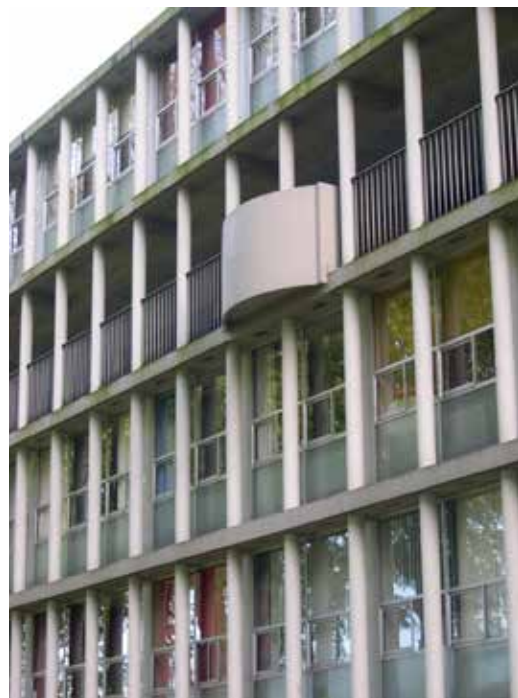
AFBEELDING 8.194 Detail kolommen en borstwering.
