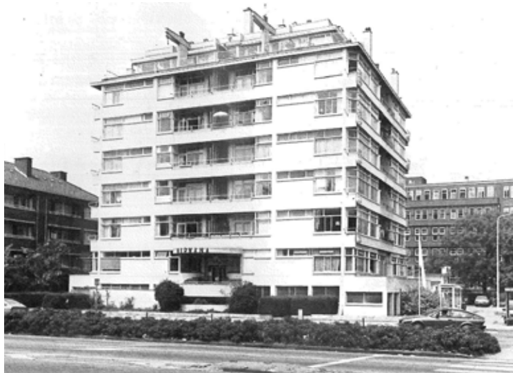
AFBEELDING 5.37 Nirwanaflat, in 1926-29 gebouwd, architecten B. Bijvoet, J. Duiker en J.C. Wiebenga. Een stedelijke toren als collectief woongebouw met een ruim collectief trappenhuis in de kern van het gebouw. De Nirwanaflat is de eerste gestapelde woningbouw in Nederland in de vorm van een toren. In de eerste studies die 1927 in het Bouwkundig Weekblad gepubliceerd werden, liepen de balkons als een extra laag helemaal rond de toren. In de uitvoering is dat veranderd.
