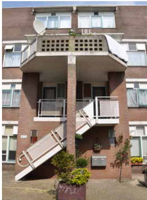
AFBEELDING 10.5 Entreegebied zuidzijde Haarlemmer Houttuinen oorspronkelijk.
