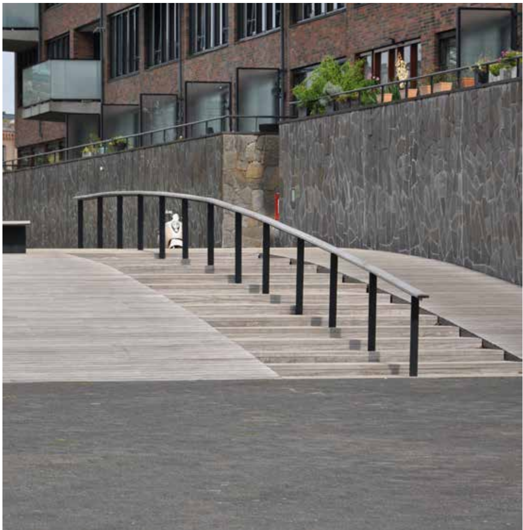
AFBEELDING 8.324 De weg naar de centraal gelegen ingang wordt door een helling en trap begeleidt.
