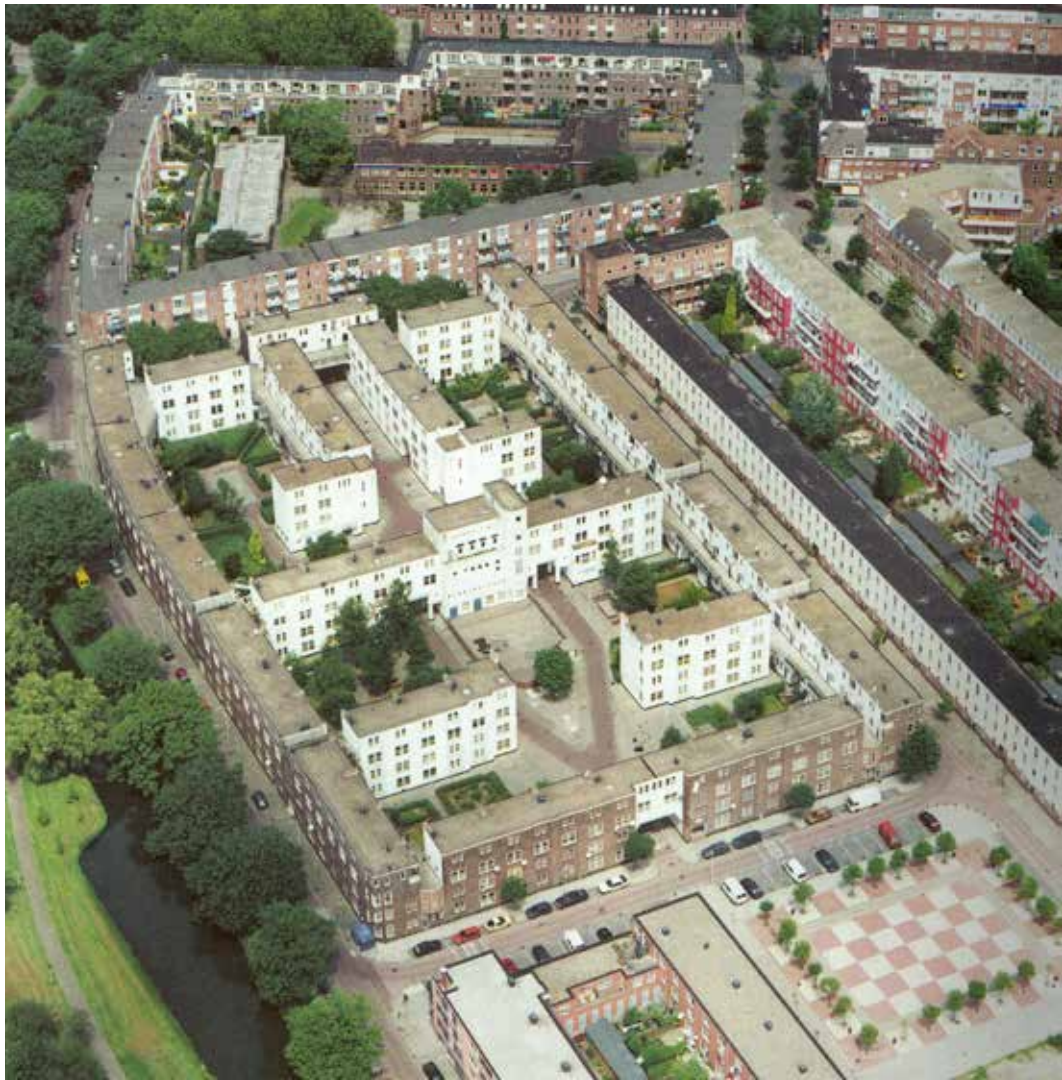
AFBEELDING 8.43 Luchtfoto van het Justus van Effencomplex. Aan de zuidkant is de poort aan de Jan Luykenstraat te zien. Links in het westen is de Spaansebocht, rechts in het oosten is de Pieter Langendijkstraat. Aan de noordkant de Potgietierstraat.
