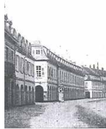
AFBEELDING 6.17 Arcaden met erboven woningen te Karlsruhe.
