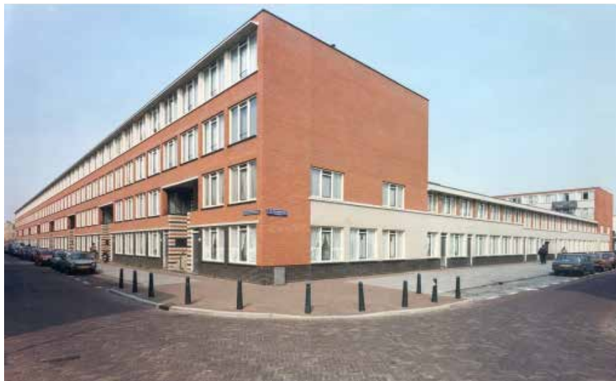
AFBEELDING 5.79 Woningen Jacob Marisstraat in Den Haag, 1987-88. Geurts & Schulze.
