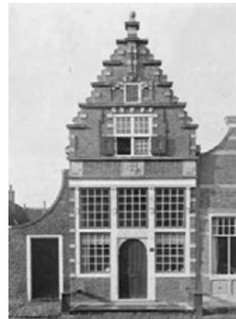
AFBEELDING 7.8 Voorgevel van een woonhuis in Enkhuizen in 1623. Een centraal gelegen entree voerde naar het voorhuis en naar de woonruimte erachter en erboven.
