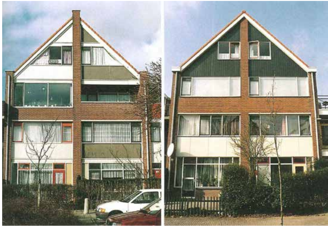
AFBEELDING 8.222 Voor en na de renovatie.
