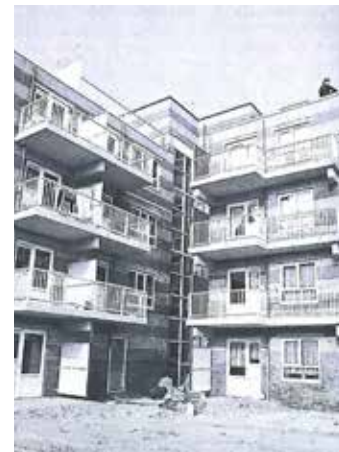
AFBEELDING 5.70 De binnenzijde heeft balkons en als er twee woningen een balkon delen, is halverwege een privacyscherm geplaatst.
