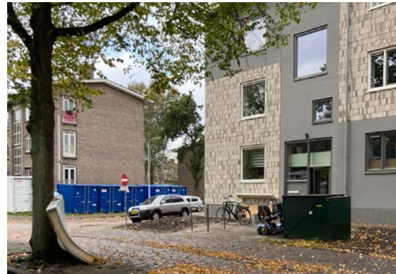
Figure 2.24 Transformed 'portiek' flats
