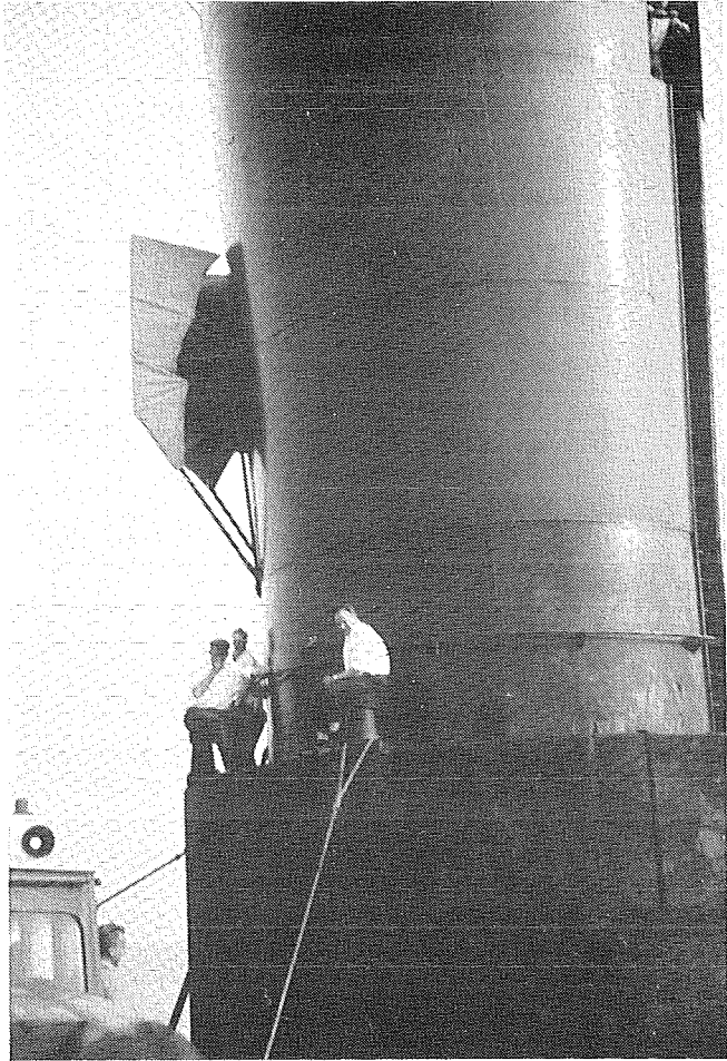
Meetstation hydrostatische waterpassing vuurtoren Aussenweser door de afd. NAP in 1966.
