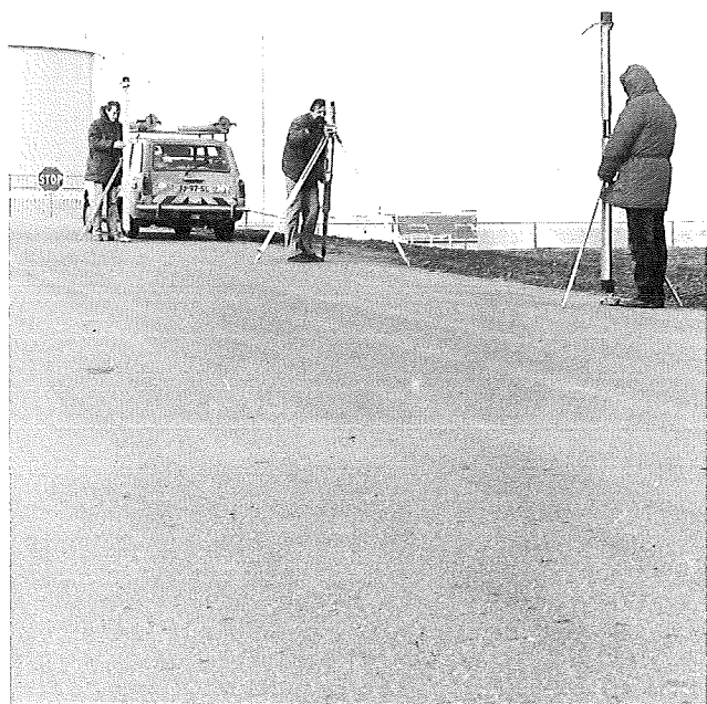
De Meetkundige Dienst van de Rijkswaterstaat aan het werk: Optisch waterpassen in 1985.
