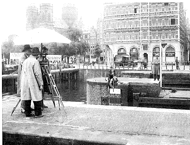
Het instrument van Hildebrand en het met behulp daarvan maken van de aansluiting aan het NAP te Amsterdam.
