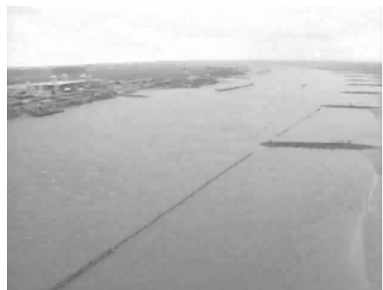
Abbildung 14 – Abtrennen von Bühnenfeldern. Links: Schema, Rechts: Anwendung bei Ochten
