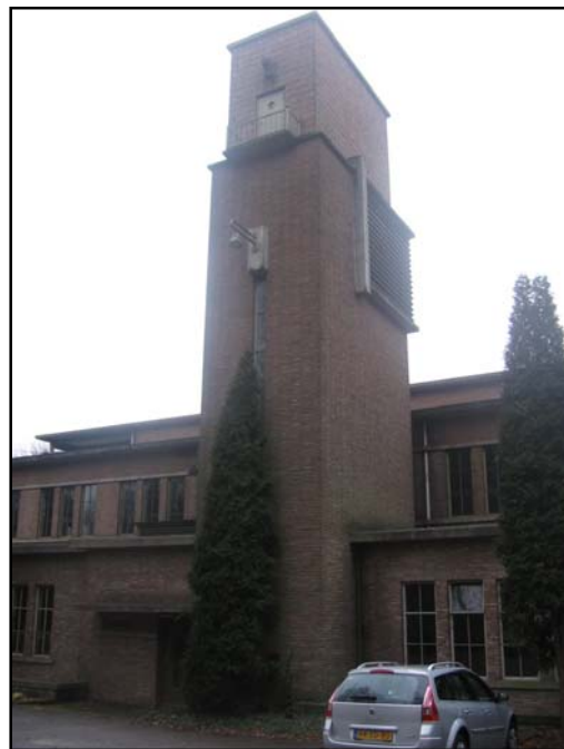
Afbeelding 26: Gebouw B16, 'De Zoeten Laboratorium'
