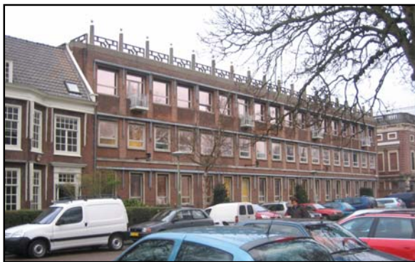
Afbeelding 14: Te slopen gedeelte provinciehuis
