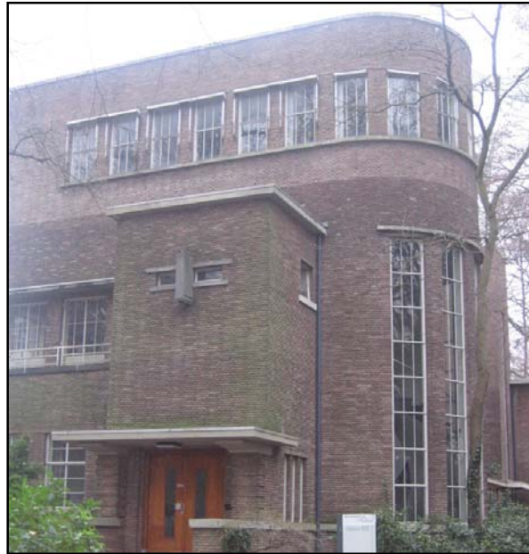
Afbeelding 28: Gebouw B30, 'Voorlichtingsgebouw'
