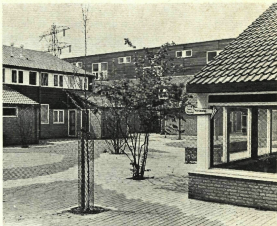
Ruimtelijke stede- bouw in Zwijndrecht
