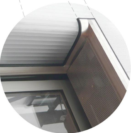
aluminium profielen volgen de gevel lijn
