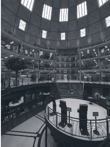
Haarlem Panopticon, designed by | progettato da Willem Metzelaar (1901), renovation project by | progetto di recupero di Buro van Stigt (2021). Ph. Đorđe Bulajić, Stavros Kousoulas, 2024.
