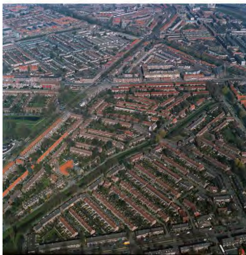
Afbeelding 10.1.4 Stedenbouwkundige plananalyse van het ontwerp van Hein Berlage, Marinus Granpré Molière en Piet Verhagen voor een deel van de wijk Vreewijk in Rotterdam uit 1913-1920 (luchtfoto onder). De analyse (boven) richt zich op de functionele en ruimtelijke aspecten van de overgang tussen de woningen en de straat. Er is gebruik gemaakt van combinaties van verschillende typen tekeningen, zoals een fragment van het stedenbouwkundig plan, woningplattegronden en daarboven een axonometrische tekening van de bouwmassa (linksboven), en een foto van de straat gemonteerd in een sterk geschematiseerde doorsnede met daaronder een plattegrondfragment (rechtsboven).
