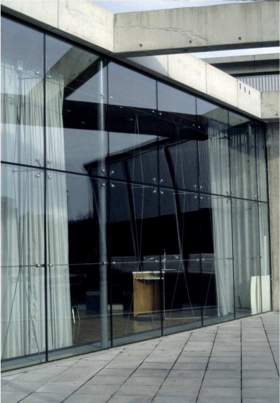
FIG. 58 De kozijnloze glasgevels van de Nai lobby, met de gladde glasoppervlakken aan de buitenzijde en de mechanische verbindingssystemen zichtbaar achter het glas
