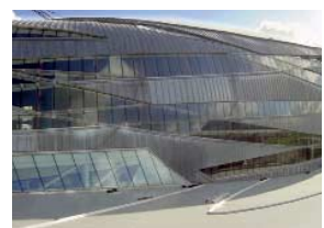
FIG. 39 Achterzijde 'spaghettigevel' van stadhuis Alphen met voor het eerst in de geschiedenis van de productontwikkeling doel bewust geëngineerde getordeerde dubbel glaspanelen.
