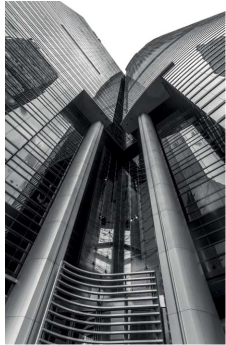
FIG. 48 Citicorp skyscraper in Hongkong met 32 m hoge kozijnloze glasgevel van Octatube, tyfoonbestendig: 5,5 kNm 2 winddruk [arch. Rocco Design]
