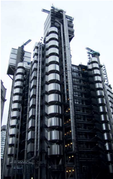
FIG. 47 Lloyds gebouw in Londen, [arch Richard Rogers]
