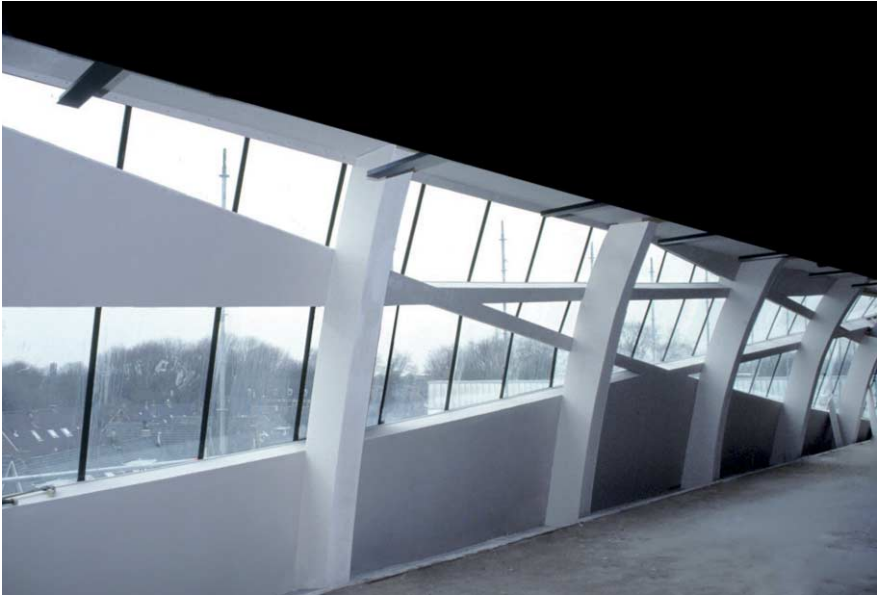
FIG. 20 Binnenaanzicht van de achtergevel van het stadhuis in Alphen aan de Rijn met de 'spaghetti'gevelstroken bestaande uit koud getordeerde gelamineerde dubbelglaspanelen die stevig in U-profielen zijn gezet onder en boven met kitvoegen tussen de panelen, zie ook fig. 21 en 31.
