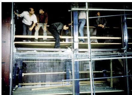
FIG. 49 Mislukte TNO-proef voor de glasgevel van Citicorp Hongkong, omdat een bovenste glaspaneel tevel was gezakt uit het u-profiel en bij de hoge windbelasting door de bolle vervorming uit de sponning klapte en explodeerde
