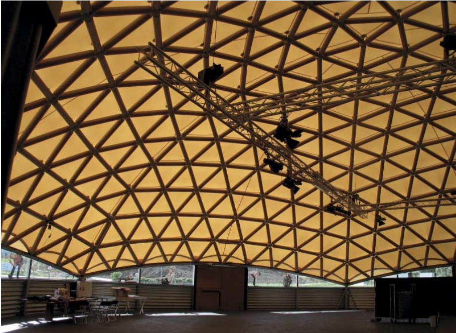
FIG. 108 De kartonnen koepel afgedekt met een toegesneden en gespannen membraan van PVC-gecoatpolyesterweefsel
