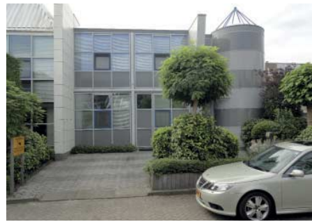
FIG. 11 Gevel in een geïsoleerd stalen systeem voor het eigen woonhuis in Delft
