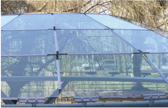
FIG. 70 Details van de kozijnloze verbindingen tussen de 6 mm dikke glaspanelen van de koepel van Jan Wurm (zie ook fig. 71)
