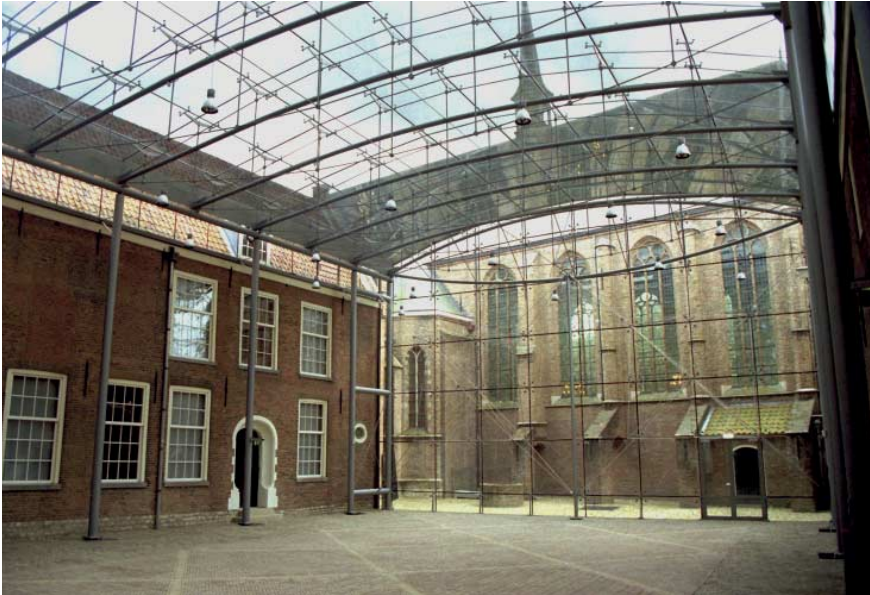
FIG. 04 Glazen Museumzaal Prinsenhof, Delft, geheel autonoom tussen bestaande gebouwen met gelijmde Quattroknopen in de gevel [arch. Mick Eekhout]
