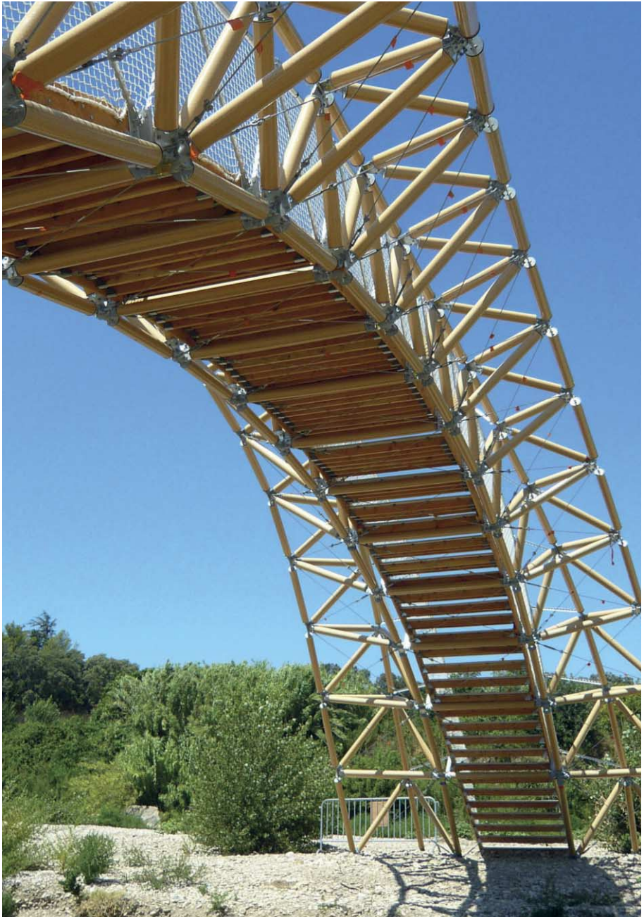
FIG. 112 Kartonnenbrug voor het oversteken van de rivier nabij de Pont du Gard, Remoulin, Fr. [arch. Shigeru Ban]
