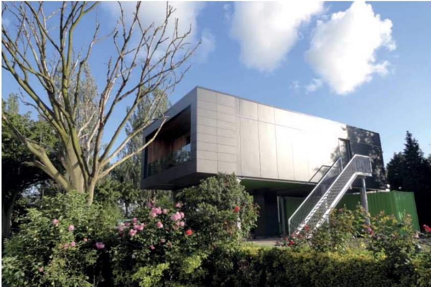
FIG. 14 Concept House DELFT Prototype gerealiseerd als industrieel gemaakte, energiepositieve woning met een extreem lage ecologische voetafdruk als stapelbaar proefappartement van een Urban Villa met 16 appartementen in 4 woonlagen, als onderzoeksresultaat van de leerstoel Productontwikkeling, gerealiseerd dankzij 10 industriële partners en 30 sponsors
