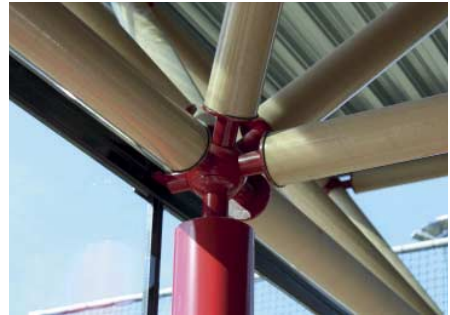
FIG. 116 Knooppunt details kartonnen Tuball systeem
