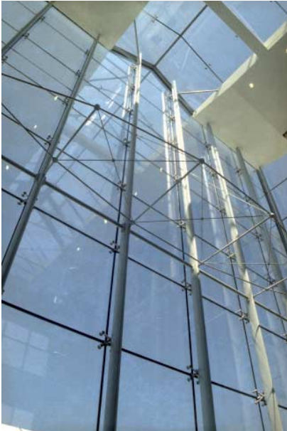
FIG. 06 Kozijnloze glasgevel voor en gebouw in Brussel met een trekspant ter stabilisering van de elliptische gevelstijlen (arch. Philémon Wachtelaer)
