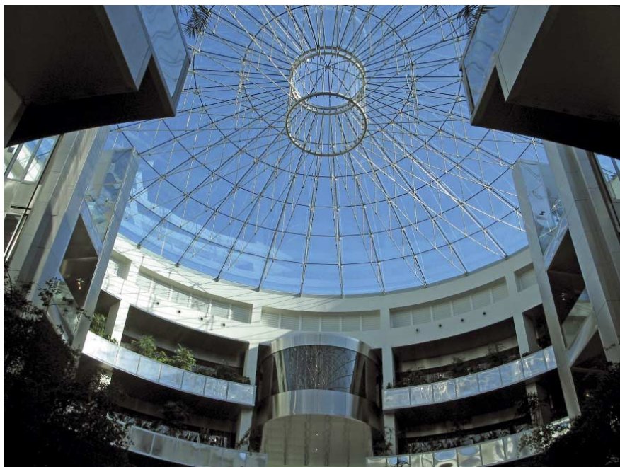
FIG. 25 Het glazen dak van het hoofdkantoor van de Santanderbank in Madrid als een 30 m diameter liggend fietswiel met trekspanten en dubbelglaspanelen afgedekt [arch. Kevin Roche]
