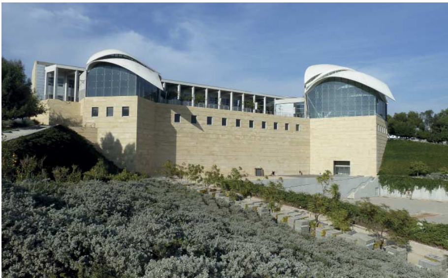
FIG. 136 Het Rabin Center gezien vanaf de tuinen geschonken door de Clintons
