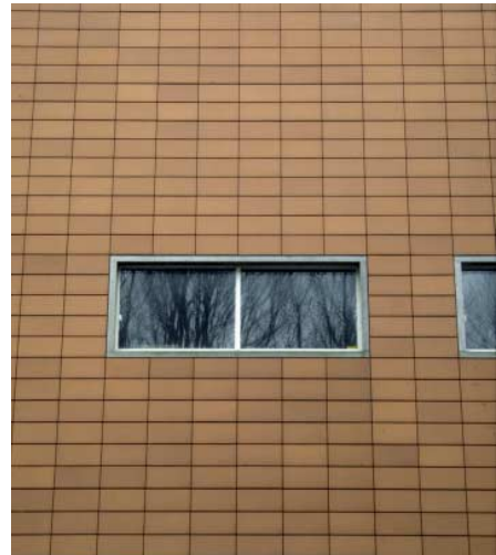
FIG. 13 Gevel in keramische gevelpaneeltjes van het Cultureel Centrum TU Delft (arch. Vera Janovshchinsky)
