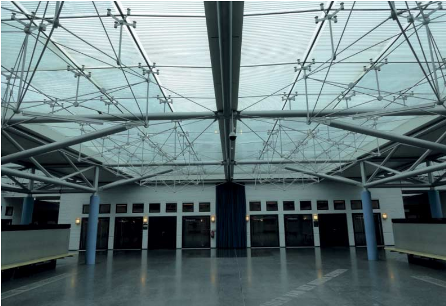
FIG. 02 De centrale hal van de rechtbank in Maastricht met een glazen dakconstructie en de eerste gelijmde Quattroverbindingen, [arch. Gerard Passchier]
