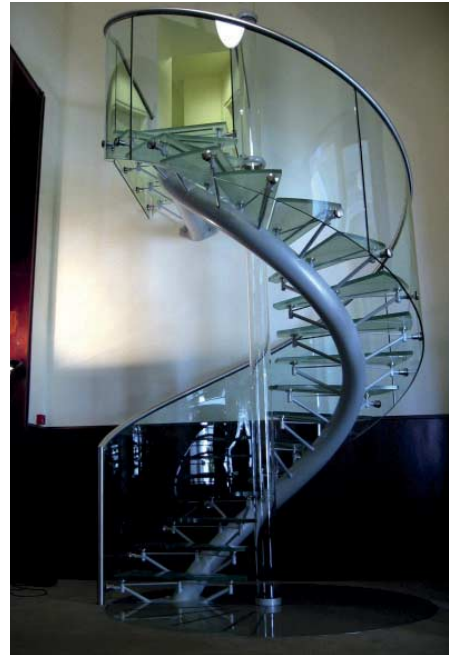
FIG. 78 Ontwerp en uitvoering van glazen spiltrap voor Sociëteit De Witte, Den Haag, [arch. Maarten Grasveld]
