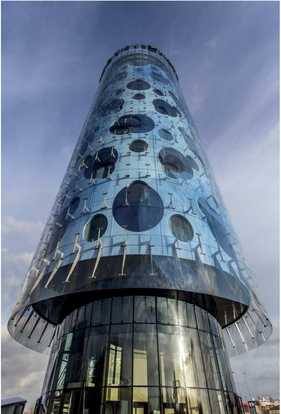
FIG. 26 Het A2/Fletcherhotel Amsterdam Zuidoost met een tweede huid in gelamineerd glas om een buitengevel van glasvezelversterkte polyesterpanelen, [arch. Benthem & Crouwel] [foto: Michael van Oosten]
