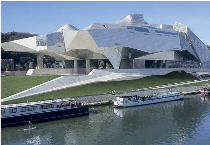
FIG. 35 Beeld van zeer individueel eindproduct als extreem eigenzinnig gebouw: Musée des confluence, Lyon arch. Coop Himmelblau
