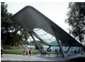
FIG. 37 De waterverzamelende kozijnloze glazen vijver 1,4 m diep in het gemeentelijk Floriadepaviljoen in Hoofddorp, Haarlemmermeer, [arch. Asymptote Architects]
