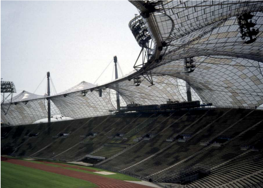
FIG. 81 De kabelnetdaken van het grote Olympisch stadion van München (arch. Günther Behnisch en Frei Otto)
