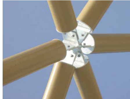
FIG. 107 Knooppunt met staafaansluitingen in de werkelijkheid
