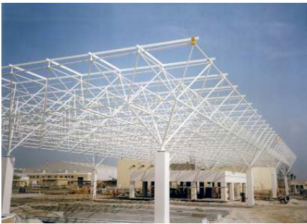
FIG. 10 Space frame is Tuball system voor een hal op Dubai Airport, geëngineerd in Nederland, geproduceerd door Octatube India pte ltd
