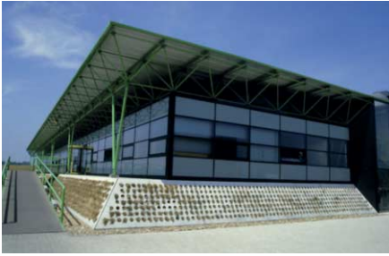
FIG. 45 Douanekantoor met spaceframe, zonnedak en ondergehangen dak nabij Hazeldonk, [arch. Benthem & Crouwel]
