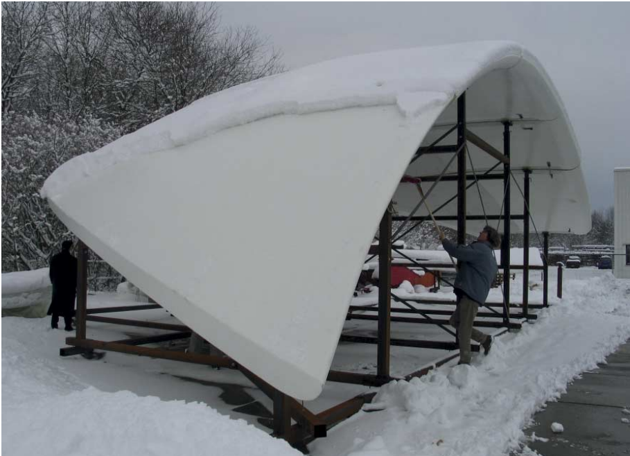
FIG. 127 Proefopstelling van de eerste drie segmenten aan elkaar geconstrueerd, in de sneeuw van Lelystad
