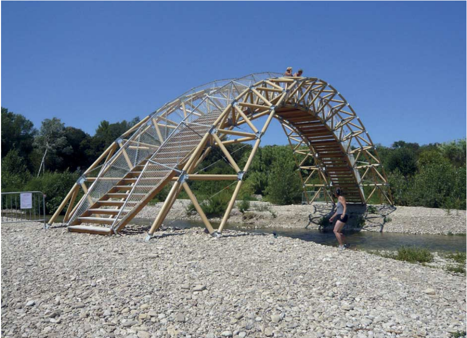
FIG. 113 Kartonnen brug voor het oversteken van de rivier de Gard, Remoulin, Fr. [arch. Shigeru Ban]
