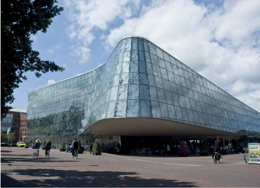
FIG. 33 Straatzijde van het stadhuis Alphen aan de Rijn met de als individueel verschillend ontworpen en geprinte gevelpanelen in dubbelglas [arch. Erick van Egeraat], zie ook fig. 20 en 21.
