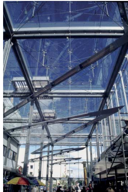
FIG. 07 Modulair (8 x 8 m 2 ) onderspannen glasdak voor winkelcentrum Overvecht, (arch. Op ten Noord Blijdenstein)
