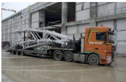
FIG. 28 Aanvoer van subcomponenten van stalen spanten op de Cotroceni bouwplaats in Boekarest
