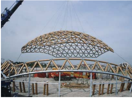
FIG. 97 Het inhijzen van het centrale deel op de onderstaande rand, waarna de tussenzone aaneen gebouwt wordt
