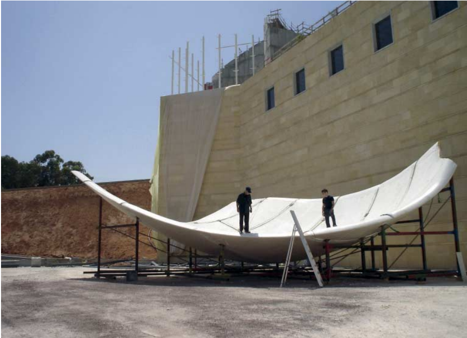
FIG. 129 De segmenten van de onderste schaal van de Library wordt in holle vorm (met minder gevaar voor vallen van eigen personeel) geassembleerd
