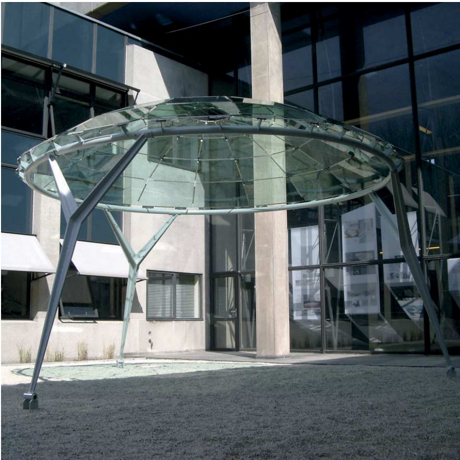
FIG. 69 De kozijnloze en verbodingsloze glaskoepel van Jan Wurm als gastonderzoeker, later gepromoveerd op glasconstructies op TU Aken
