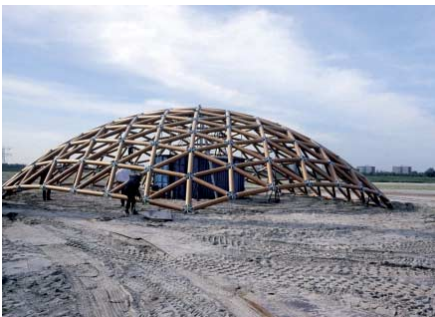
FIG. 95 Opbouw van het centrale deel van de kartonnen koepel op IJburg
