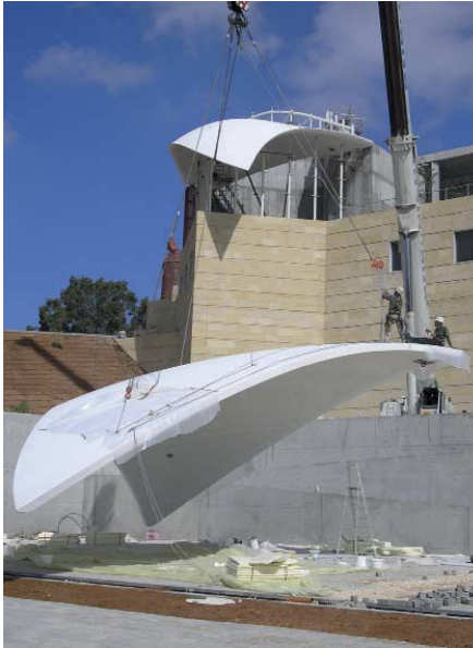
FIG. 130 De tweede, bovenste schaal van de Library wordt ingehesen
