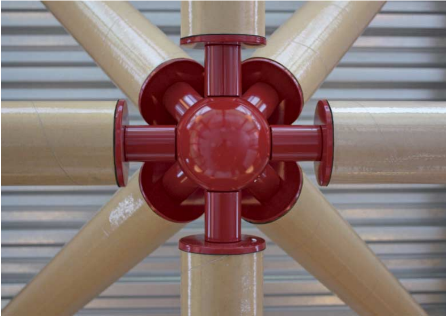
FIG. 111 Knooppunt van het Tuball knooppunt met kartonnen staven, zoals gebruikt voor de Ring Pass hockey club uitbreiding in Delft (arch. Nils Eekhout)
