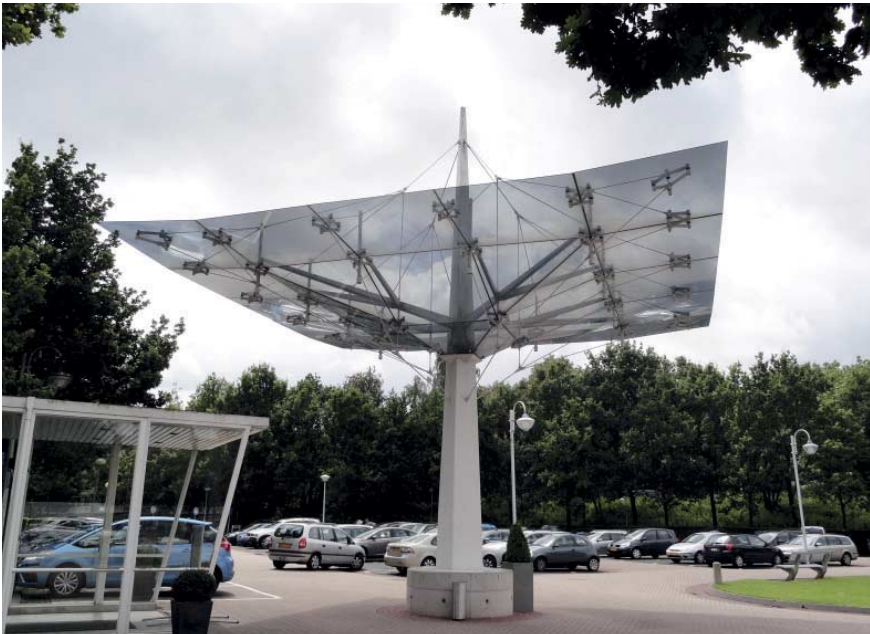
FIG. 05 Glazen luifel voor het Evoluon in Eindhoven 10 x 10 m 2 met 10 mm massief glas. [arch. Gert Grosveld]
