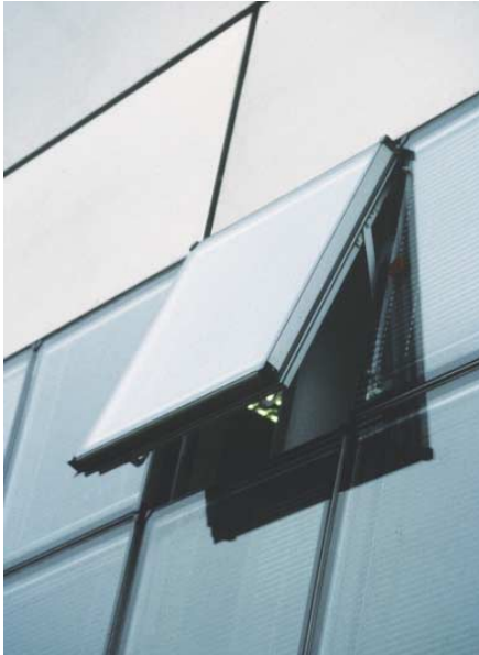
FIG. 22 Uitzetraam in een structural glazing façade
