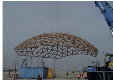
FIG. 96 Ophijzen van het centrale deel met veel tuikabels om de spanningen in het karton te verdelen en laag te houden
