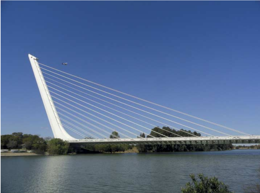
FIG. 80 De Alamillobrug naar ontwerp van Santiago Calatrava in Sevilla
