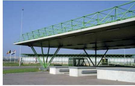
FIG. 46 Inspectieuiluifel met space frame en ondergehangen dak op douanecomplex Hazeldonk (arch. Benthem & Crouwel)
