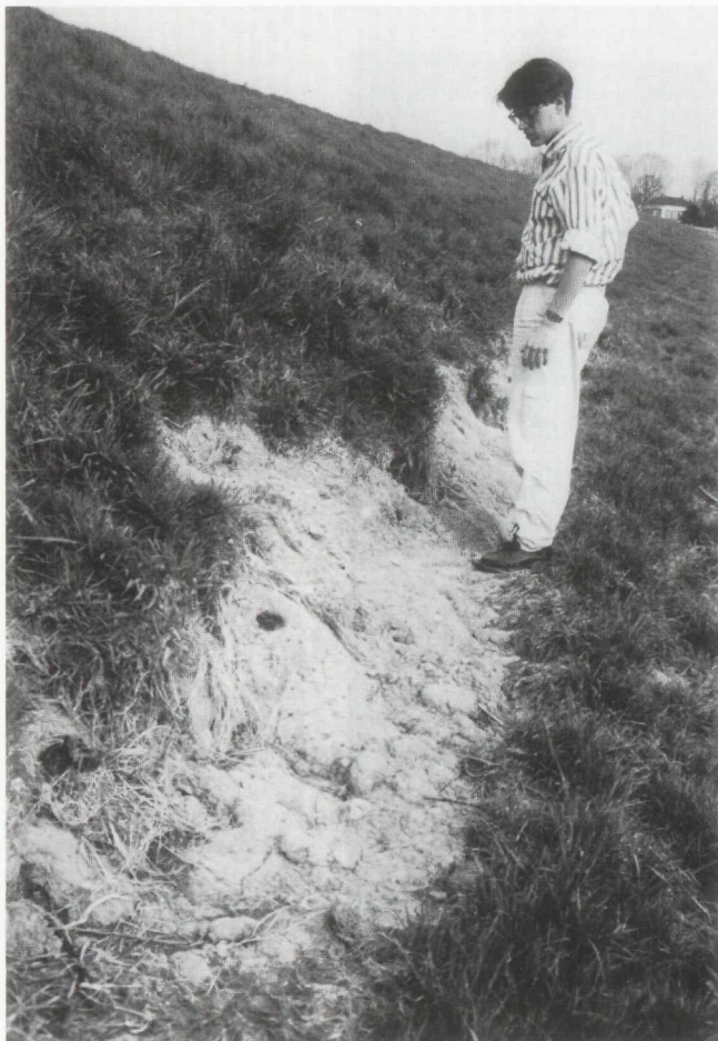
Foto nr. 10 Pd Betuwe Rechter Waalbandijk nabij Ochten (hmp (N) 128): Schade juist boven de taludbekleding. De kwaliteit van de grasmat is slecht. Situatie tijdens hoogwater.
