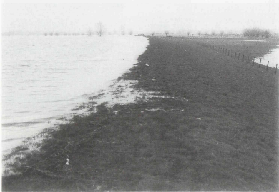
Foto nr. 45 Ws Oost-Veluwe Linker IJsseloever, Wilpsche Kleipolder: Zomerkade staat op het punt over te lopen. Als maatregel worden zandzakken gelegd (zie ook foto nr. 17).
