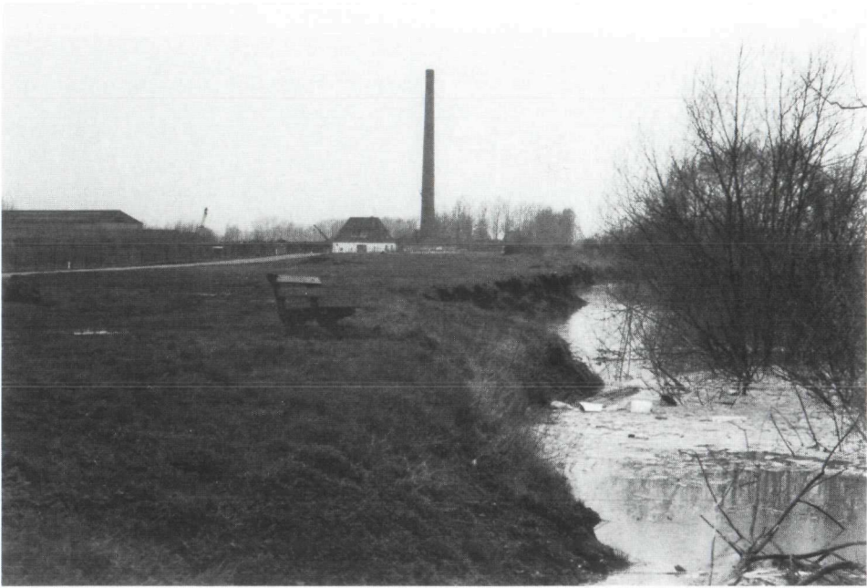
Foto nr. 11 Pd Groot Maas en Waal Linker Waalbandijk nabij Ooy (hmp 28,5-30): Erosie van buitendijks hoog gelegen voorland. Situatie tijdens hoogwater.
