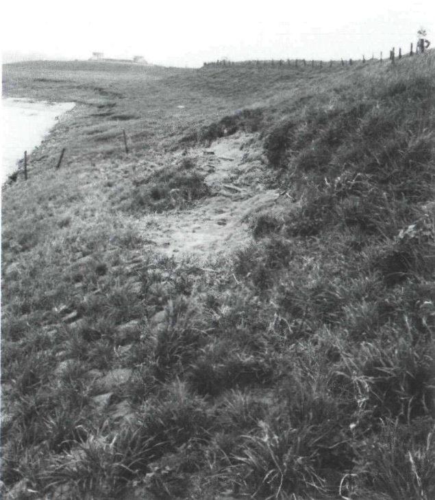
Foto nr. 6 Pd Betuwe Rechter Waalbandijk (hmp (O) 134): Erosie buitentalud direct boven bekleding als gevolg van golfaanval. Situatie na hoogwater.
