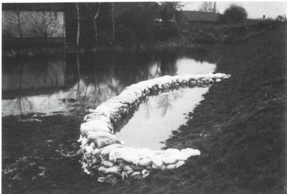
Foto nr. 38 Pd Rijn en IJssel Rechter IJsselbandijk Lathumse dijk (rkm 884,9): Opgekiste kwel. Situatie tijdens hoogwater.
