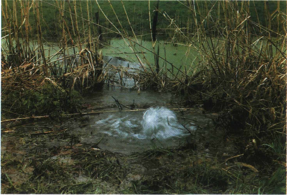
Foto nr. 29 Pd Tieler- en Culemborgerwaarden Rechter Waalbandijk, Heesselt (hmp 126): Sputende watervoerende wel. De wel werd opgekist om omwonenden gerust te stellen. Situatie tijdens hoogwater.
