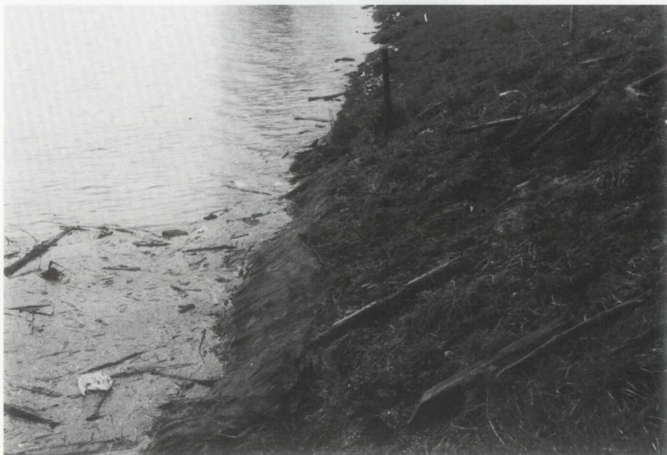
Foto nr. 10 Pd Betuwe Rechter Waalbandijk nabij Ochten (hmp (N) 128): Schade juist boven de taludbekleding. De kwaliteit van de grasmat is slecht. Situatie tijdens hoogwater.
