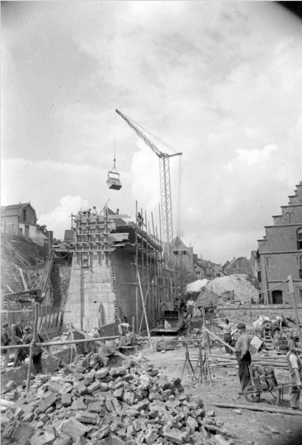
construction of Groene Balkon (Regionaal Archief Nijmegen, 1954)
