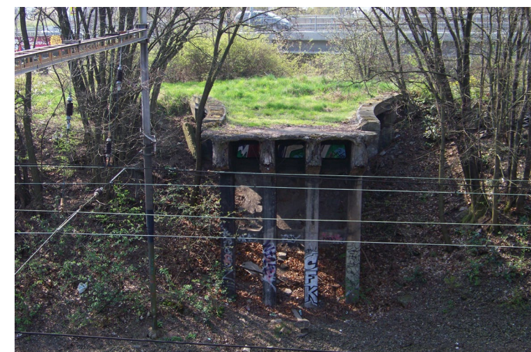
Fig. 7 Bridge remains, source: ŠJů, Wikimedia Commons
