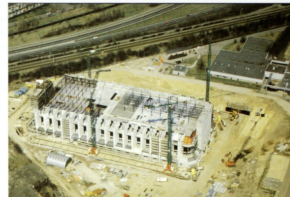
Fig. 12. Cleanroom in aanbouw te Nijmegen
