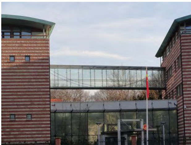
Glazen Zappibrug tussen 2 gebouwen op de Chinese ambassade, Den Haag
