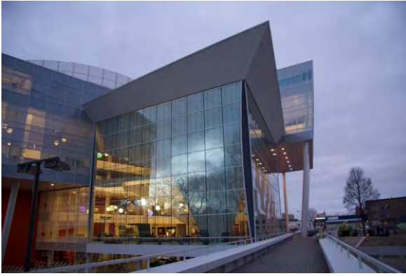
Een experimentele glasgevel voor INHolland in Delft, met aramide voorspankabels, waarbij de gevel totaal 600 mm heen en weer kan bewegen tijdens windkracht 12 Beaufort (arch. Rijk Rietveld) .
