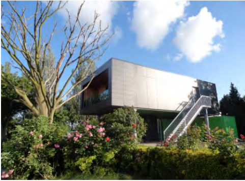
Het gerealiseerde Concept House Prototype als proefappartement in Heyplaat, Rotterdam
