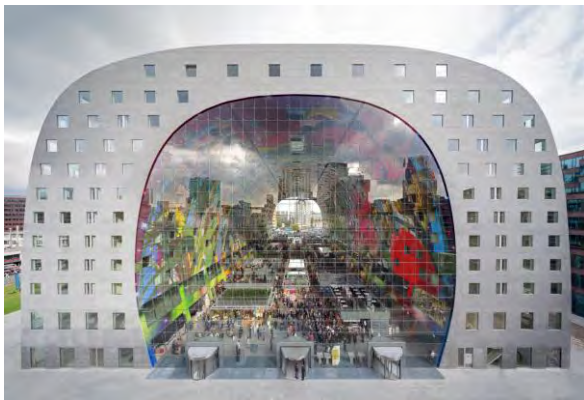
Twee kabelnetgevels van de Markthal in Rotterdam. Kunnen 1,4 m heen en weer bewegen bij 12 Beaufort. Koelbloedige Delftse engineering: Nederlandse Bouwprijs 2015 (arch. MVRDV Winy Maas)
