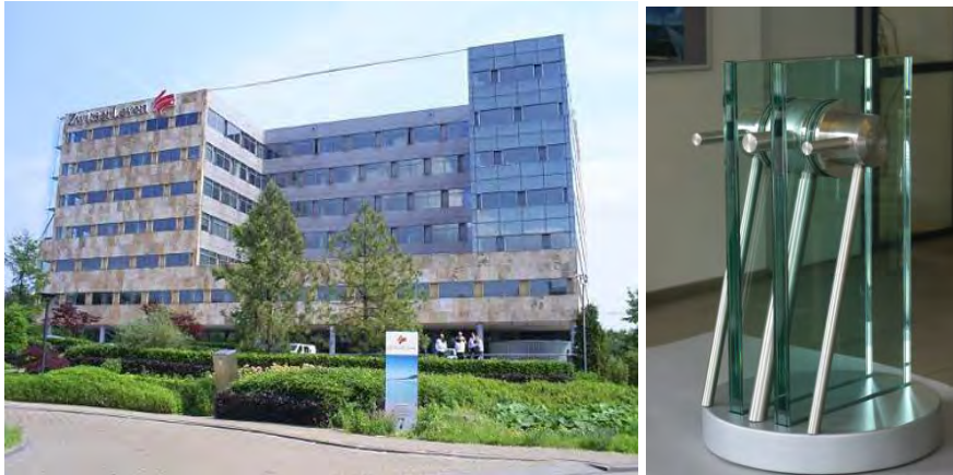
Hoofdkantoor Zwitserleven met de beoogde overspanning van glazen balk 27 m lang en knooppunt Fokke van Gijn
