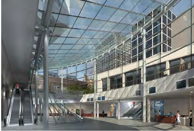
De nog niet-voltoorde glazen entree van het Van Gogh in Amsterdam (arch. Hans van Heeswijk)
