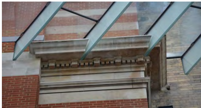
Het glazen dak van Renaissance Gallery van het Victoria & Albertmuseum in Londen, inclusief prachtige details van glazen liggers die 'als een mes door de boter' in een natuurstenen detail snijden: 'European Structural Design Award 2010' (Arch. MUMA)
