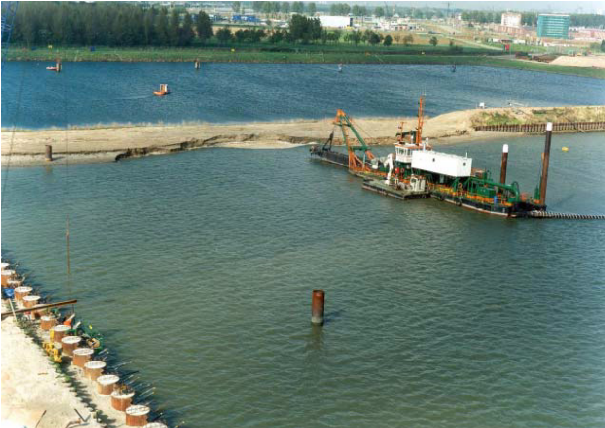
Afbeelding 8.2.8, Verwijderen dijk tussen bouwdok en rivier.
