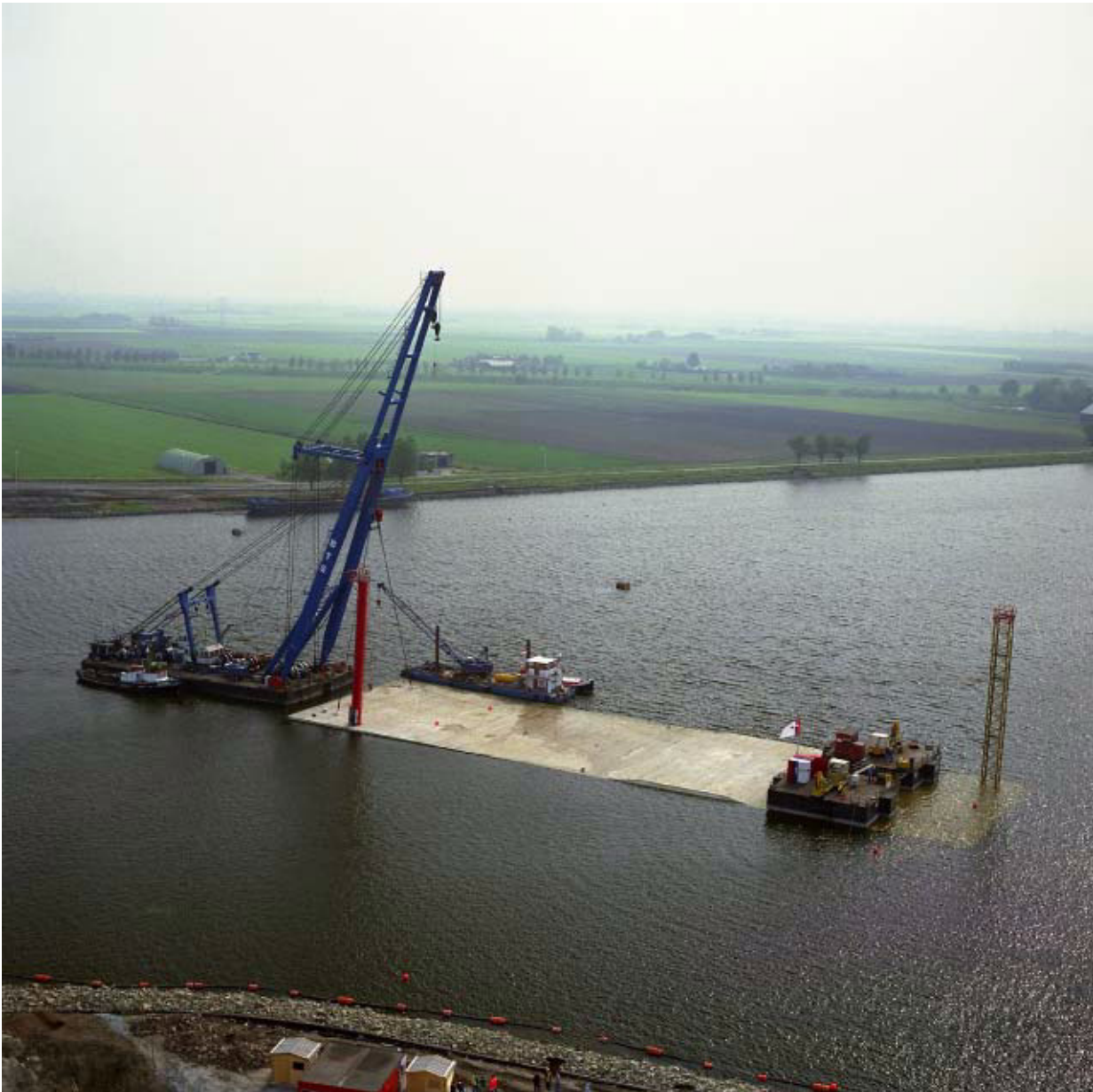
Afbeelding 8.4.8, Afzinken met drijvende bok.
