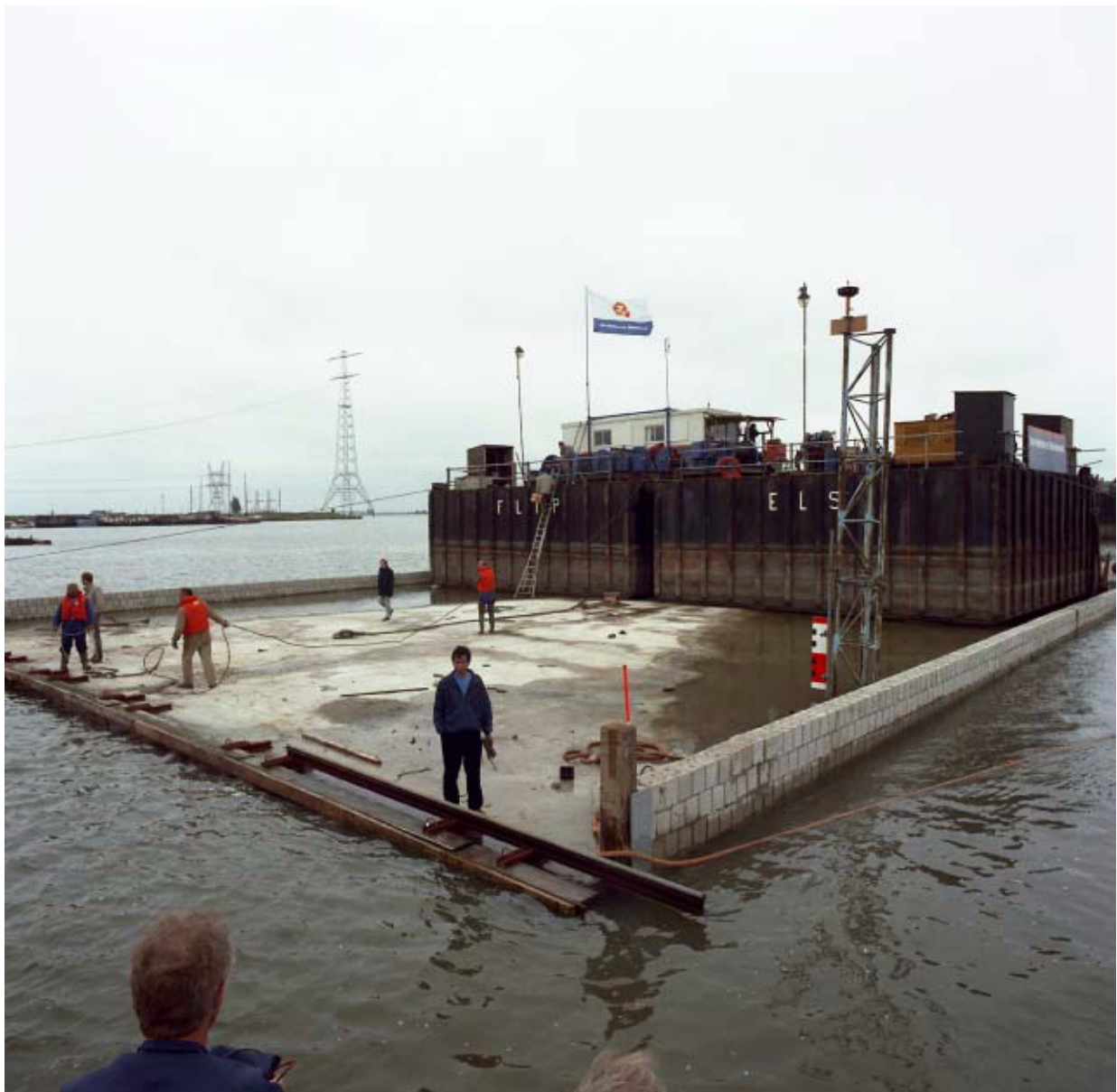
Afbeelding 8.3.5, Tunnelement transport gereed.
