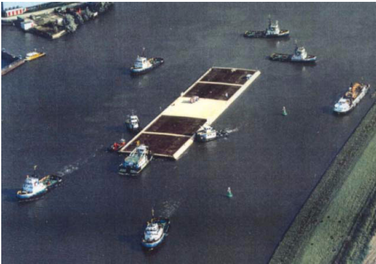
Afbeelding 8.3.1, Transport van een tunnelement.
