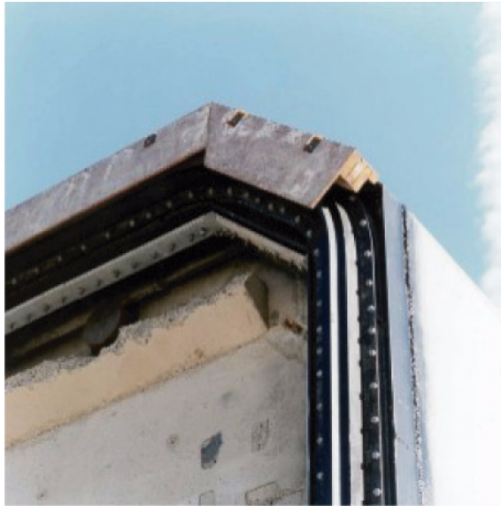
Afbeelding 5.8.10, Bescherming Gina profiel
