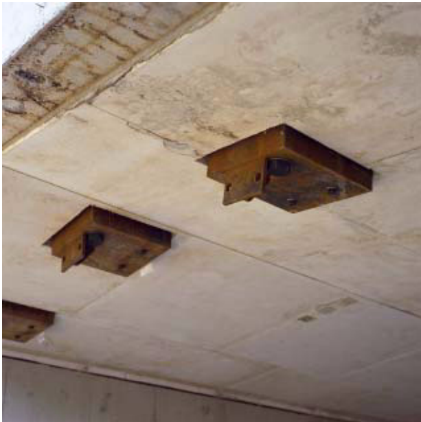
Afbeelding 8.8.4, Aanslag voor het kopschot in het dak.
