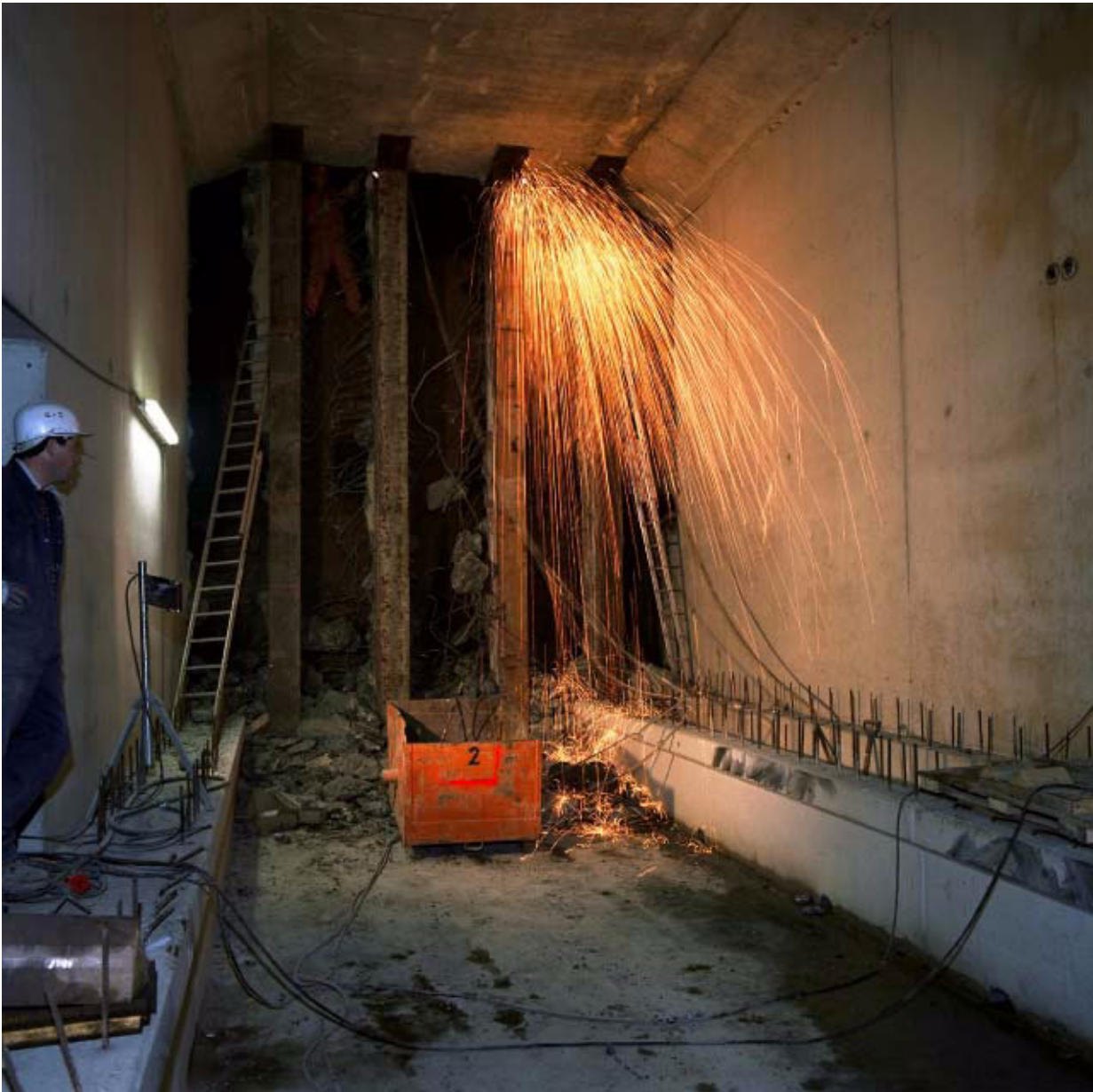
Afbeelding 8.8.2, Sloop van een kopschot.
