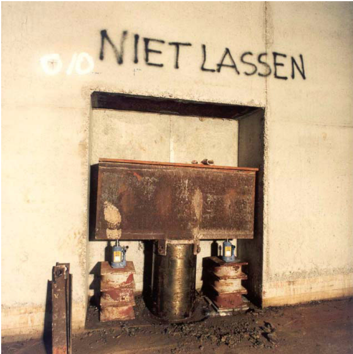
Afbeelding 8.6.4, Sparing ter plaatsen van vijzelpen.
