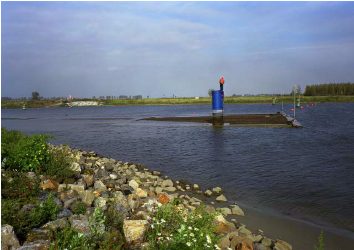
Afbeelding 8.2.11, Opdrijven tunnelelement
