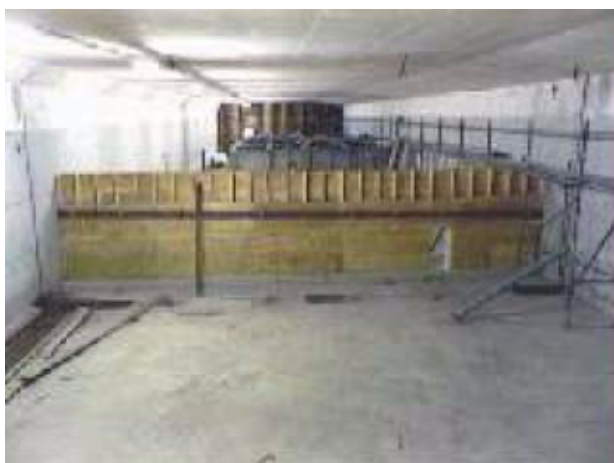
Afbeelding 8.8.26, Ballasttanks in bouwfase.
