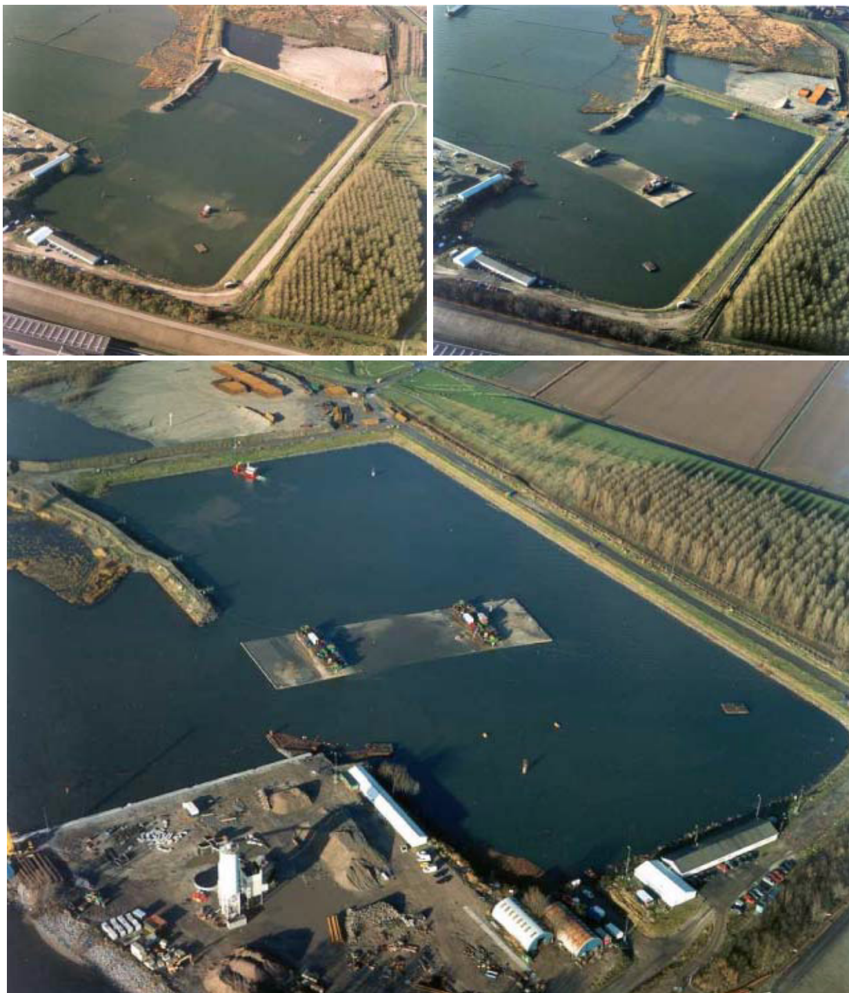
Afbeelding 8.2.13, Uitlieren van een tunnelement.
