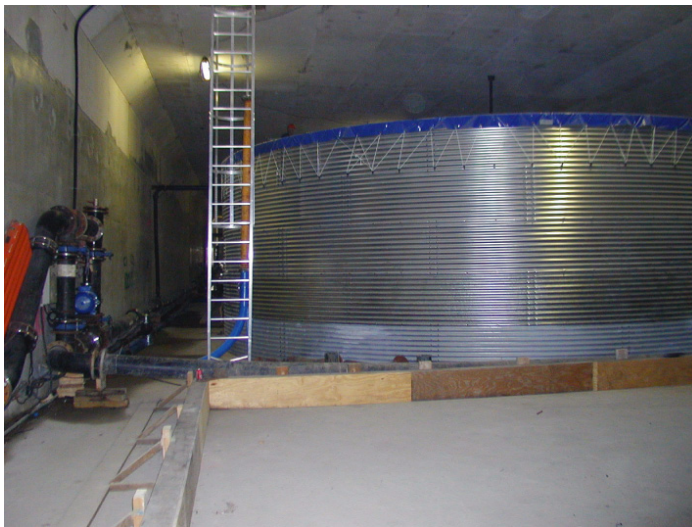
Afbeelding 5.8.2, Ballasttank (Calandtunnel / watertank uit de tuinbouw)
