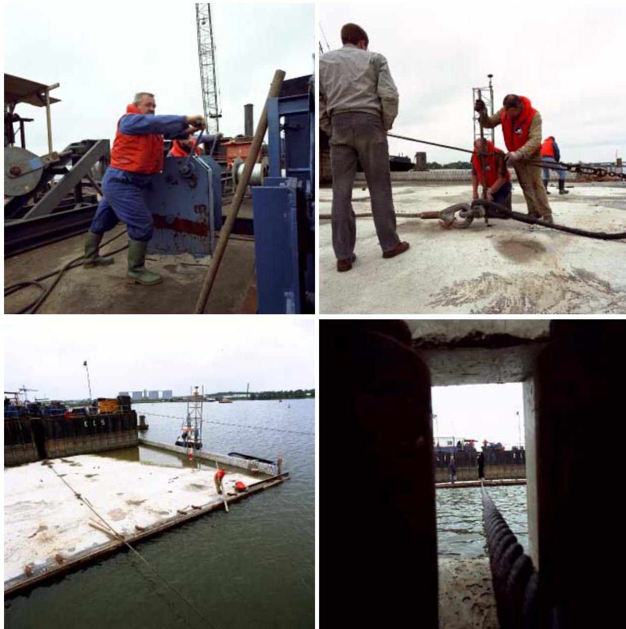
Afbeelding 8.4.7, Verankering van het element.
