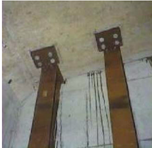
Afbeelding 8.8.5, Stalen kopschotstijlen.
