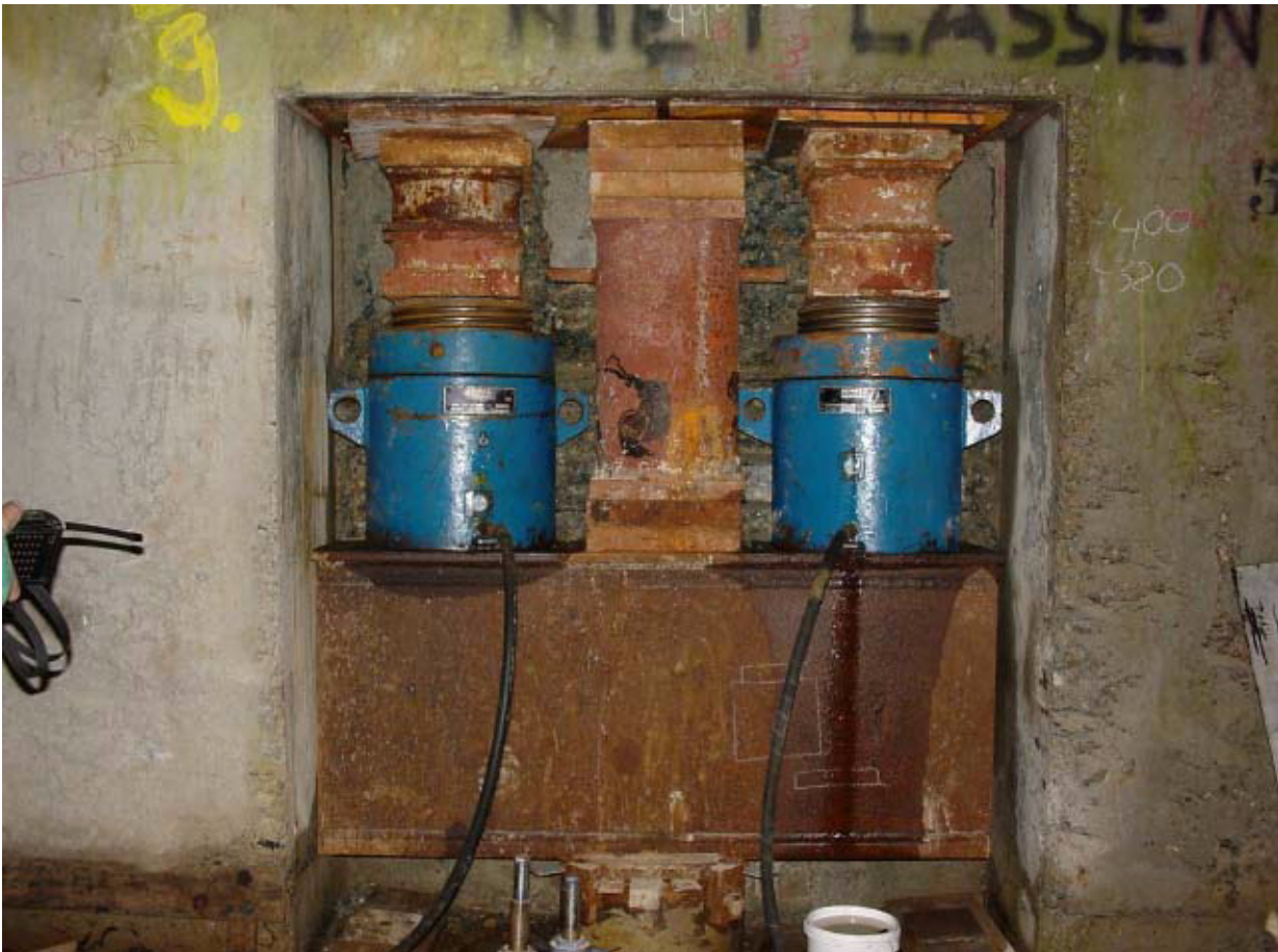
Afbeelding 8.8.14, Vijfels in sparing tunnelwand.
