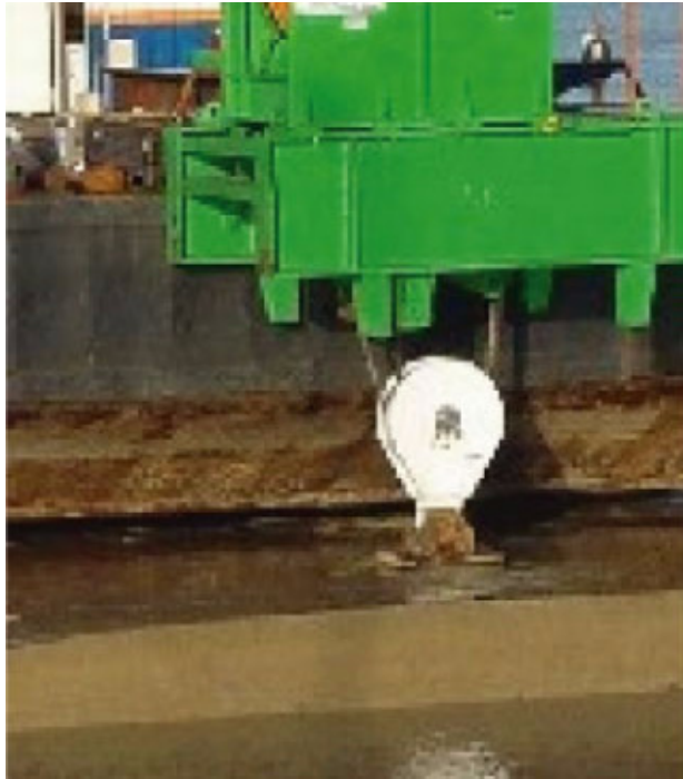
Afbeelding 5.8.18, Hijspunten en afzinktraverse
