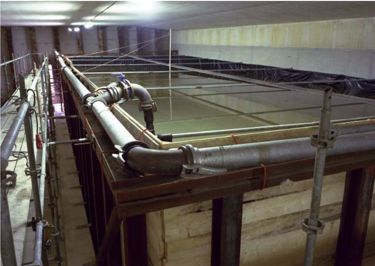
Afbeelding 8.2.4, Vullen ballasttank
