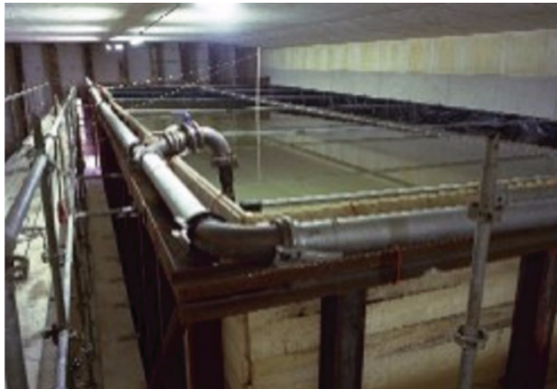
Afbeelding 5.8.3, Ballastleidingensysteem (Wijkertunnel/tanks vrij gehouden van buitenwand))
