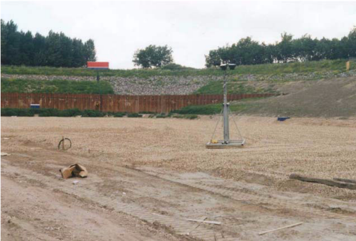
Afbeelding 8.2.1, Grindbed in een bouwdok.
