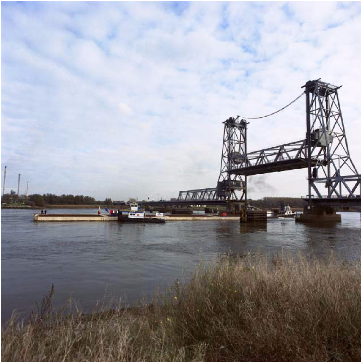
Afbeelding 8.3.6, Transport tunnelement bij passage van een brug.
