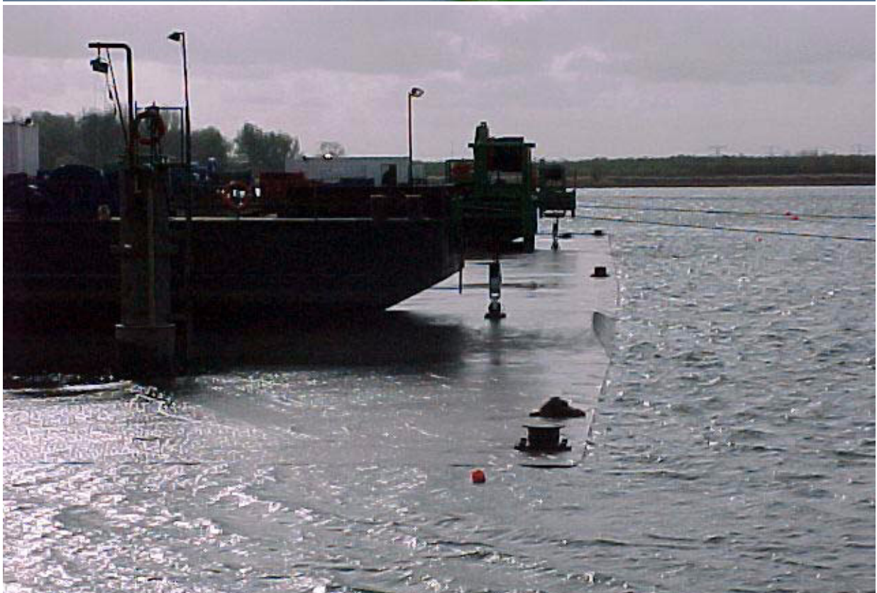
Afbeelding 8.8.29, Potons voor gebruik tijdens het afzinken.
