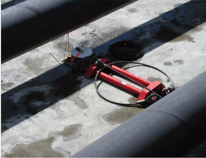
Afbeelding 5.8.9, Aantrekcilinder Calandtunnel
