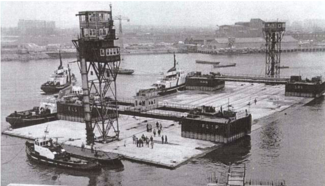
Afbeelding 8.4.1, Tunnelement afzink gereed maken.
