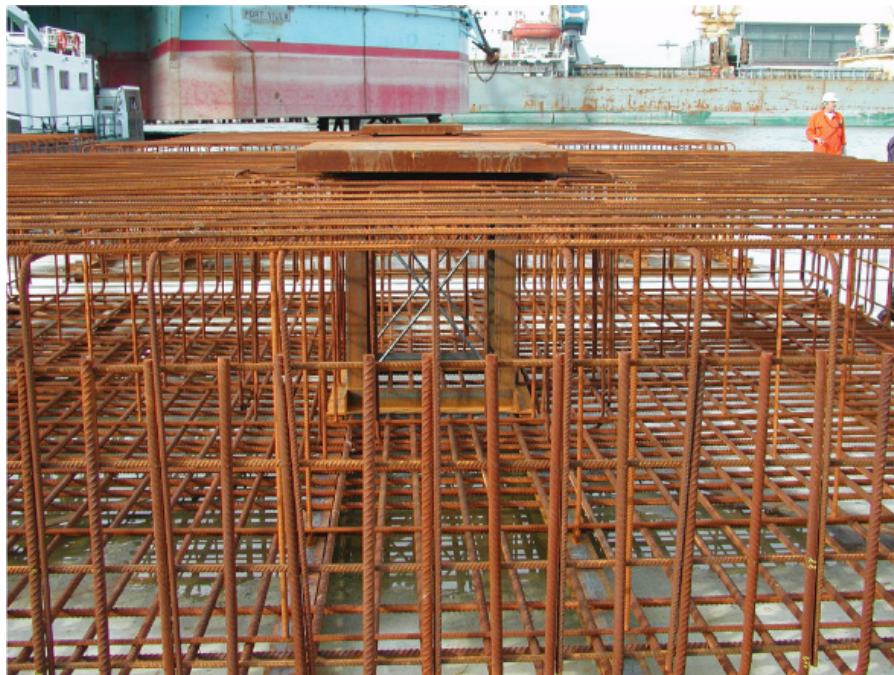
Afbeelding 5.8.6, Wapeningskorf met stelplaat oplegtegel
