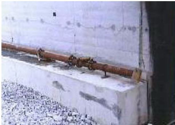
Afbeelding 8.5.11, Tijdelijke langsliding op oor tunnelement, ten behoeve van aansluiting op onderstroomleiding in de vloer.
