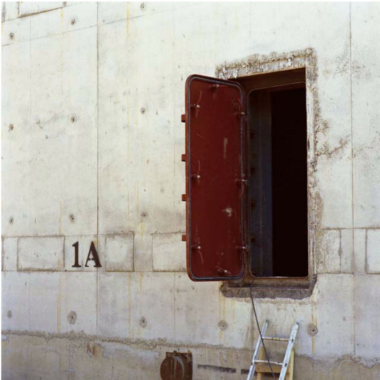
Afbeelding 8.8.7, Toegangsdeur in kopschot.
