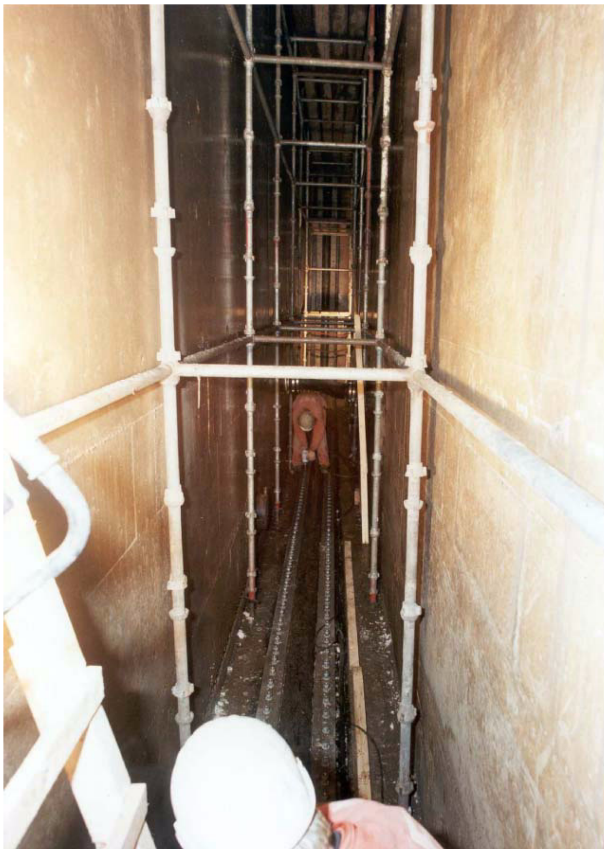
Afbeelding 8.8.24, Aanbrengen OMEGA-profiel.
