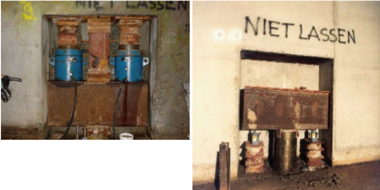
Afbeelding 5.8.7, Vijzelpennen met borging en dwarsbalk in sparing buitenwanden
