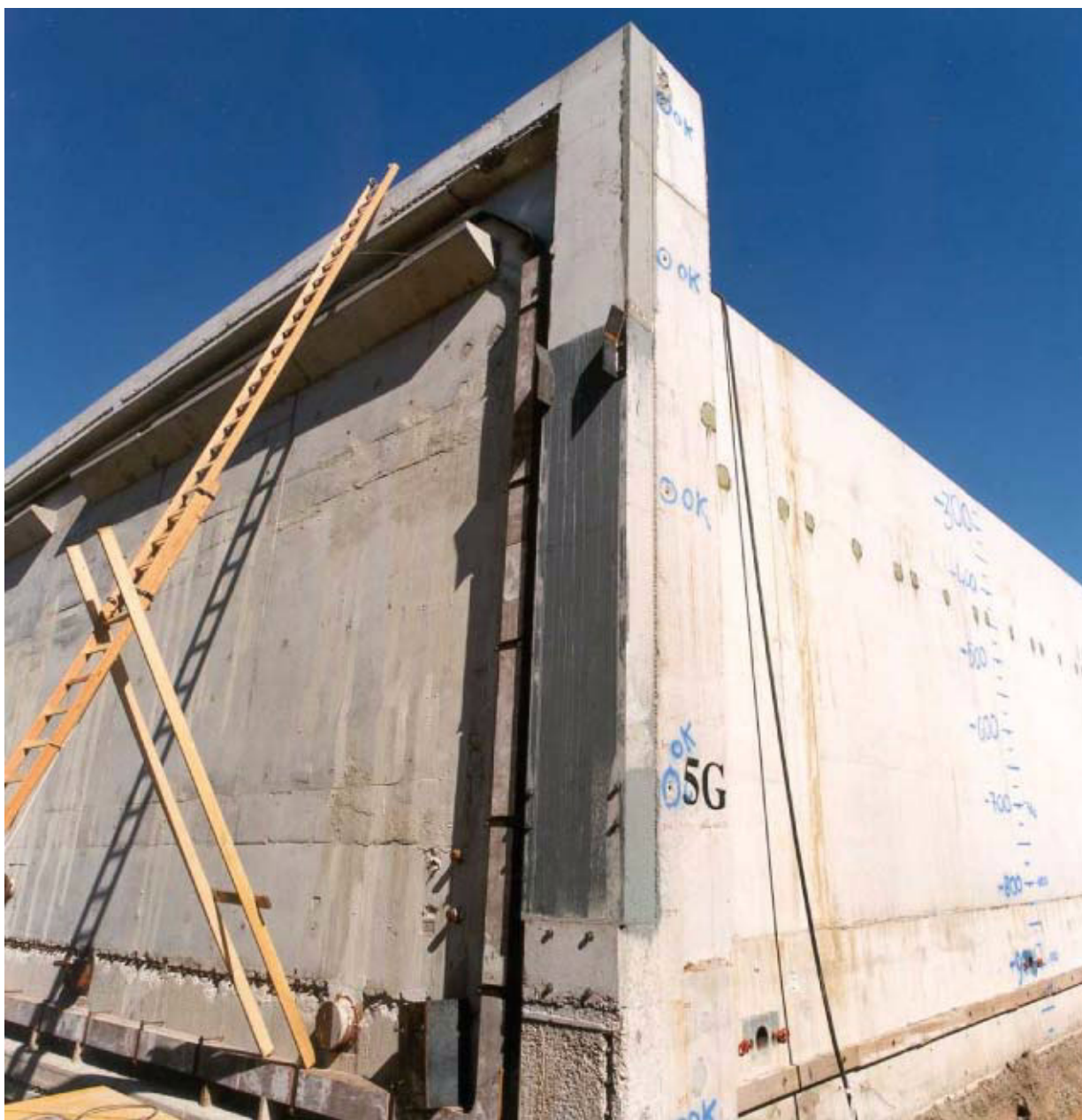
Afbeelding 8.8.20, Sluitvoeg.
