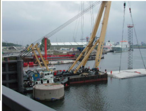
Afbeelding 5.8.17, Installatie meettoeren met bok (Calandtunnel)
