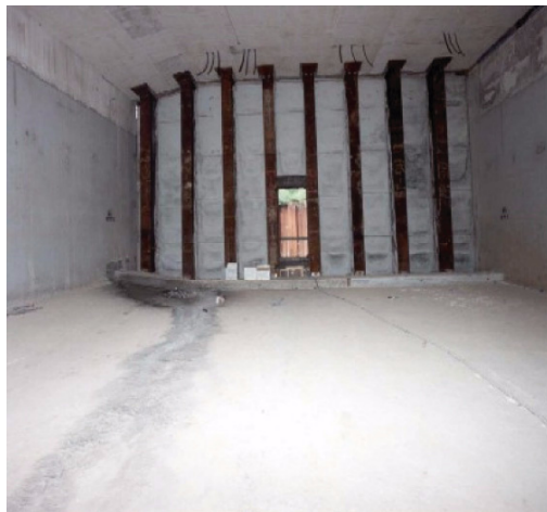
Afbeelding 5.8.8, Kopschot (2 e Beneluxtunnel)
