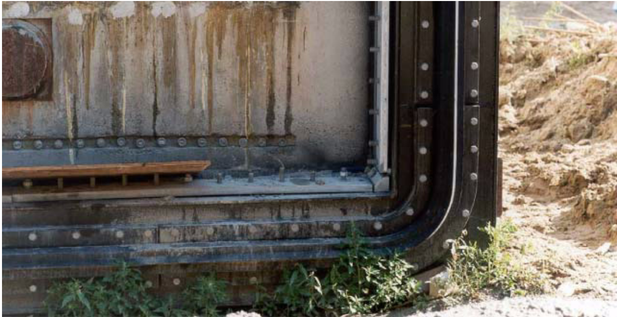
Afbeelding 8.8.19, Primaire zijde tunnelelement.
