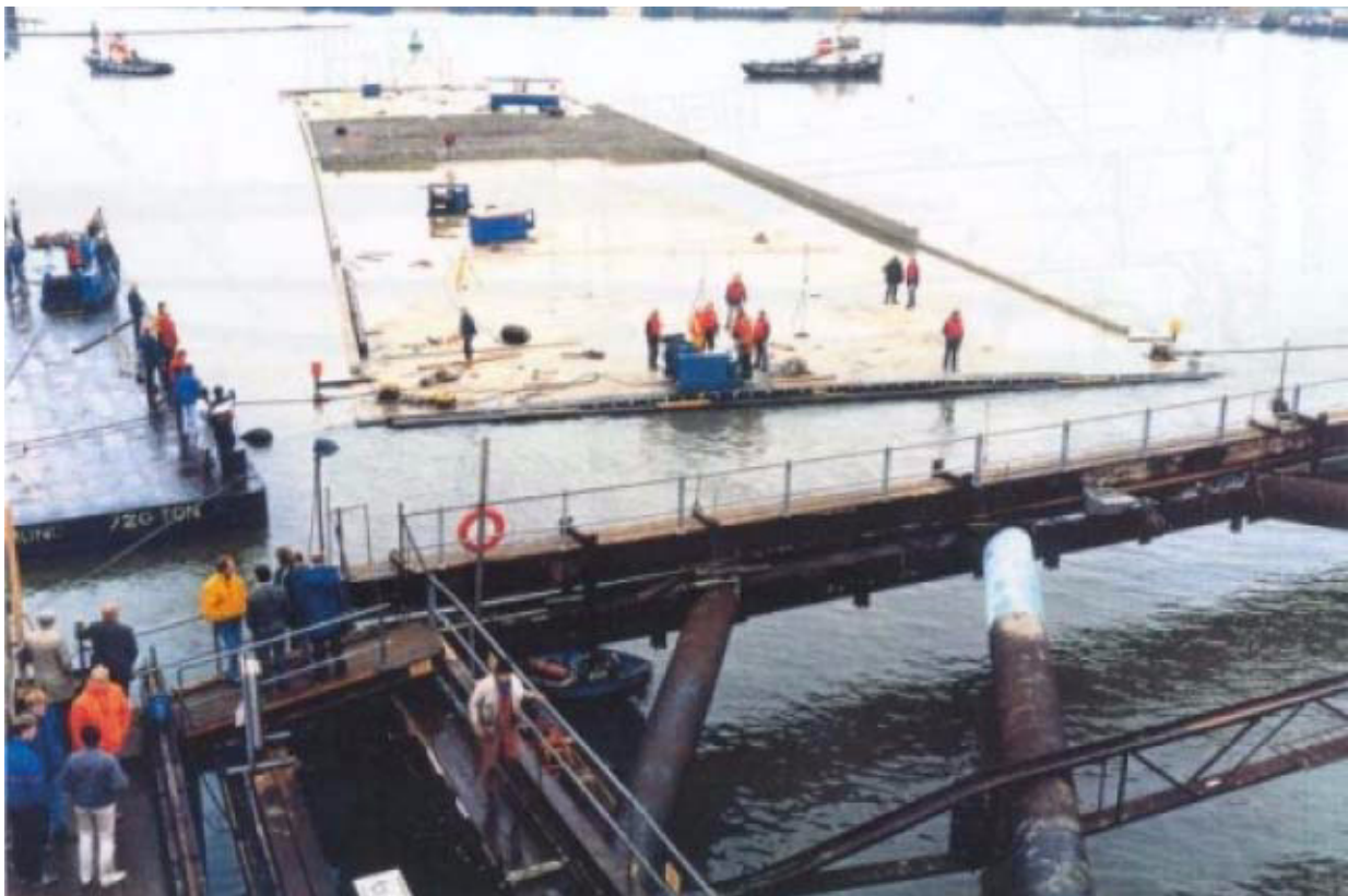
Afbeelding 8.3.13, Afmeerlocatie bij Zeeburgertunnel, tunnelement is net uitgelierd uit bouwkuip en op weg naar de afmeerlocatie.
