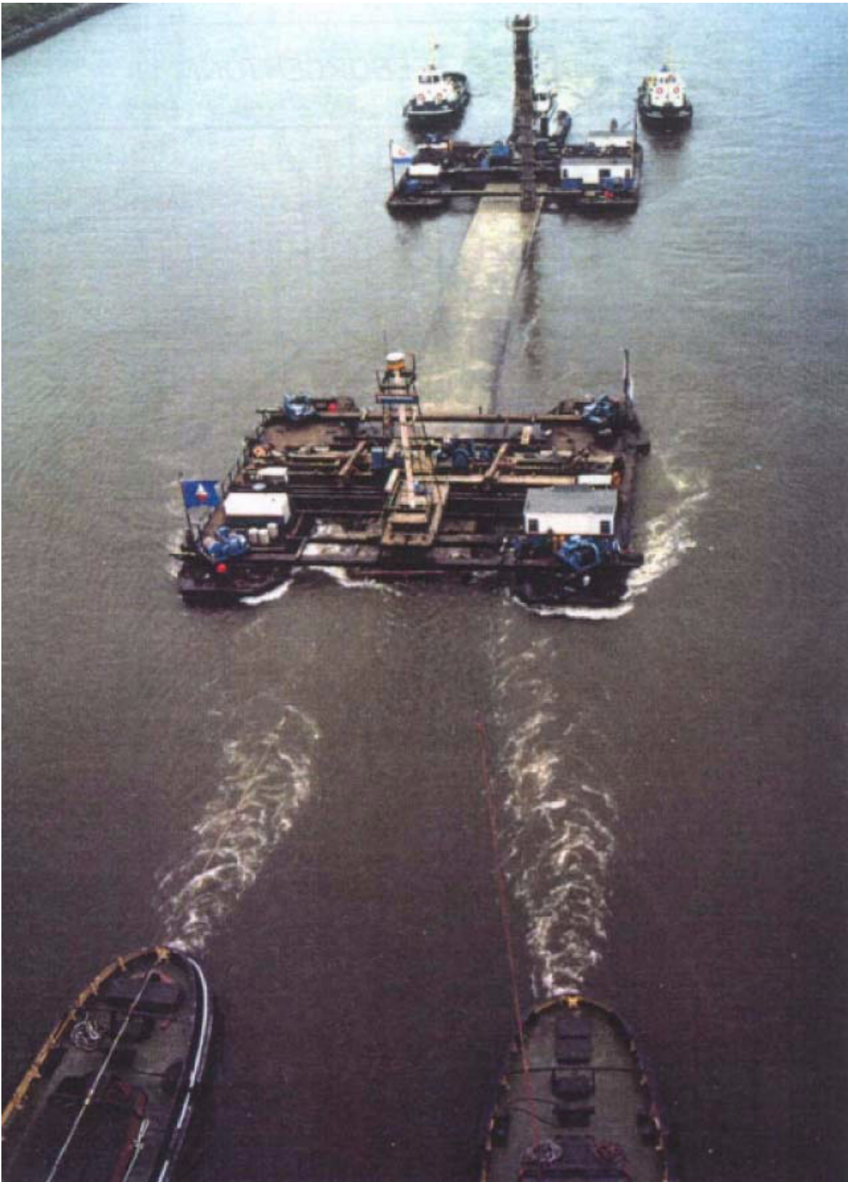
Afbeelding 8.3.2, Transport van een tunnelement m.b.v. pontons.
