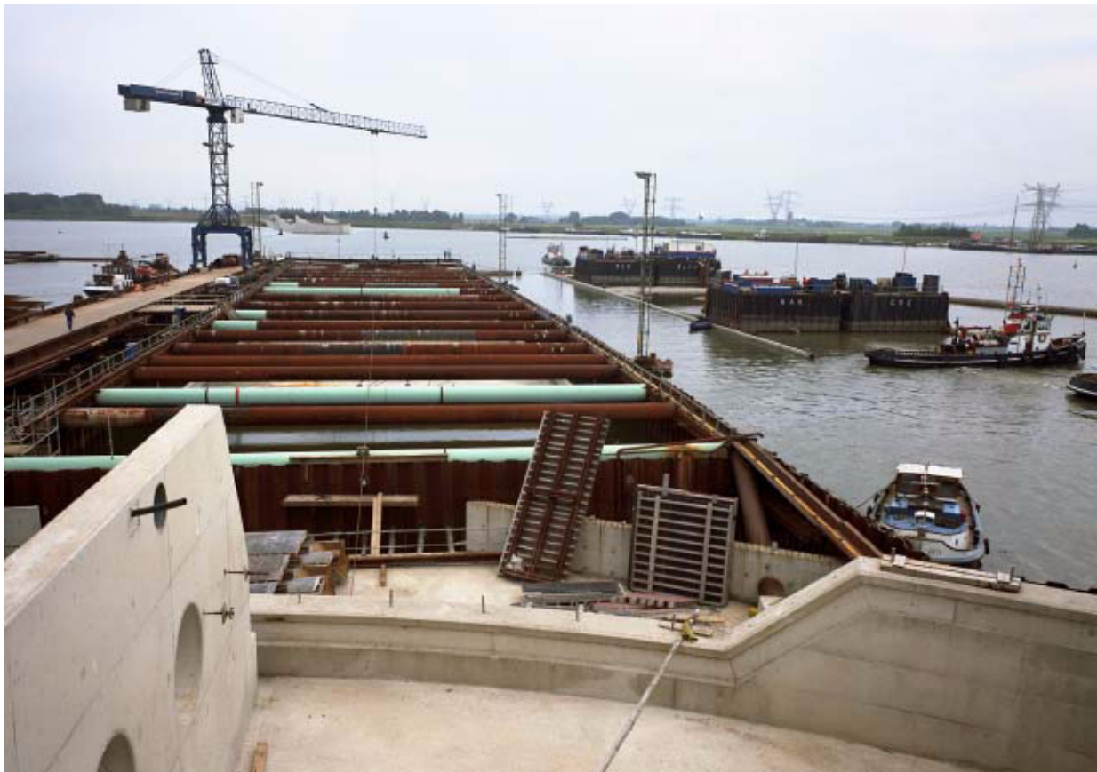
Afbeelding 8.4.5, Tunnelement afzinkgereed maken. Zeeburgertunnel, element afgemeerd bij bouwkuip.
