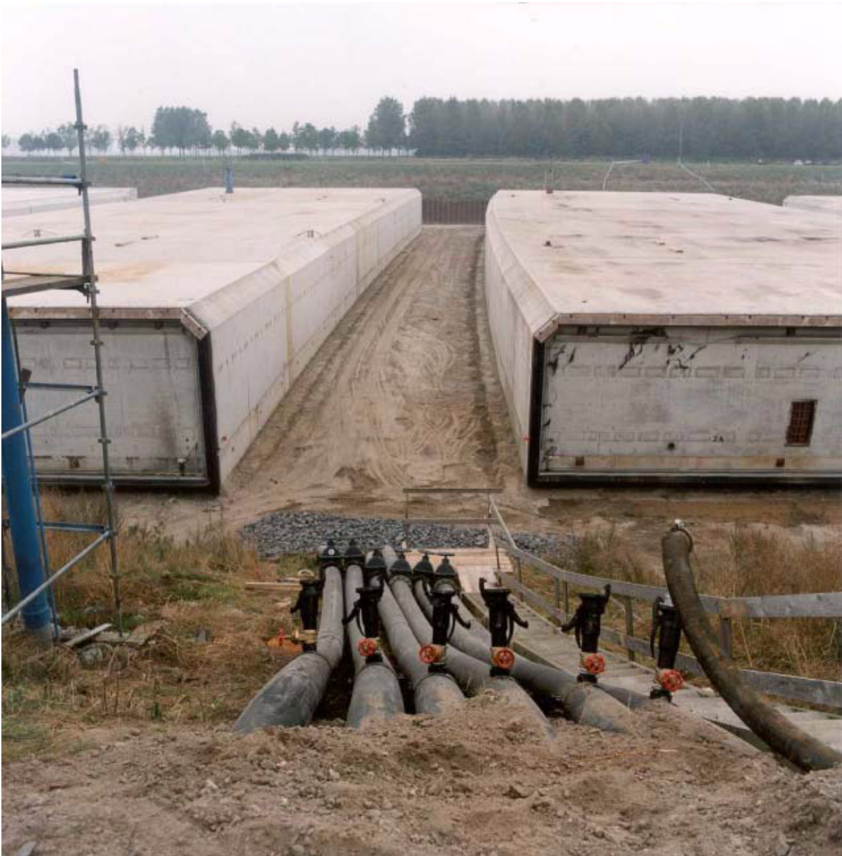
Afbeelding 8.2.2, Bouwdok inundatie gereed.
