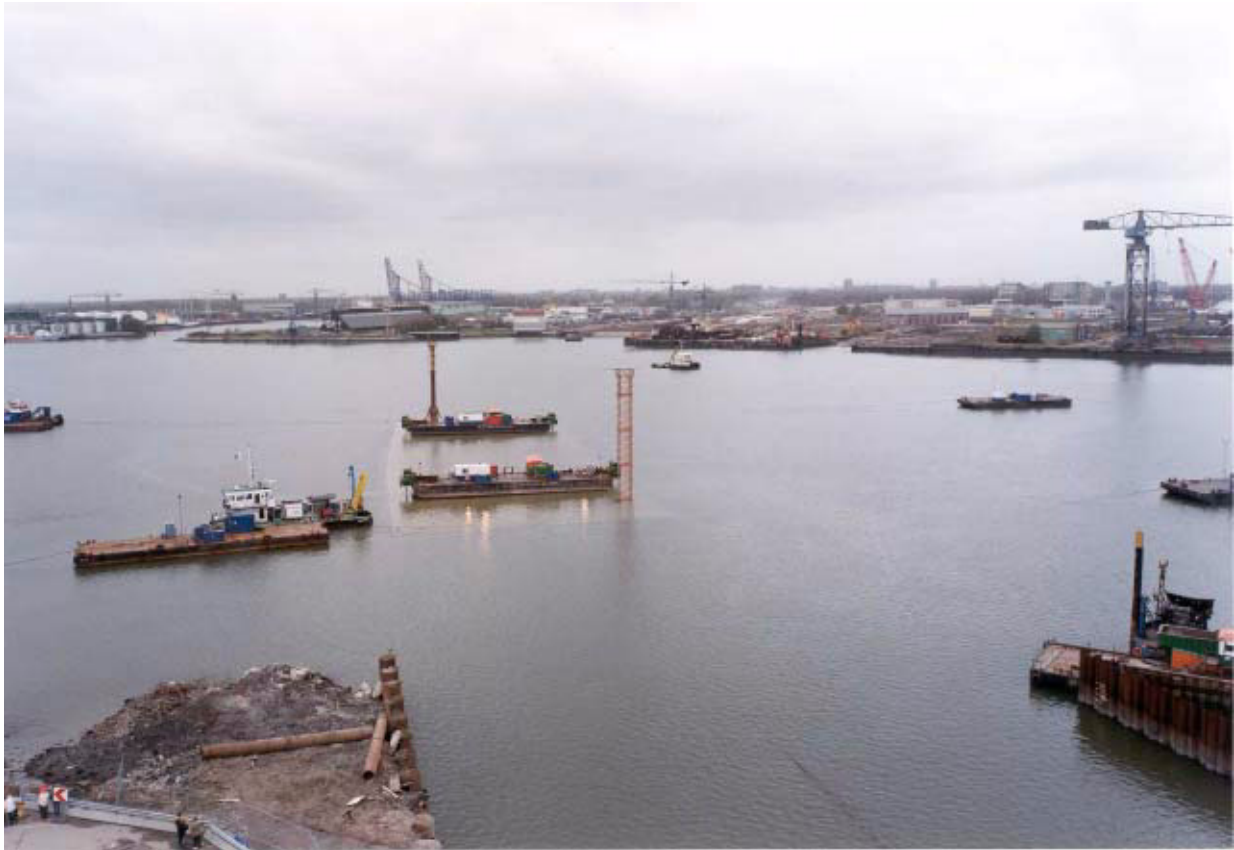
Afbeelding 8.4.9, Afzinken met potons.
