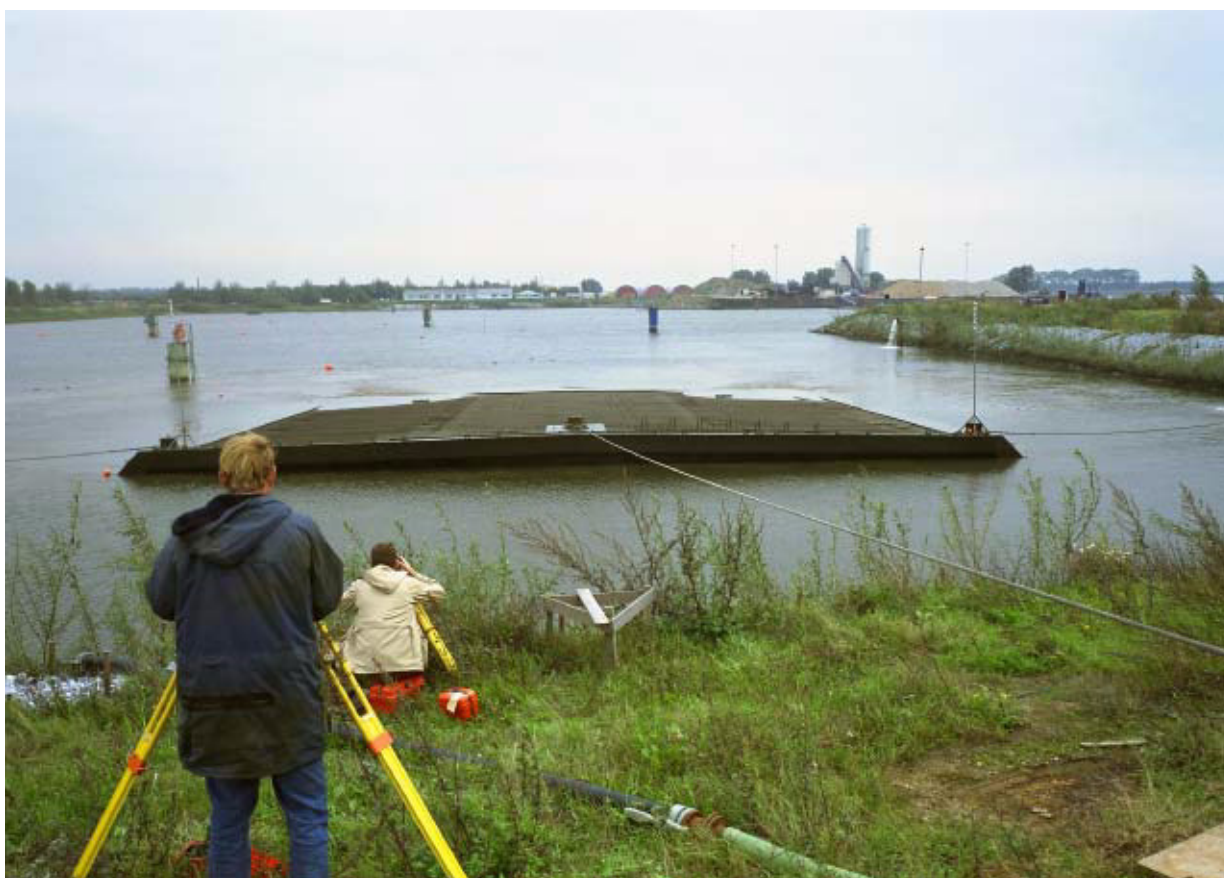
Afbeelding 8.2.10, Enkelzijdig opdrijven
