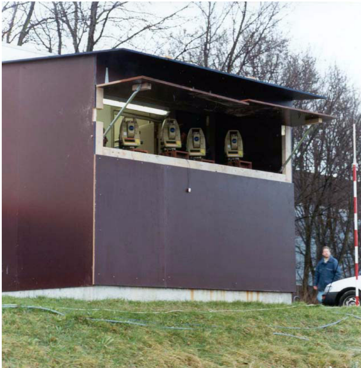
Afbeelding 8.4.12, Positiebepaling tunnelement tijdens het afzinken.
