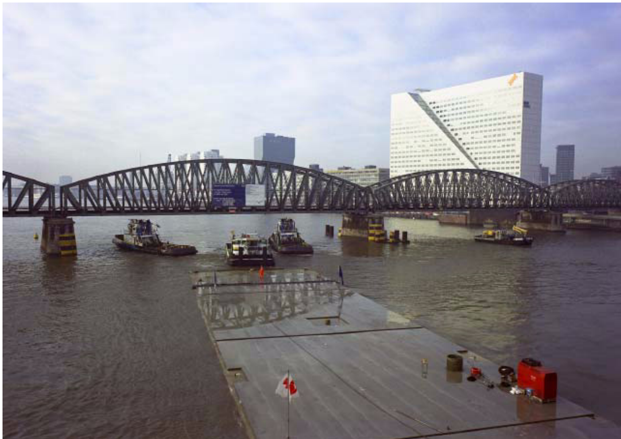
Afbeelding 8.3.7, Transport tunnelement bij passage van een brug.
