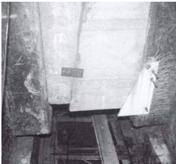
Afbeelding 8.6.1, Sluitvoeg.
