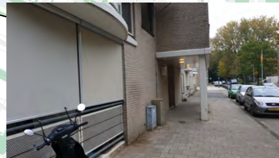
Veel dichte ramen op de begane grond. Gebouw functoneert door de positie als een muur tussen Carnisse en Carnisse Eiland. Gebouw bestaat uit 4 bouwlagen
