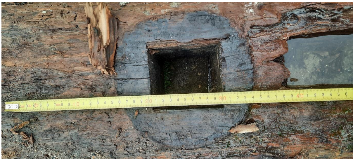
Figuur 4.4 Sloof met gaten (boven in geheel, onder detail van vierkant gat met paalafdruk)
