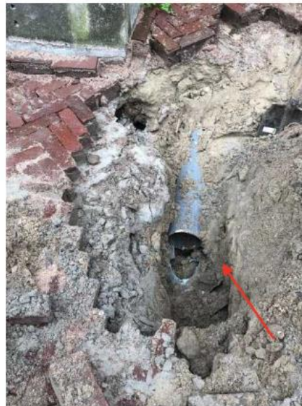
Foto 10: Afgebroken hemelwaterafvoer.
