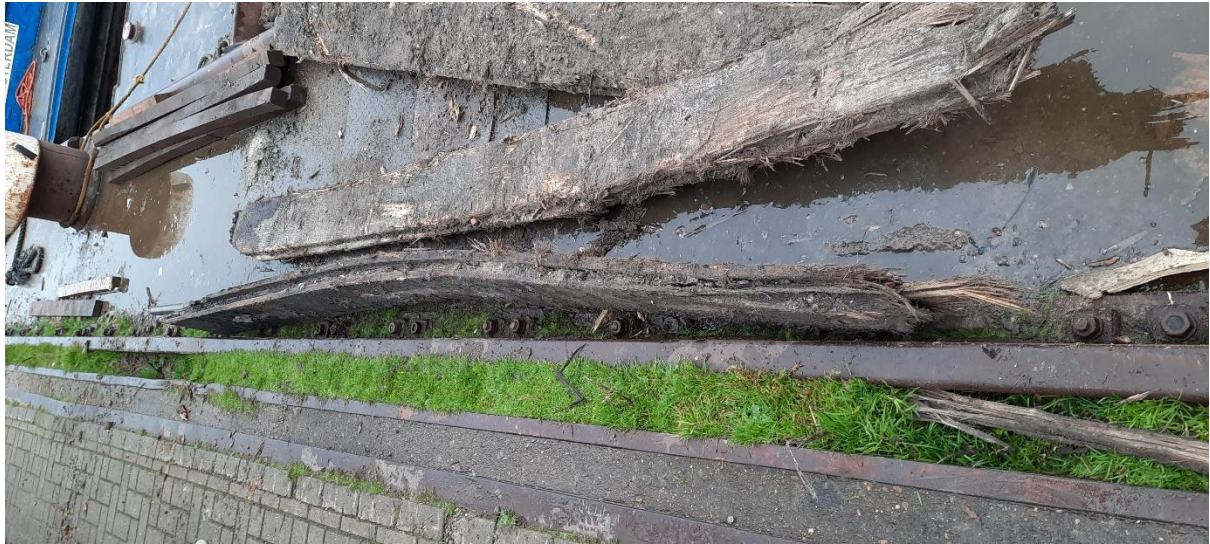
Figuur 4.6 Planken damwandscherm
