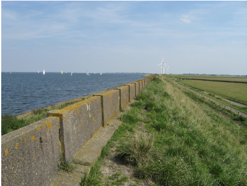
Figuur 3.1: Muraltmuur op Noord-Beveland
