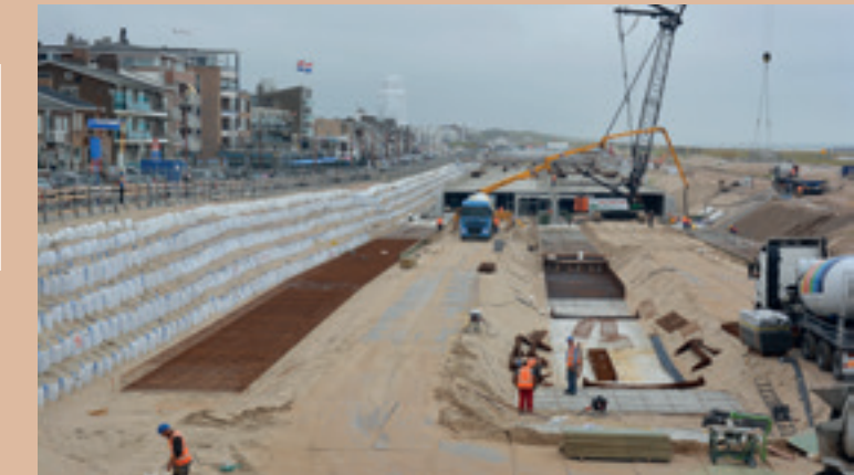
Figure 2 (below). Parking garage in dune Katwijk (Courtesy RWS beeldbank, Maarten van Rijn).
