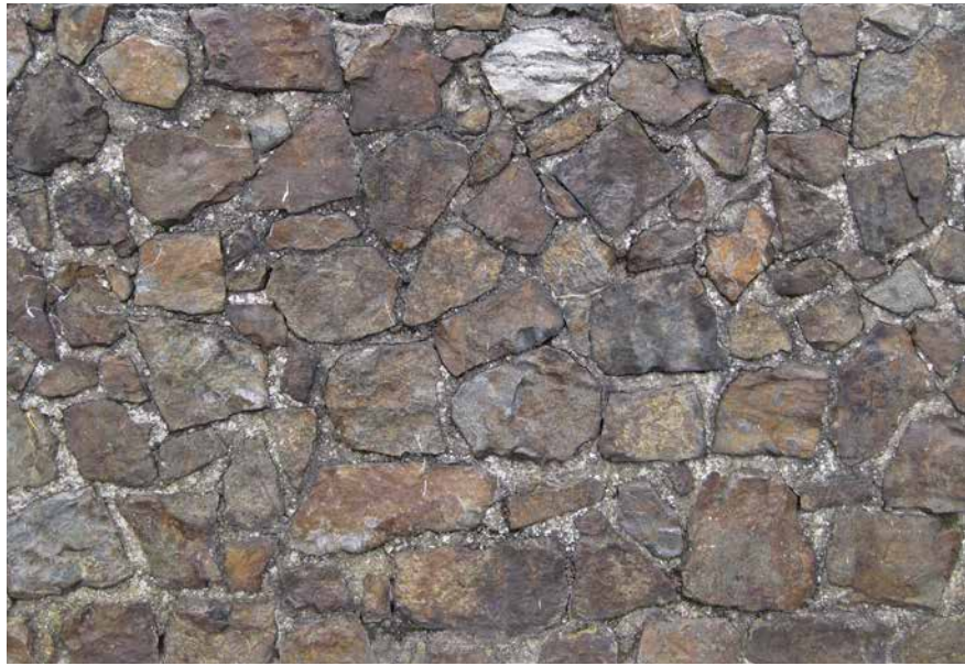
F.05 Keermuur bij voormalig hotel Britannia, Vlissingen (P.G. Quist 2017).
