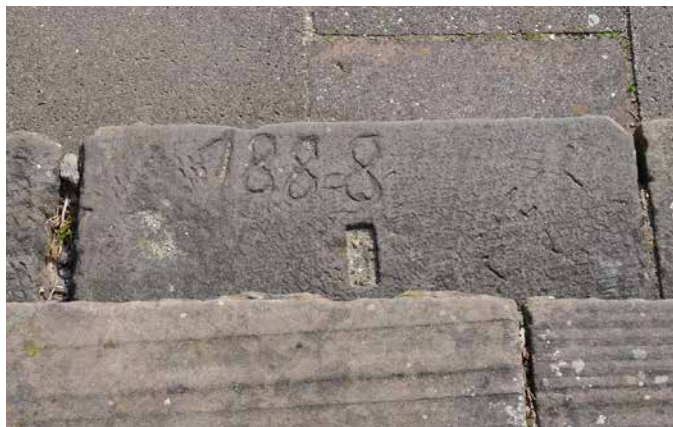
F.08 Maulbronner zandsteen op de Eerebegraafplaats Bloemendaal met (borderel)nummer van de oorspronkelijke toepassing; het Groot Museum op de Veluwe (W.J. Quist 2017).
