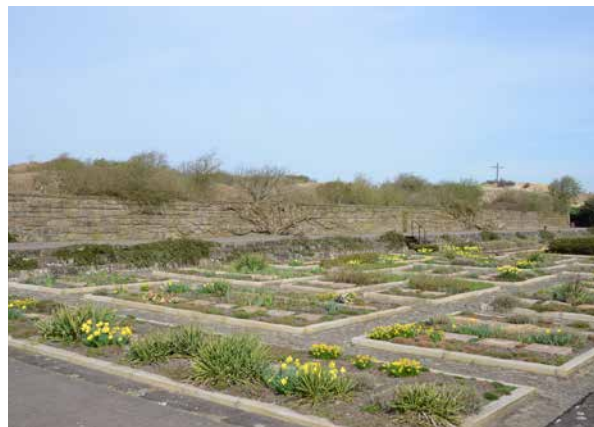
F.09 Eerebegraafplaats Bloemendaal met kolenzandsteen als plaveisel, Maulbronner zandsteen voor de muren, een gelige zandsteen voor de perken en travertijn voor de gedenkplaten (W.J. Quist 2017).
