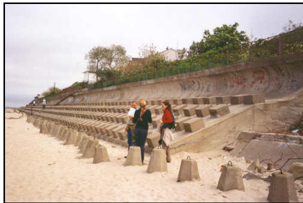
Fig. 1.13. New seawall in Dziwnow
