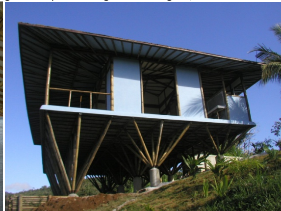
Fig. 85 Casa de Campo in Brazil
