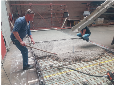
(d) Concrete casting of the floor elements.
