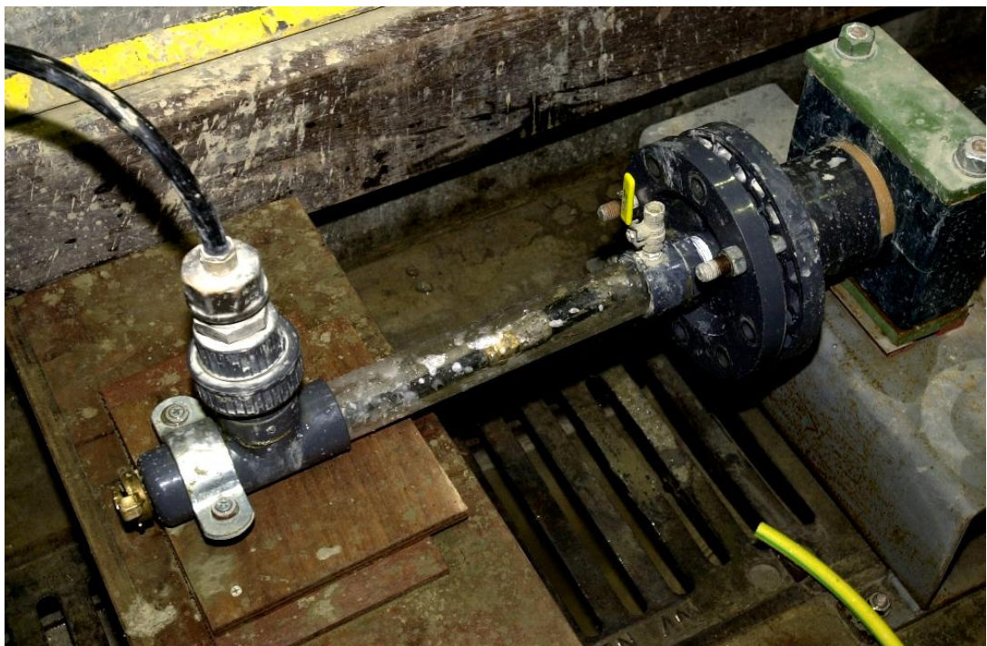
Foto 4.4 Het instroomkanaal voor het twee componenten grout
