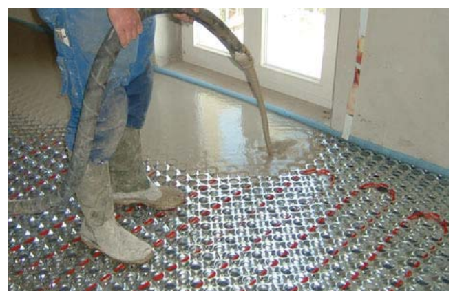
3. Pouring the concrete
