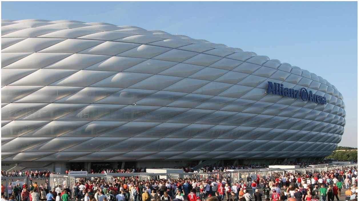
Fig. 78 Allianz Arena, Herzog & de Meuron, Munich, Germany, 2005
