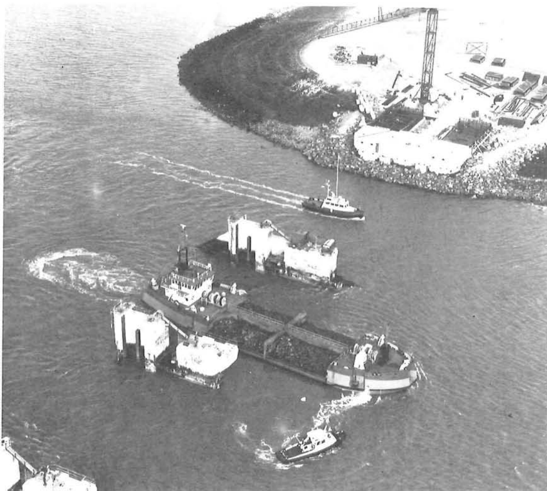
Positionering schuifstort voor aanbrengen drempelconstructie Stormvloedkering Oosterschelde.
