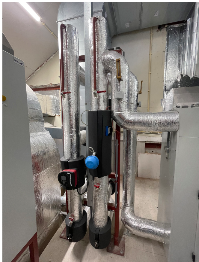
Figuur 5.3 - Aansluiting voor toekomstige koeling
