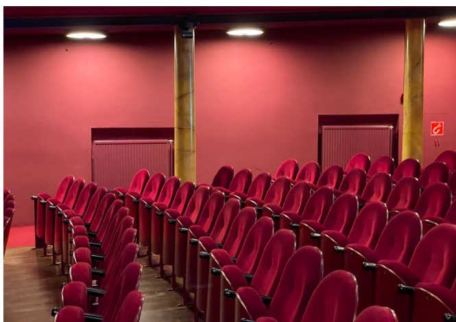
Figuur 5.3 - Radiatoren aanwezig in de zaal
