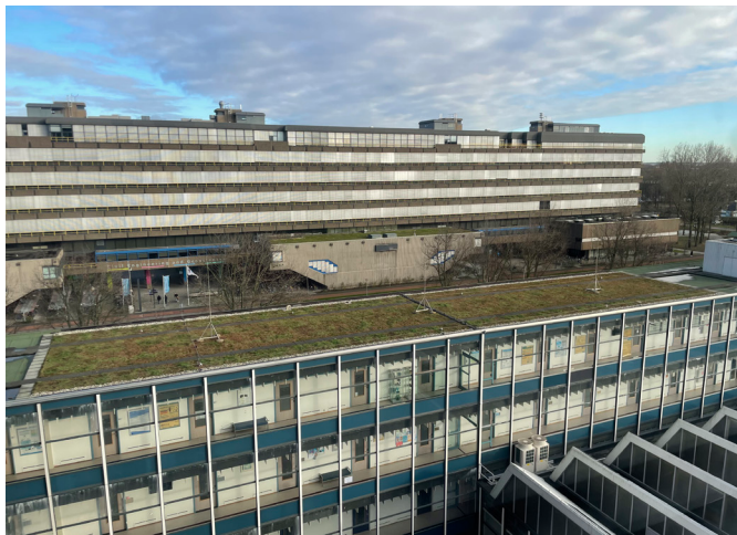
Figuur 2.6 - Groen dak op laagbouw
