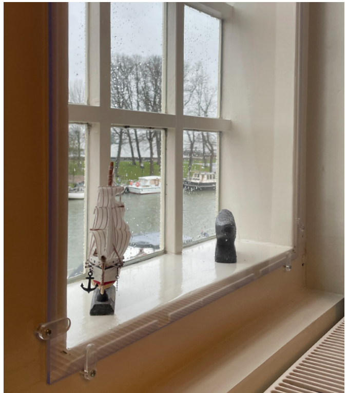
Figuur 3.3 - Achterzetramen plexiglas op de eerste verdieping
