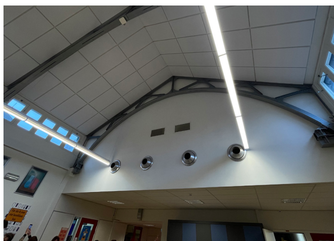
Figuur 5.4 - Plaatsing van LBK's in ruimte achter spant
