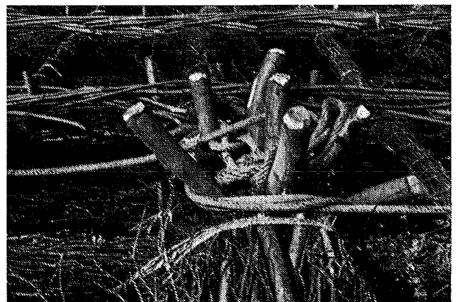
Fig. 186. Prop. Hier zijn de dwarstuinen niet aangebracht, evenals de verzwaring van de prop zittende onder de — tot het bovenroosterwerk behorende wiep. De paalafstand is hier zelfs plm. 0,70 m.
