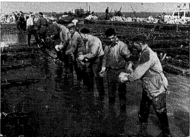
Fig. 194. Een „levende transportband” van tē kleine steen.
