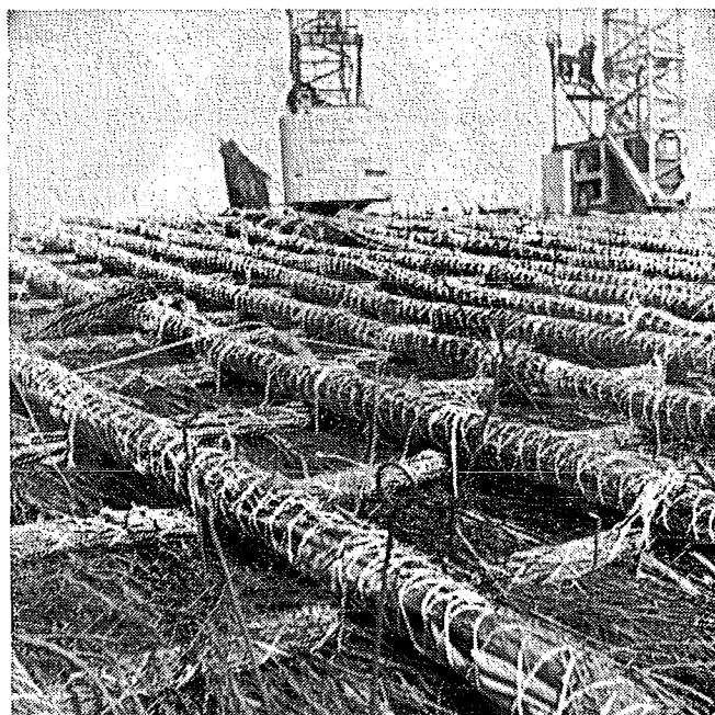
Fig. 166. Een bovenroosterwerk van normale en zwaardere wiepen, gebonden met kunststofstrengen.
