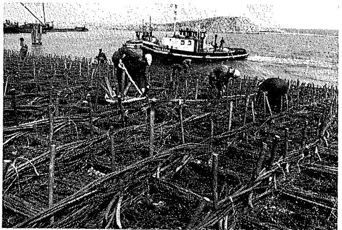
Fig. 182. Tuinen van Gelderse latten en staken, h.o.h. plm. 0,60 m. Ter plaatse van de proppen is het stuk versterkt met meerdere bossen Gelders rijs.
