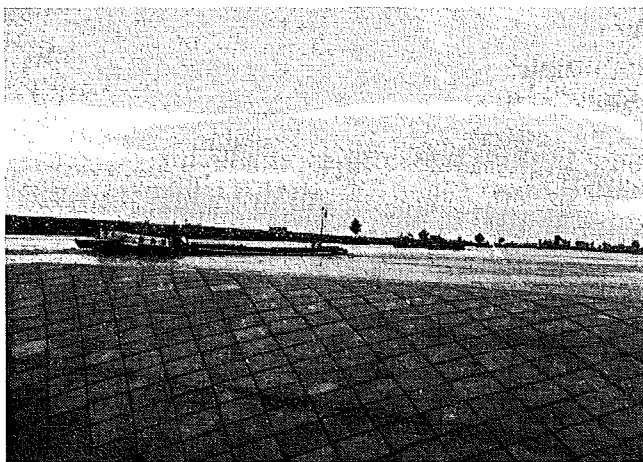
Fig. 159. Een krib afgedekt met betonblokken.
