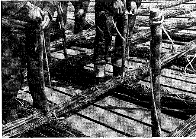
Fig. 252. De onderste wiepen rusten op de sleden.
