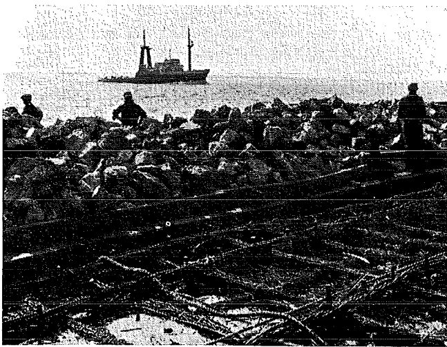
Fig. 142. Stortsteen met een z.g. stukgrootte van 10-80 kg (oftewel \pm 4-30 \text{ dm}^3 ). Zoals uit deze foto wel blijkt, komen er grotere stenen in voor. De kleine stukken worden er uitgezocht om per hand te worden doorgegeven. Het stuk moet in het midden wel het meest worden belast en zouden derhalve daar de grootste stenen dienen te komen. Het „handtransport” daarvan doet het in de praktijk echter veelal anders zijn en komen de kleinen in het midden terecht. Opgemerkt dient te worden, dat de hier als z.g. „10-80” geleverde steen wel „stijf” aan haar stukgewicht is. De grotere worden ten laatste in of nabij gangborden verwerkt. (Hierover later.)
