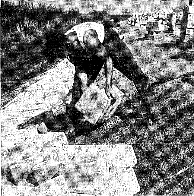
Fig. 157. Het stellen van Bever-blokken.
