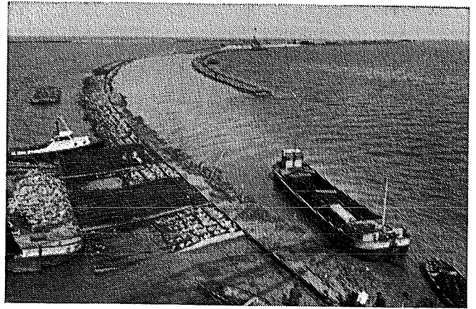
Fig. 209. Het aanbrengen van zinksteen, strooksgewijze.
