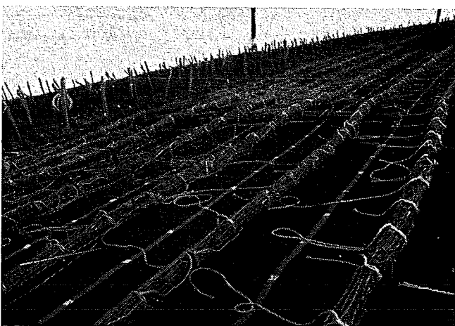
Fig. 169. Een weefsel van polyaethylenweefsel — waarop lussen ter bevestiging van de, met een kunststofstreng gebonden wiepen — voor een zinkstuk bij de Lauwerszeewerken. (Foto Nicolon).
