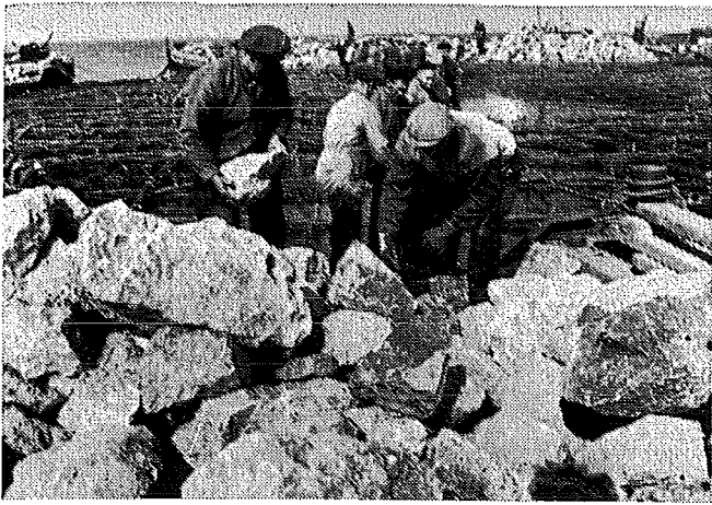
Fig. 195. Het zoeken van handbare steen uit een te zware sortering 10-80 kg of eigenlijk uit een lading stortsteen.
