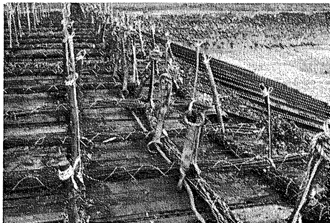
Fig. 239. De horizontale zate met het hellende, stalen gedeelte.
