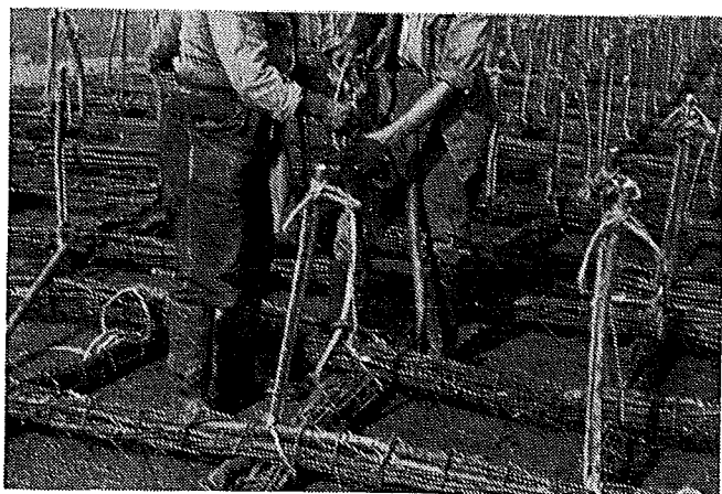
Fig. 173. Zinkstuk van Hollands rijshout, met tuinpalen h.o.h. 0,30 m, en met een prop. Doorsnede loodrecht op de richting van de stroom.
