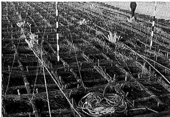
Fig. 185. Zinkstuk met proppen, langs- en dwarstuinen (van zeer beperkte hoogte). De proppen zijn gevuld met stortsteen. Het stuk ter plaatse van de proppen met bossen zwaar Gelders hout versterkt, de onderste wiep met latten. (Foto Dekker)
