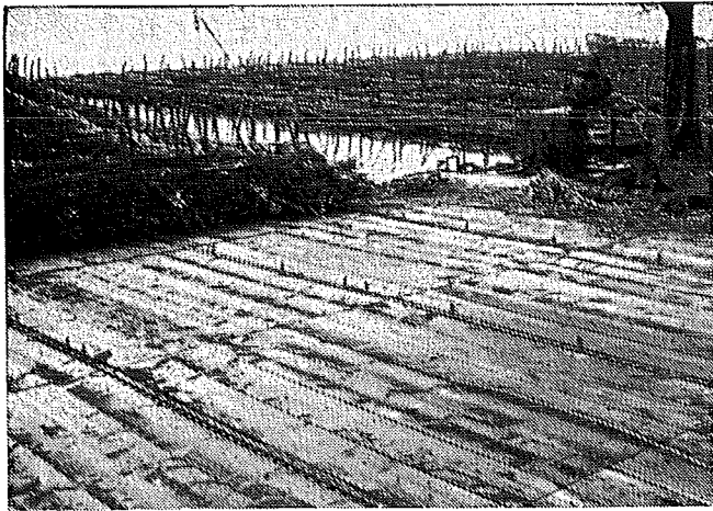
Fig. 237. De kettingzate met luiken waartussen de kettingen. De machine voor het bewegen van de doorlopende as, waarop de kettingen lopen, is waarneembaar.
