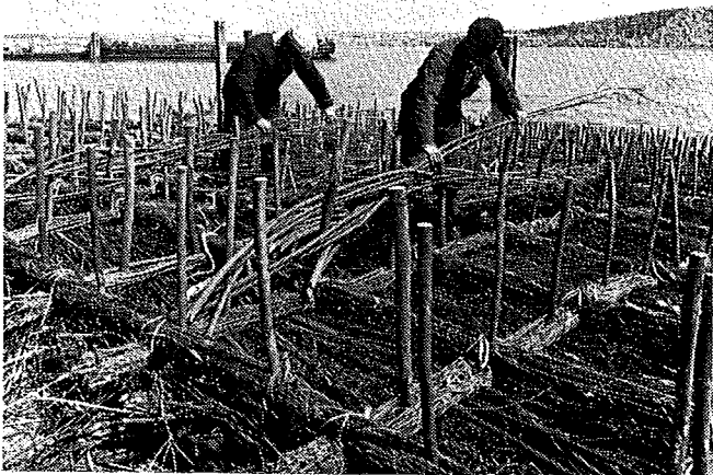
Fig. 181. Wiepen „enkel gebonden” met kunststofstrengen en voorts op de kruisingen met 4-draads sisal.
