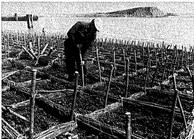
Fig. 254. De palen, lang 0,90 m, worden geplaatst op afstanden van 0,50 m, de wiepen liggen ook hier nog h.o.h. 0,90 m.
