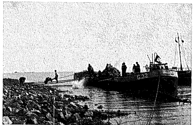
Fig. 211. Het per kruitwagen naplempen van de bestorting van een kraagstuk, waarbij de buitenrand onvoldoende was voorbelast en daardoor boven kwam. Bij het zorgvuldig, van bovenaf, nabestorten komt een dergelijk stuk toch nog wel goed op zijn plaats.
