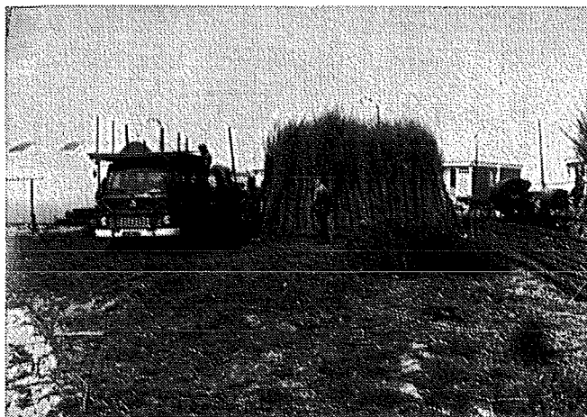
Fig. 137. Per as aangevoerd wiepenhout, wordt gelost nabij de wiepenmachine.
