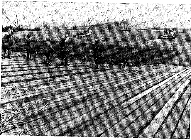
Fig. 256. Het stuk wordt door twee boten van de helling getrokken.
