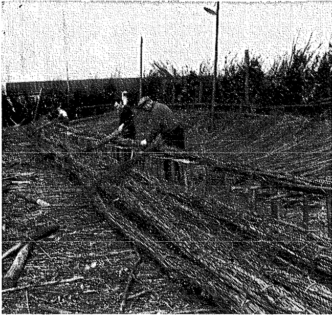
Fig. 179. Het binden van wiepen met wiepband.
