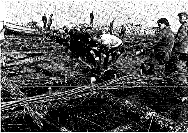
Fig. 190. Het met veel mankracht doorhalen van ankerrossen.
