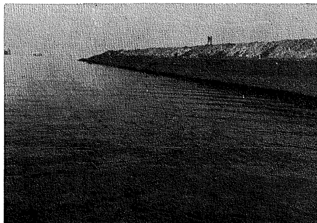
fig. 105 De uit korte basaltzuilen bestaande glooiing van het Buitenkanaal (noordzijde). (Foto J. van der Vlies).
