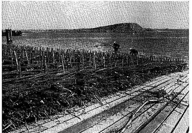
Fig. 255. Een gereedgekomen stuk met wiepen, hoog 0,18 m.
