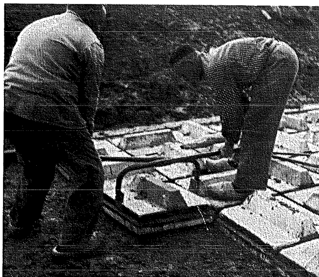
Fig. 155. Het Kant-blok wordt per tang verplaatst, deze grijpt aan in de z.g. „breeuwnaad”.
