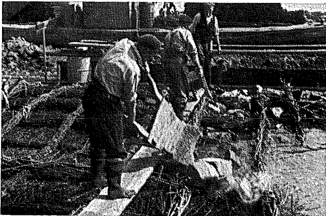
Fig. 210. Detail van het aanbrengen van steen.
