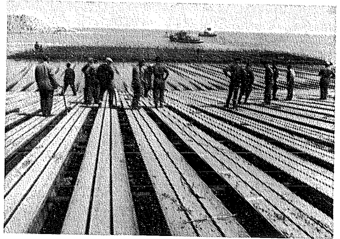
Fig. 257. Het stuk drijft, evenals de achterblijvende sleden.
