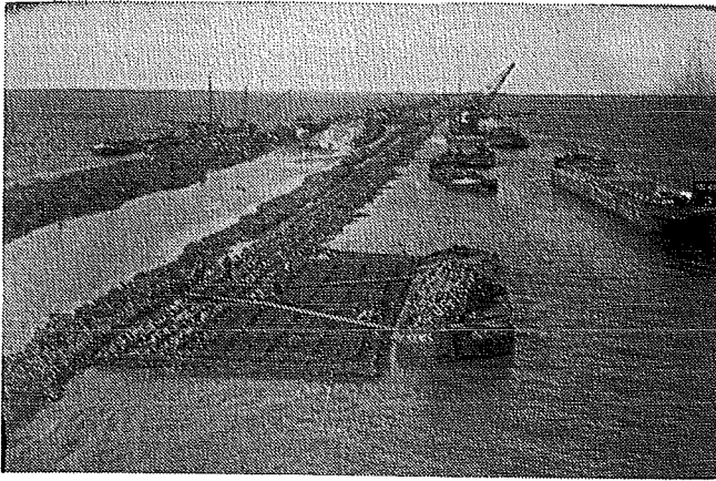
Fig. 208. Het aanbrengen van zinksteen per kruitwagen op een kraagstuk, met op de achtergrond het nastorten per kraan.
