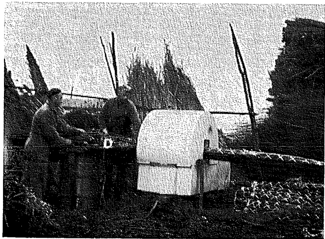
Fig. 228. Het invoeren van hout ten behoeve van een wiep met een enkele winding.
