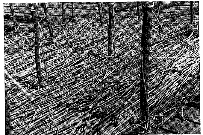
Fig. 178. Riet (Hollands) als eerste laag.
