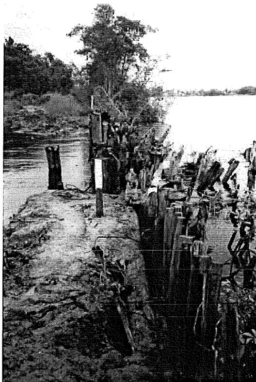
Fig.: 23 Commewijne-rivier - Mon Tresor. Doordoorbraak. Tot nu toe is het niet gelukt het gat in de dijk te dichten.
