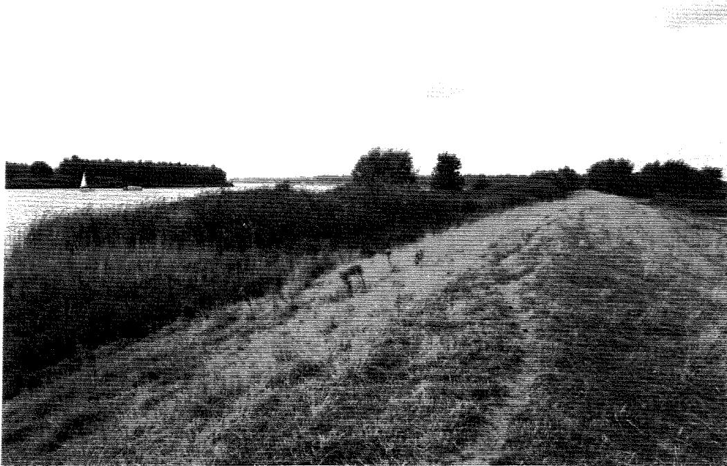
FOTO: Dijk in de Biesbosch ter hoogte van het spaarbekken Petrusplaat
