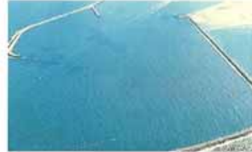
De havenmond van IJmuiden. Grote hoeveelheden zand hoopt zich op aan weerszijde van de havenhoofden. Op andere plaatsen werd erosie aan de onderwateroever geconstateerd.
